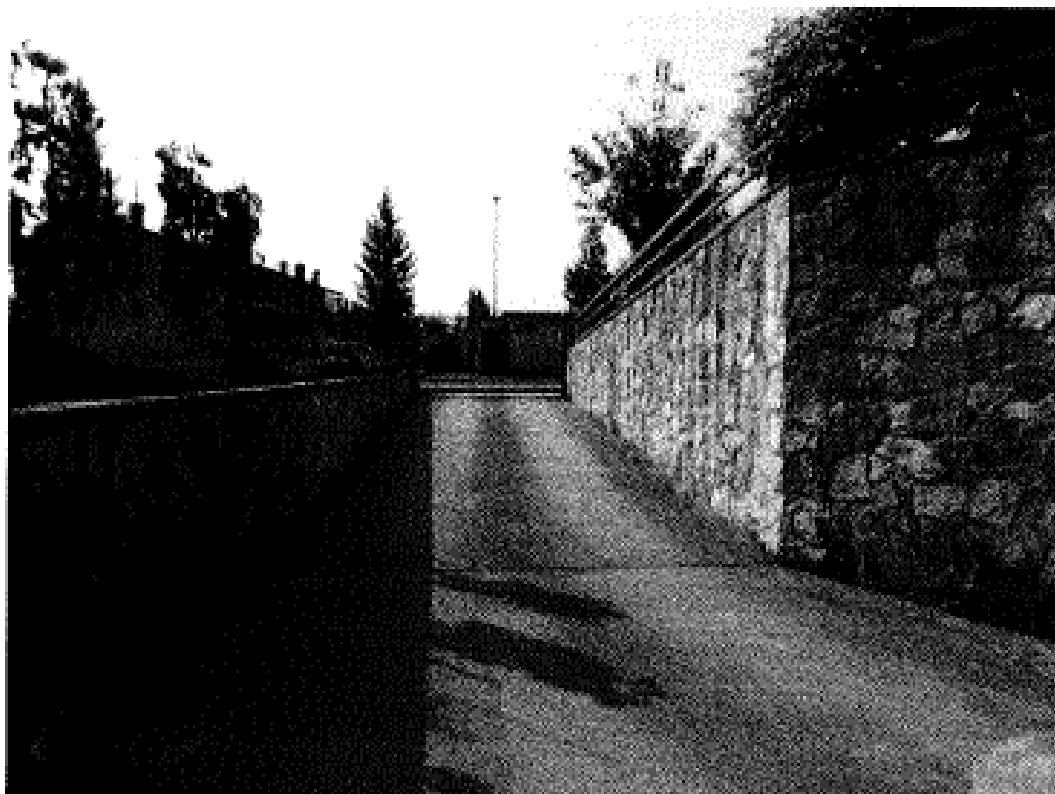
41) Il corsello scoperto di accesso all'autorimessa ed al box auto
