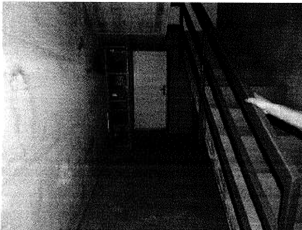
35) Il sottoscala a piano interrato
