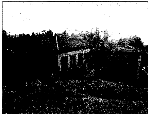
Vista ovest del fabbricato
