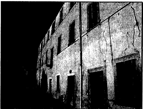
Prospetto sud-est del fabbricato principale
