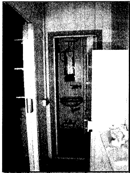
Negoziò al piano terra (sub. 711) – bagno e antibagno
