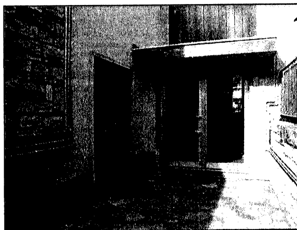
Ingresso all'unità immobiliare (a sinistra) ed al vano scala condominiale (a destra)
