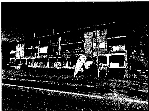
Vista da Google Maps del prospetto est del fabbricato
