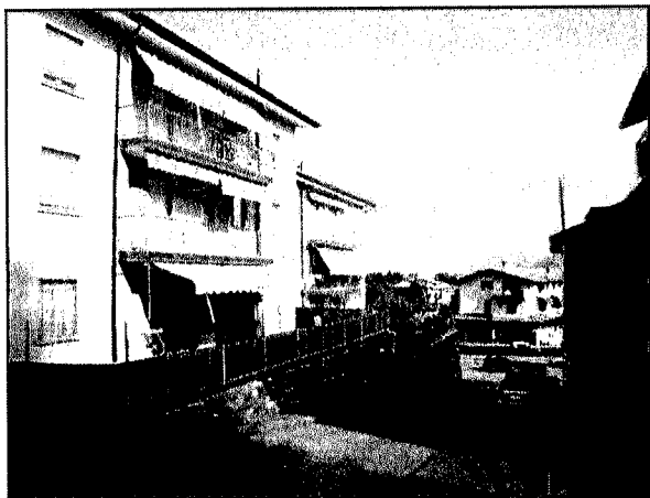
Prospetto sud su via Carletti
