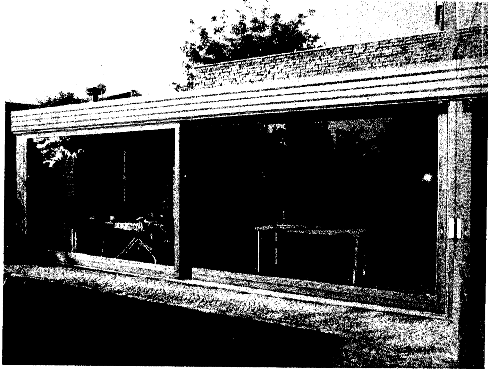
11. Esterno: prospetto Est - veranda
