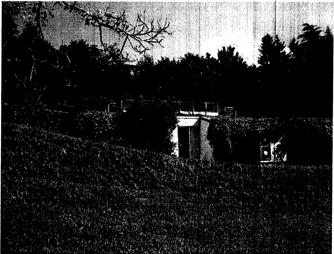
Foto n. 28 - locali tecnici interrati
