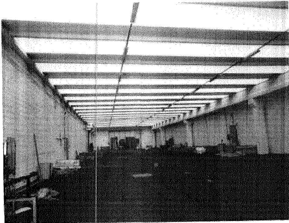
SUB. 709 INTERNO CAPANNONE PIANO TERRA
