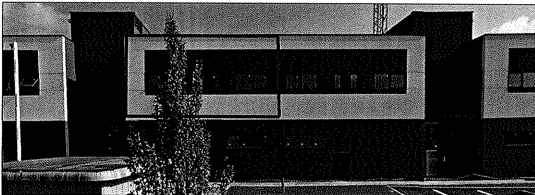
Unità immobiliare a destinazione terziario
