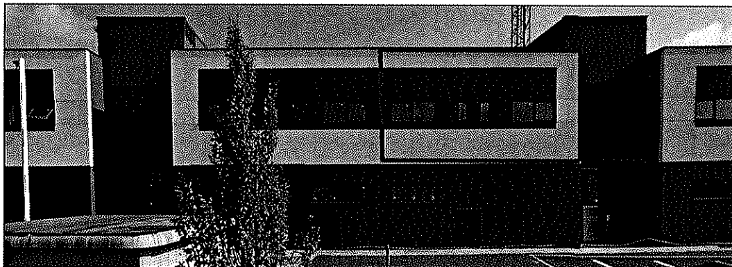
Unità immobiliare a destinazione terziario
