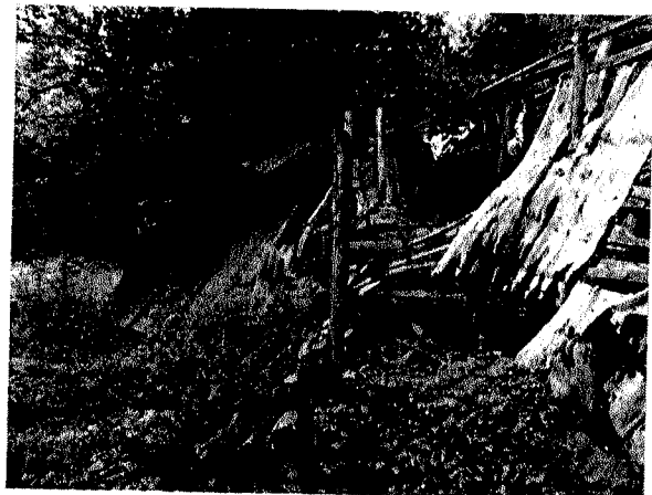
Tettoia semi crollata
