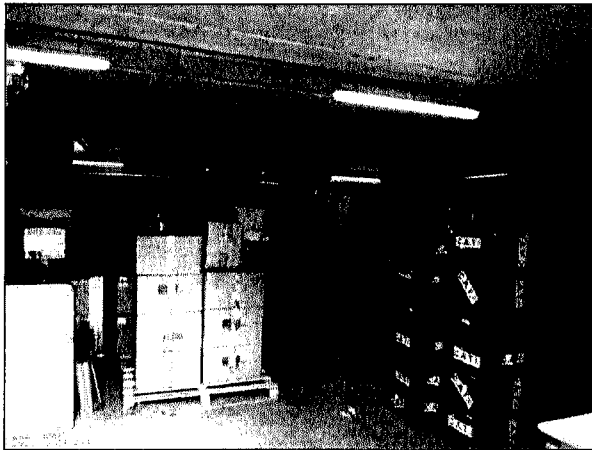
33 Piano interrato deposito parcheggio
