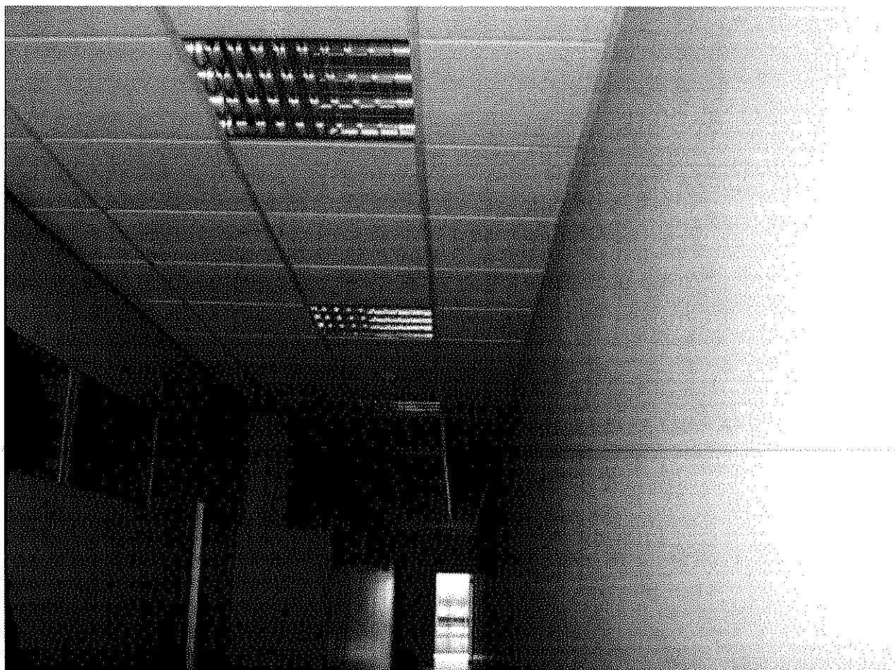
P. PRIMO CONTROSOFFITTO
