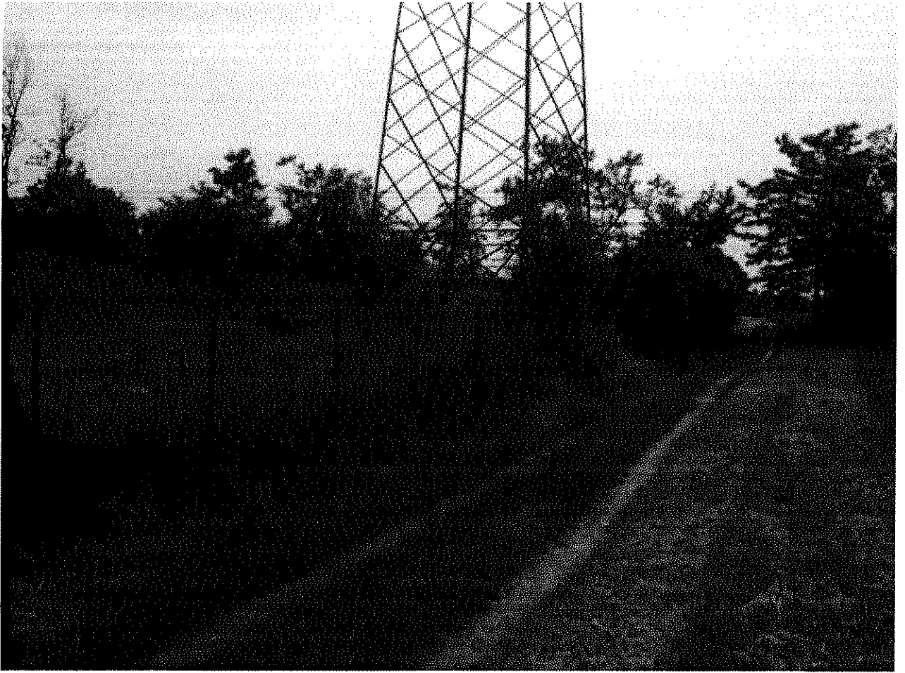
LATO NORD E TRALICCIO ENEL
