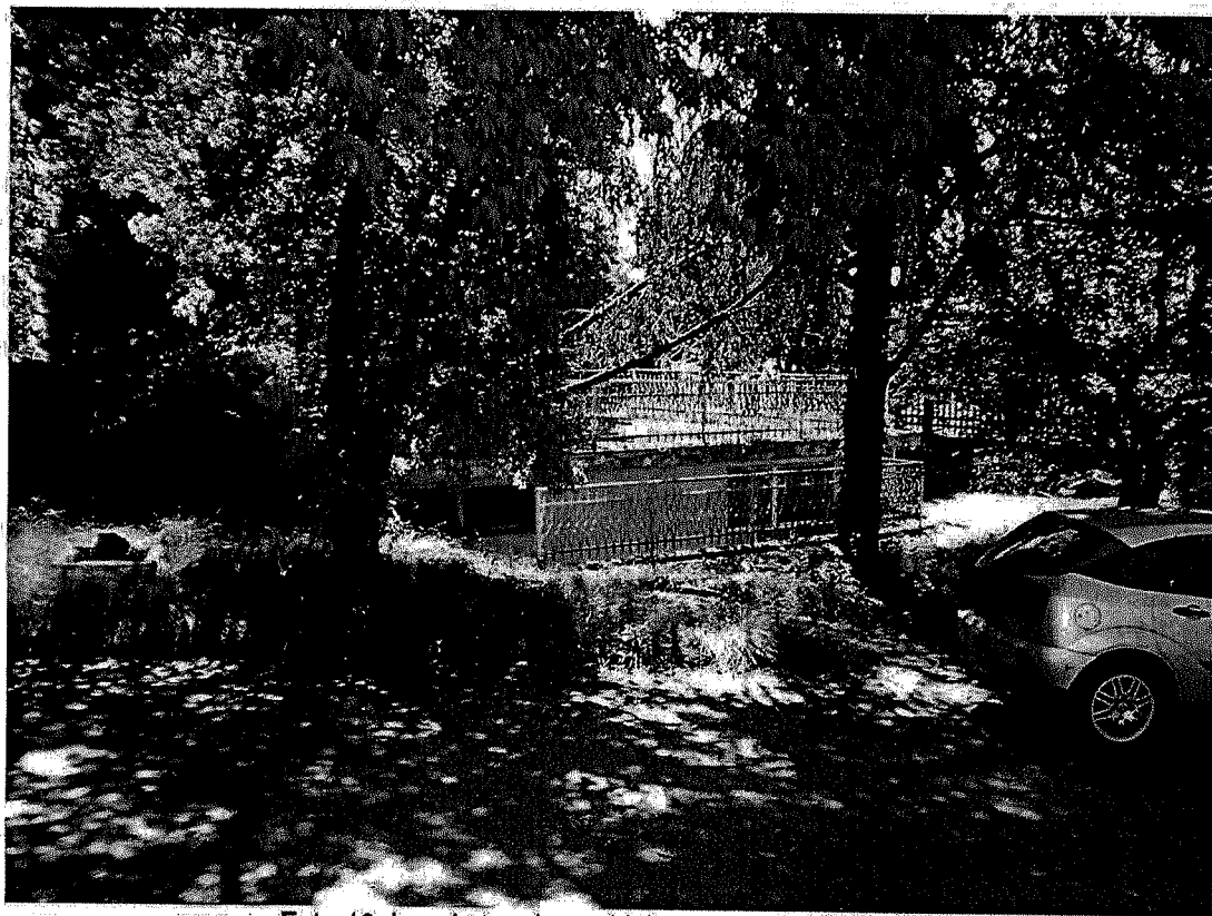
Foto 16. Locale tecnico caldaia, accesso dal giardino
