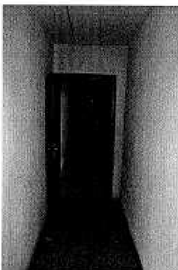
corridoio di accesso al magazzino
