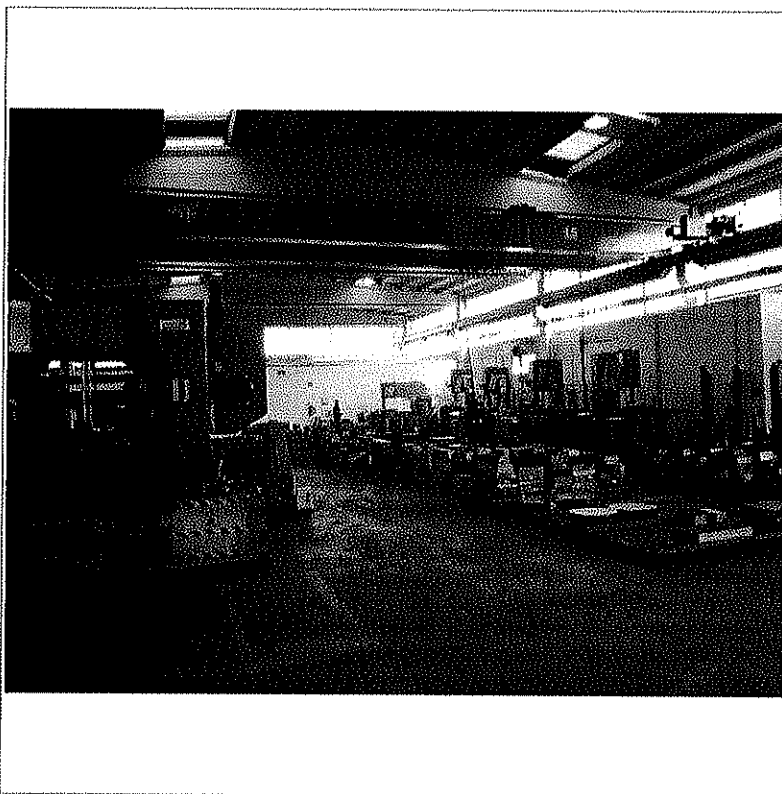
- Capannone principale - Interno -
