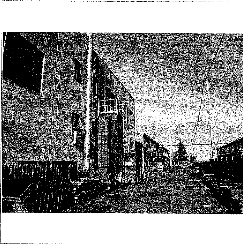
- Complesso immobiliare industriale - Fronte est e area libera di pertinenza -
