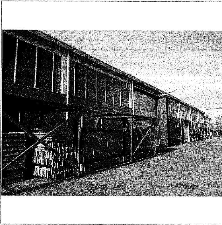
- Capannone principale - Fronte est -
