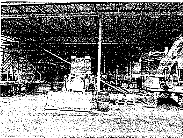
3° TETTOIA - VISTA DAL PIAZZALE
