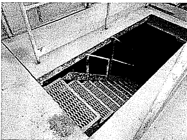
STABILIMENTO - ACCESSO AI VANI INTERRATI
