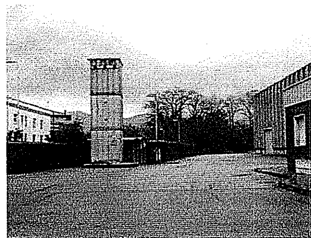
PIAZZALE OVEST E CABINA ELETTRICA
