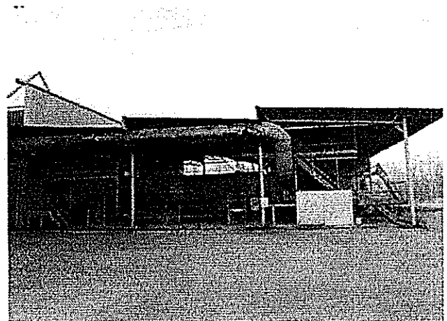
FACCIATA EST - PARTICOLARE 3° TETTOIA
