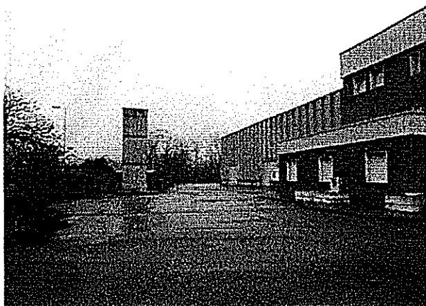
PAZZALE OVEST - PARTICOLARE CABINA ELETTRICA
