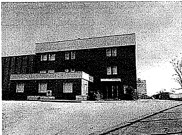
FACCIATA OVEST - IN PRIMO PIANO LA PALAZZINA UFFICI
