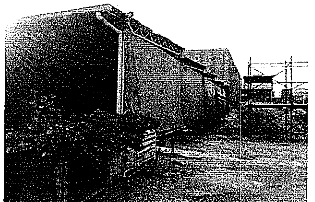
5° TETTOIA - VISTA DAL PIAZZALE
