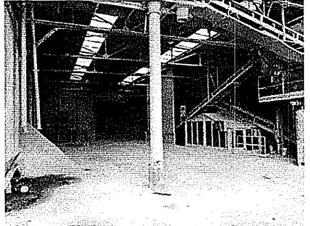
1° TETTOIA - VISTA INTERNA
