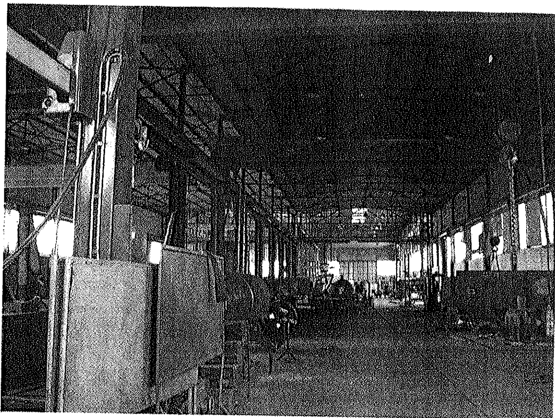
Foto n. 3 – Vista interna del capannone industriale
