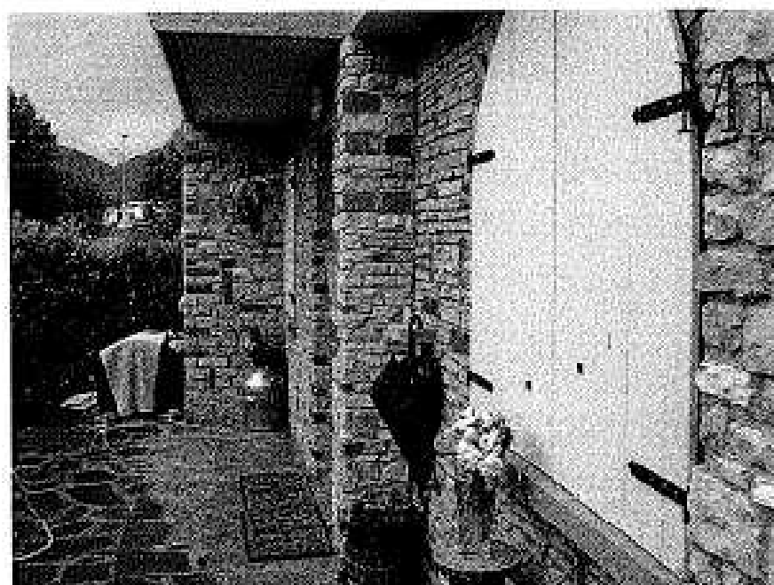
8. Area cortilizia verso strada;
