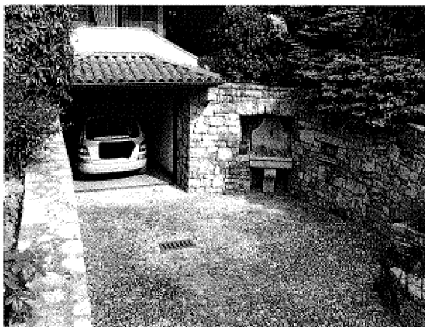
11. Accesso carrale autorimessa;
