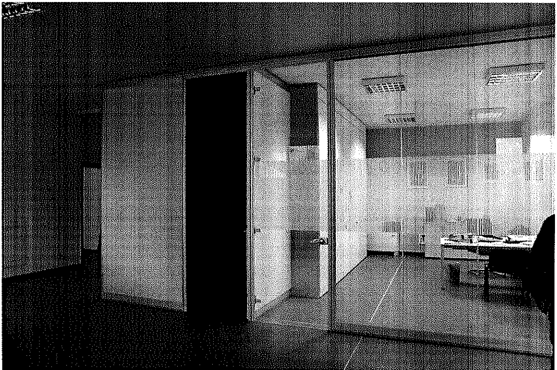
18. i pannelli mobili in legno e in vetro con cui è partizionato l'ufficio al p. 1°
