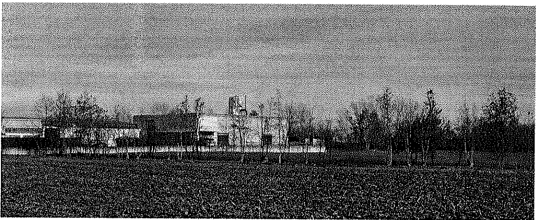
Foto2: Vista da strada da ovest
