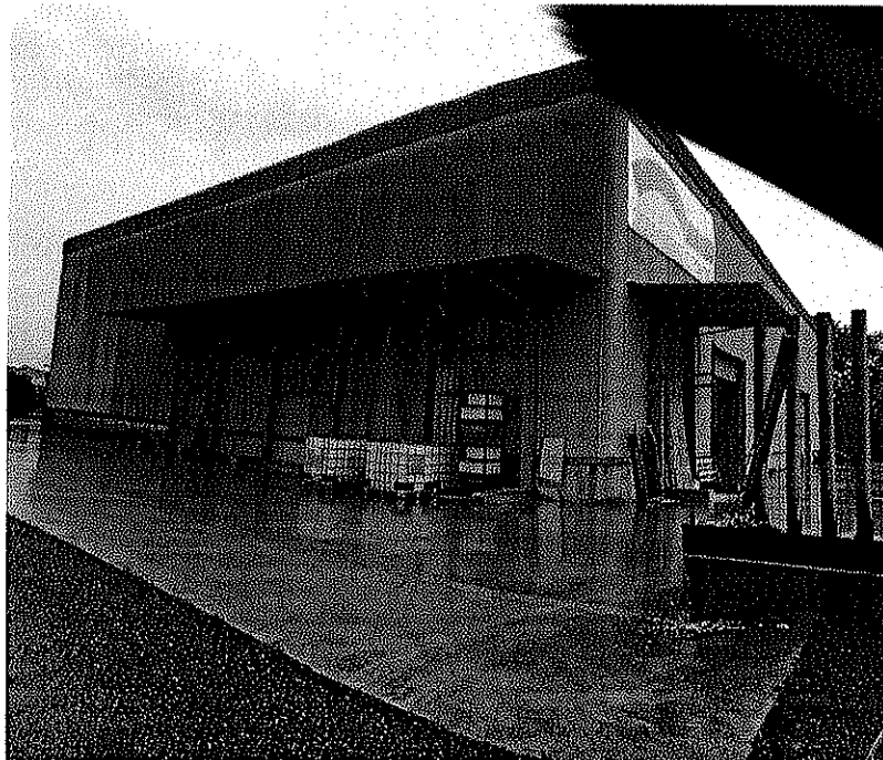
Foto4: Vista dell'edificio e del piazzale da sud
