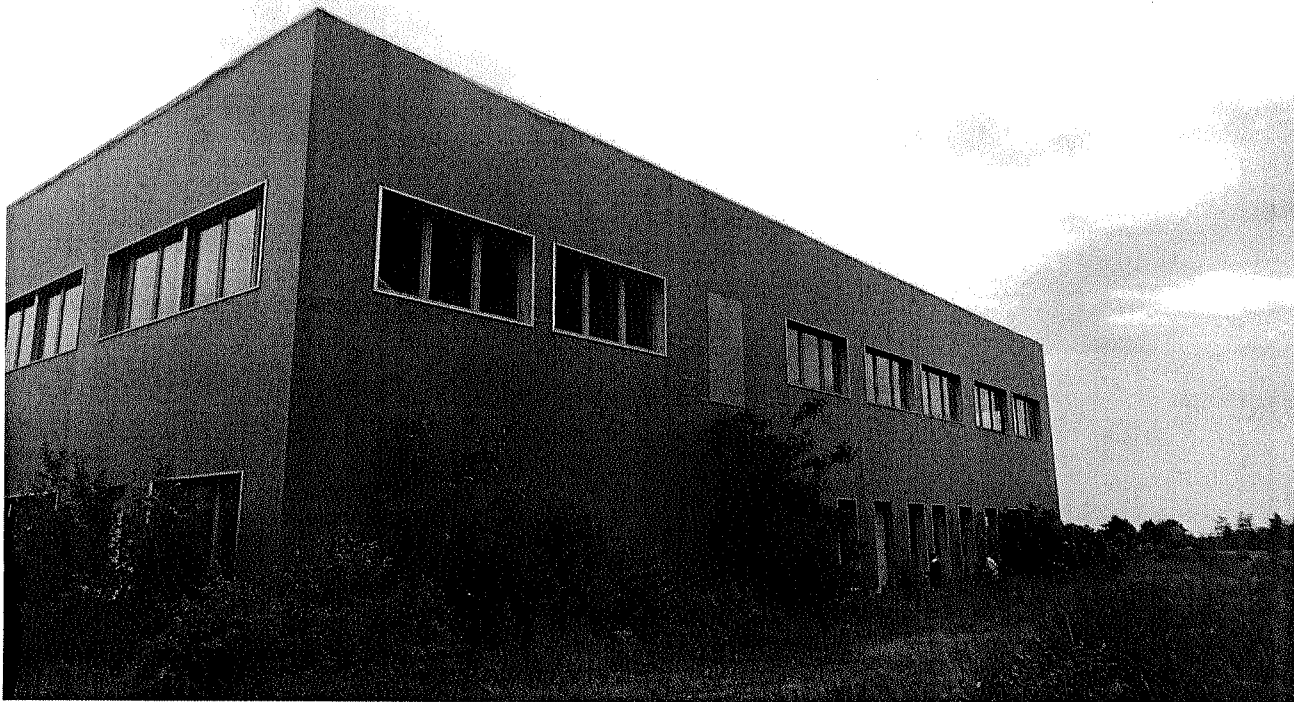
Foto n. 7 - vista del fabbricato - lato ovest
