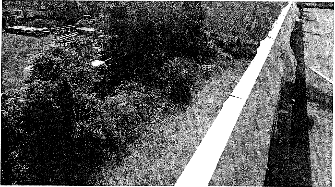
Foto n. 19 - vista recinzione lato est
