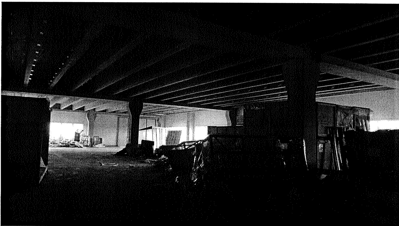
Foto n. 8 - vista dell'interno a piano terra
