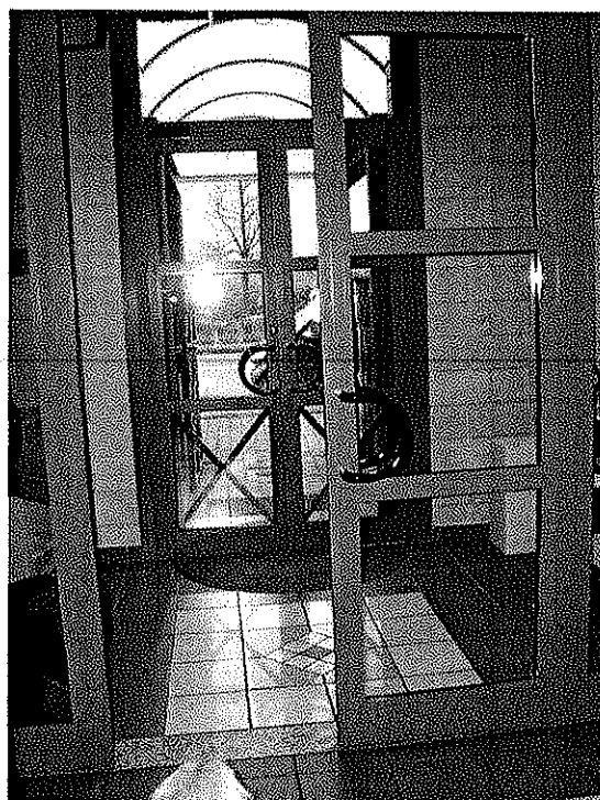
FOTO 32 – particolare ingresso pedonale - interno
