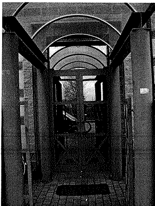
FOTO 31 –ingresso pedonale - particolare
