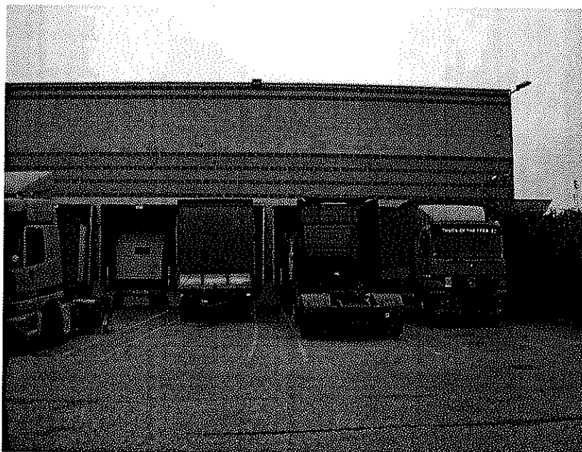
FOTO 13 – capannone con accessi carico-scarico
