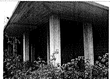
La club house in costruzione
