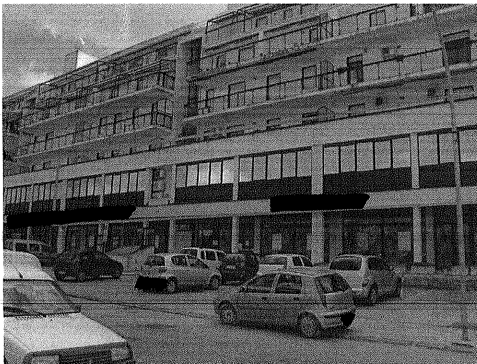
Foto n. 2 – Gli uffici al primo piano
