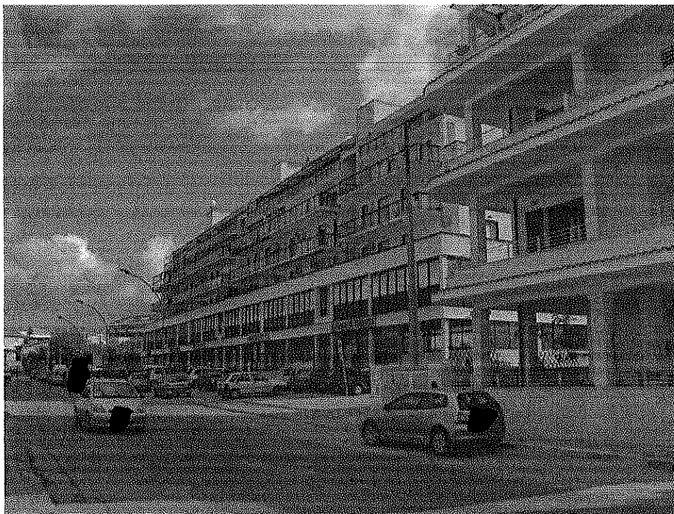
Foto n. 1 – L'edificio visto da via don Minzoni
