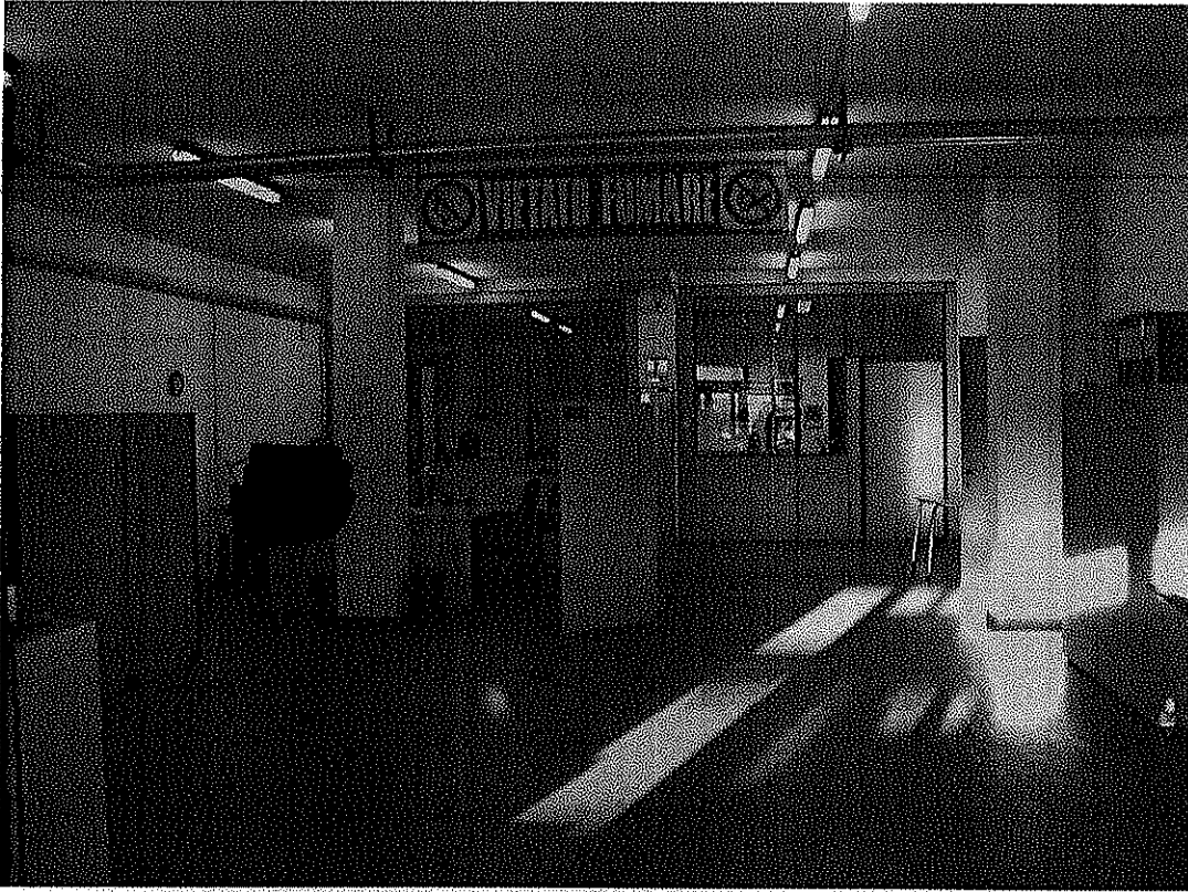
FOTO n° 3 - Interno dei locali al piano interrato
