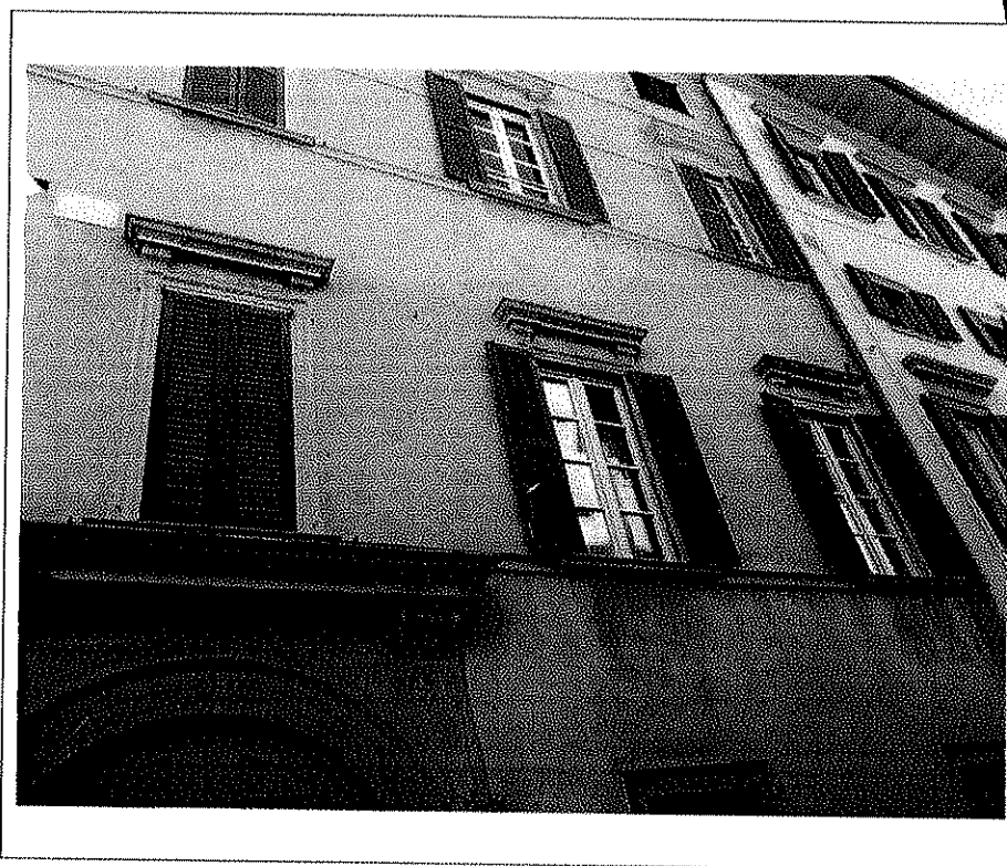
- Foto n°22 - Lotto 5: Appartamento di cui al mapp. 1428/705; prospetto Nord -Ovest su Via San Tomaso -
