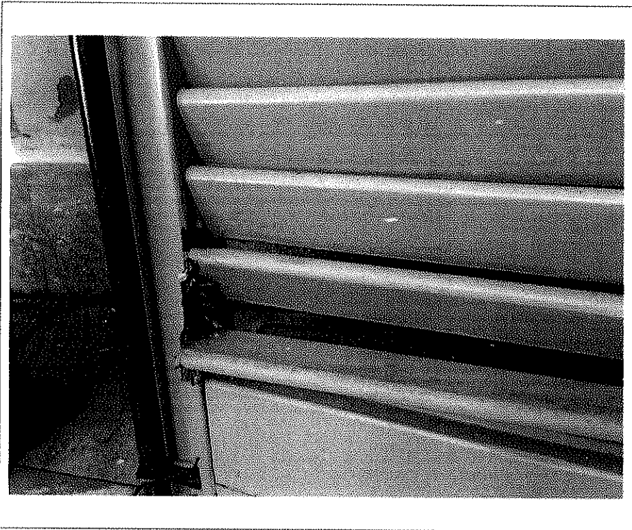
- Foto n°26 - alloggio di cui al mapp. 1428/703 (Lotto 3) foto del 30/06/2014 scattata da inquilino alla presenza di ing. Maccario: persiana portafinestra ingresso marcita per assorbimento acqua piovana -
