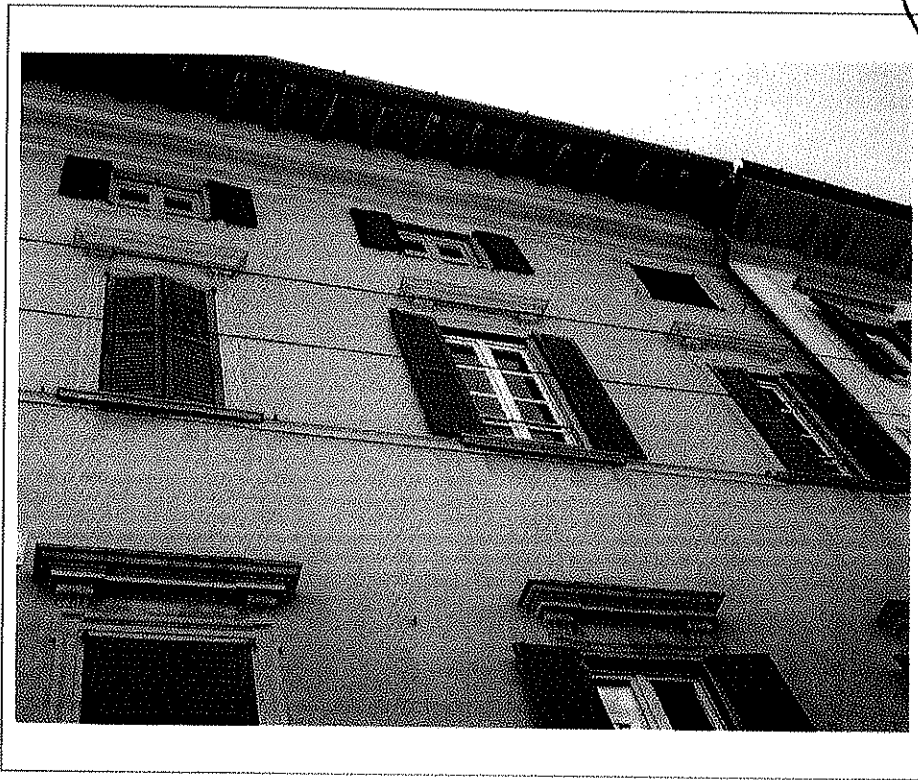
- Foto n°32 - Lotto 8: Appartamento di cui al mapp. 1428/708; prospetto Nord -Ovest su Via San Tomaso -
