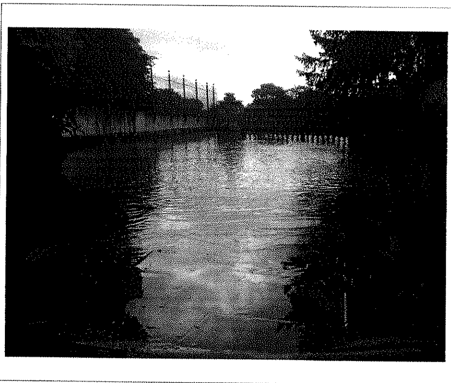
- Foto n°10 - terrazza comune di cui al mapp. 1428/717 foto del 17/05/2013 fornita da inquilino del mapp.1428/703: allagamento dopo chiusura vano corsa montacarichi -
