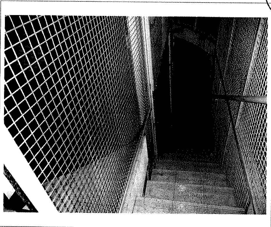
- Foto n°50 - Lotti da 1 a 11: autorimessa interrata comune in corso di costruzione accesso al piano II° interrato di cui al mapp. 1428/717 -
