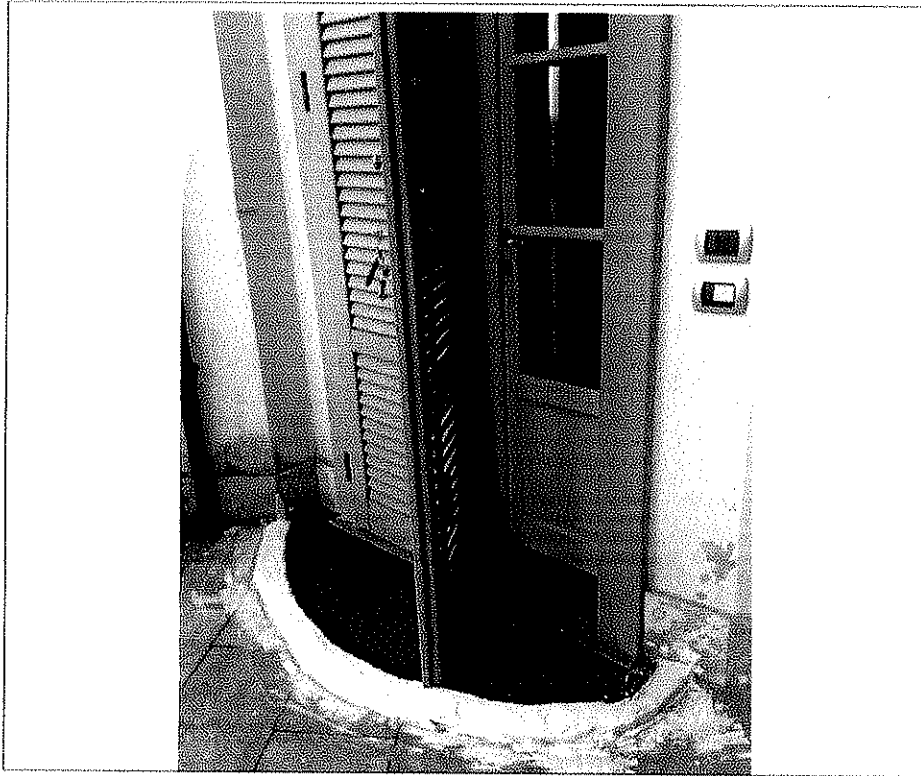
- Foto n°25 - alloggio di cui al mapp. 1428/703 (Lotto 3) foto del 15/03/2014 fornita da inquilino: ricerca infiltrazioni da soglia ingresso -
