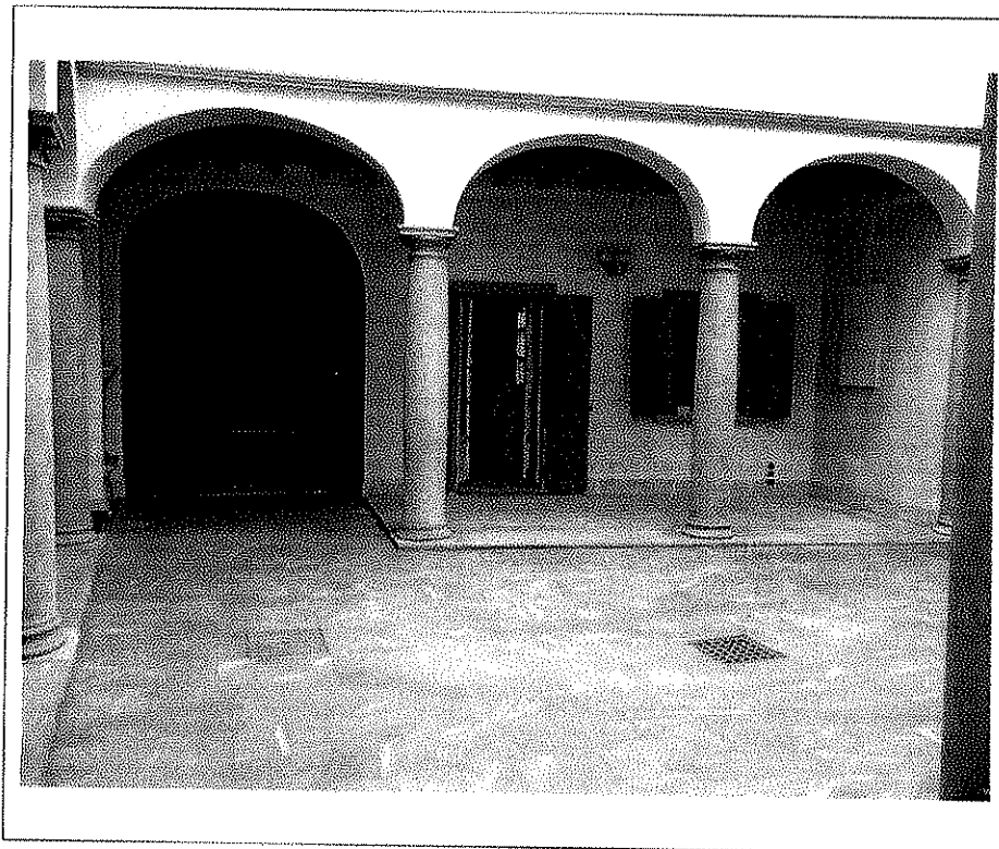
- Foto n°06 - Lotto 1: Appartamento di cui al mapp. 1428/701; prospetto Sud - Est su corte interna comune -
