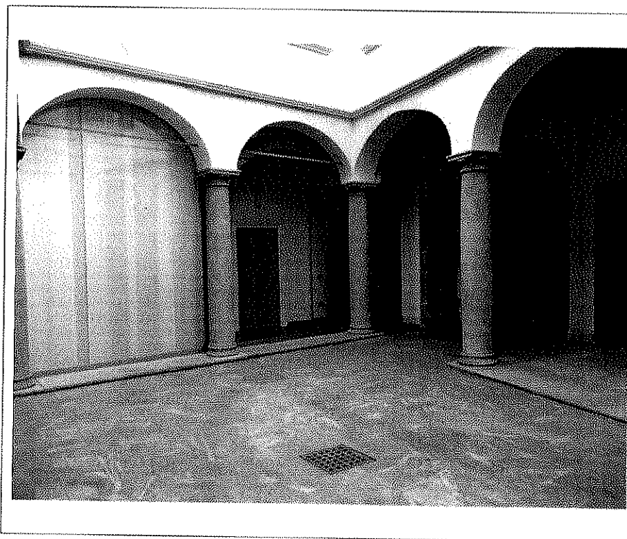
- Foto n°16 - Lotto 3: Appartamento di cui al mapp. 1428/703; prospetto su corte interna comune -
