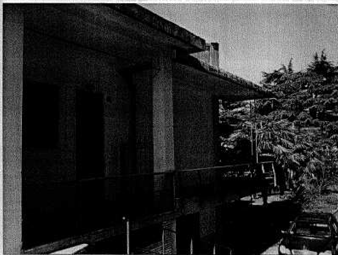
BALCONE LATO NORD
