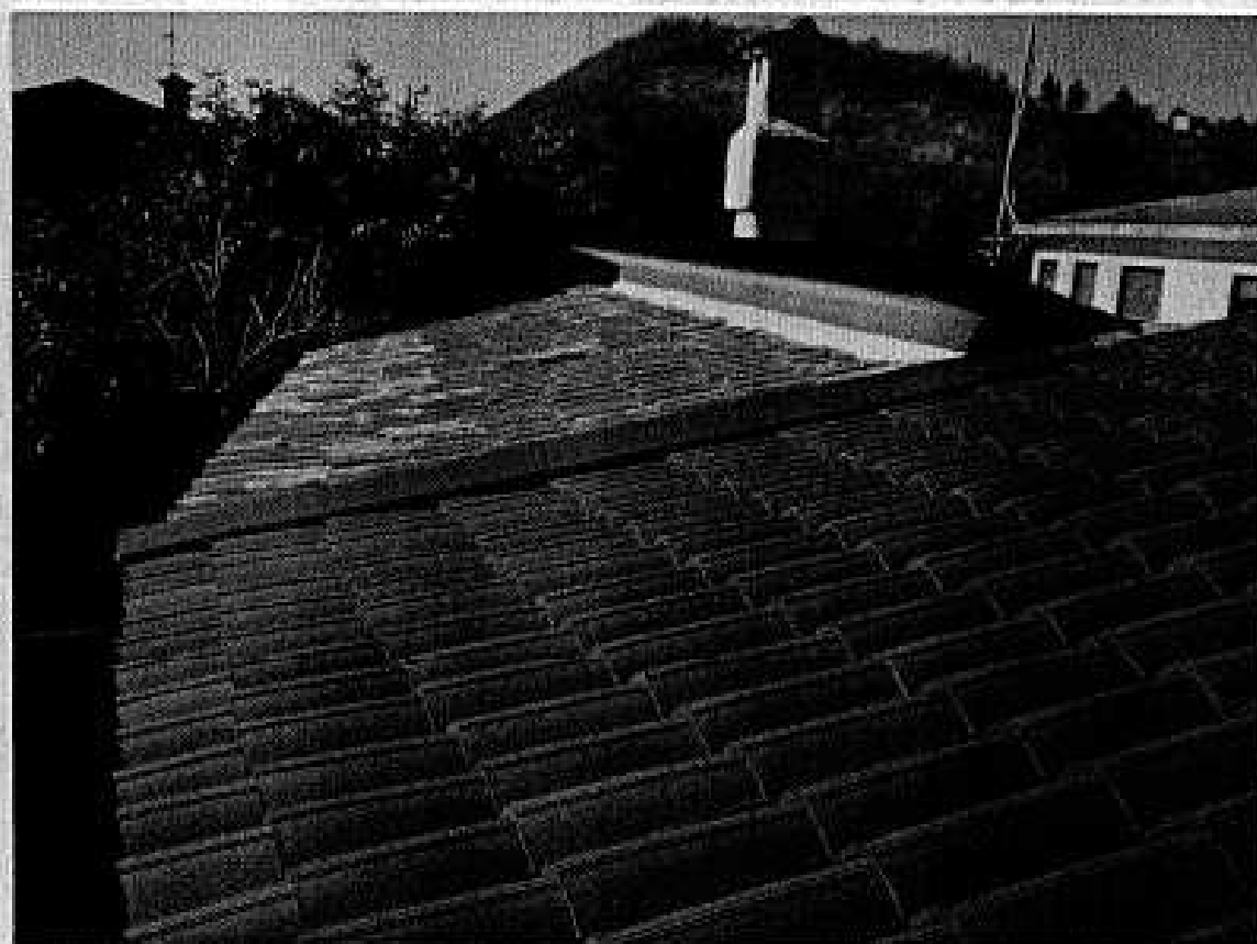
TETO TAVERNA (E TETO AMPLIAMENTO ABUSIVO)
