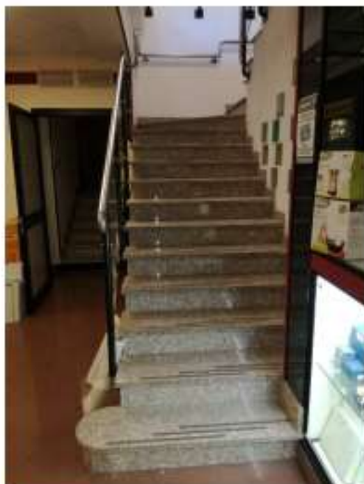
SCALA INTERNA DI COLLEGAMENTO (p.S1)
