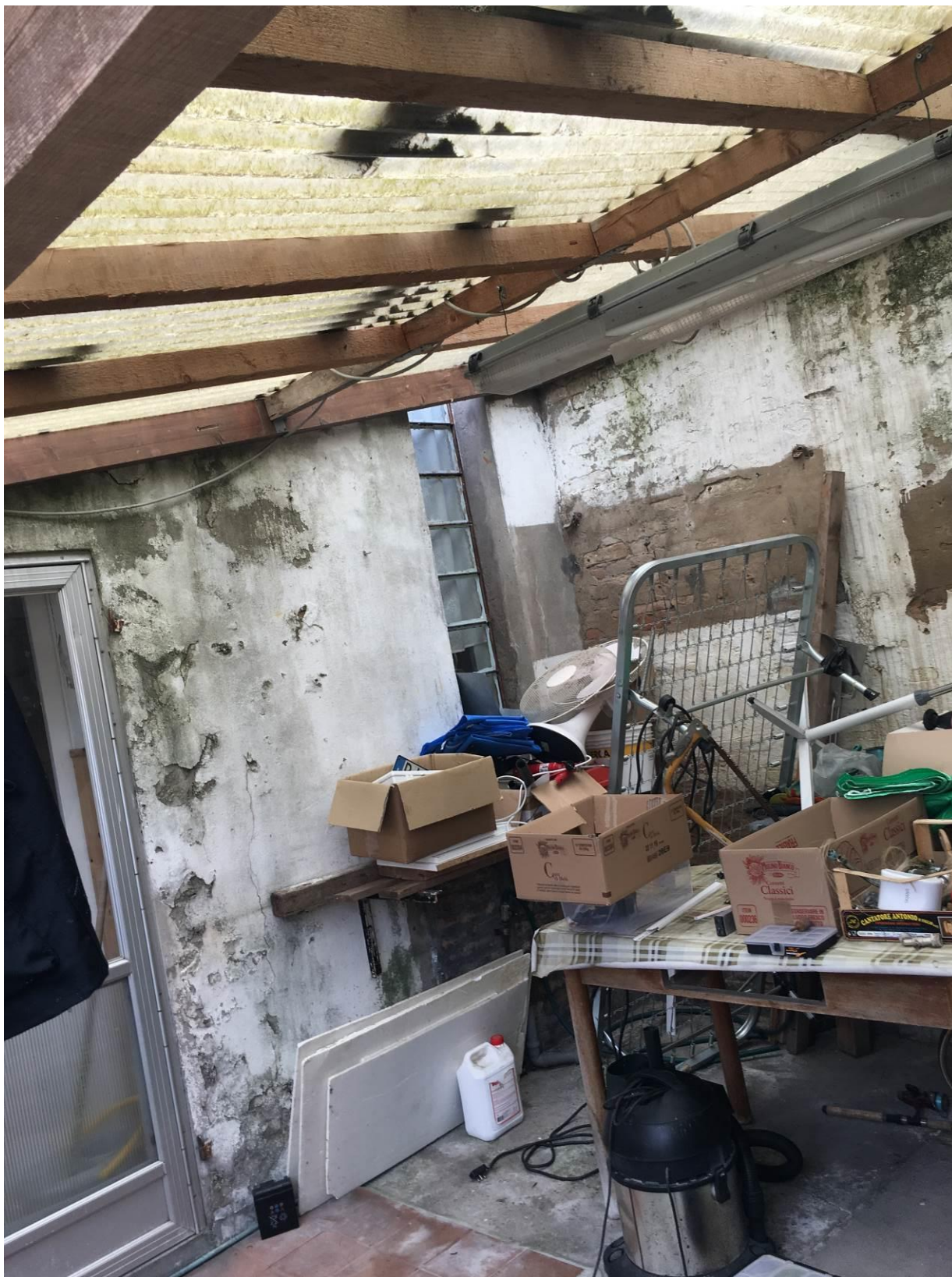
Vista retro (con tettoia abusiva)
