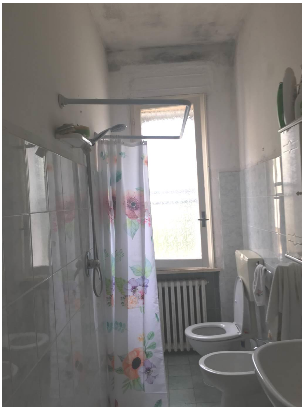
Vista interna bagno P1
