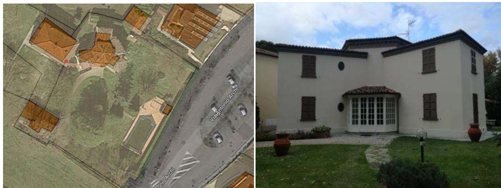
Vista aerea complesso immobiliare e Villa Unifamiliare sito in via Archi
