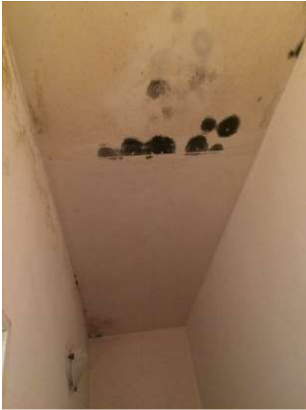
veduta dello stato di conservazione del soffitto nel disimpegno al P.T.
