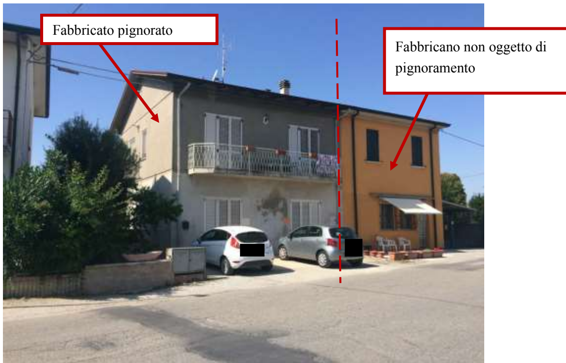
veduta del fabbricato da via Campone Sala
