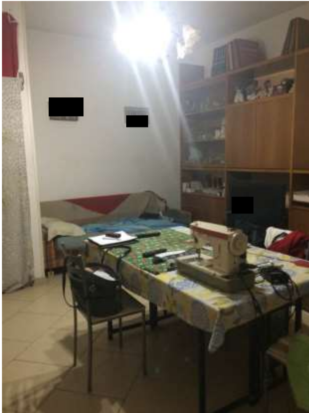
veduta del vano pranzo al P.T. (realizzato senza autorizzazione)
