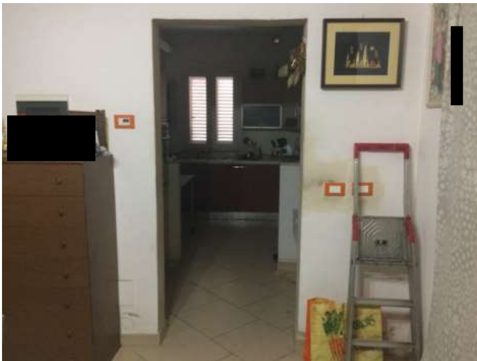
veduta dell'accesso alla cucina dal vano pranzo (realizzati senza autorizzazione al P.T.)
