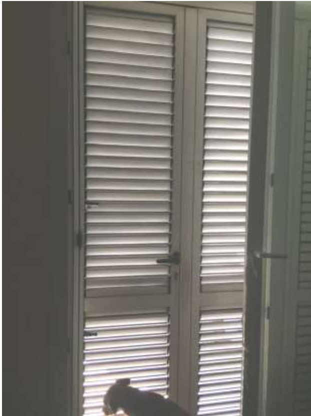
veduta dell'infisso nella camera da letto al P.T. (realizzata senza autorizzazione)
