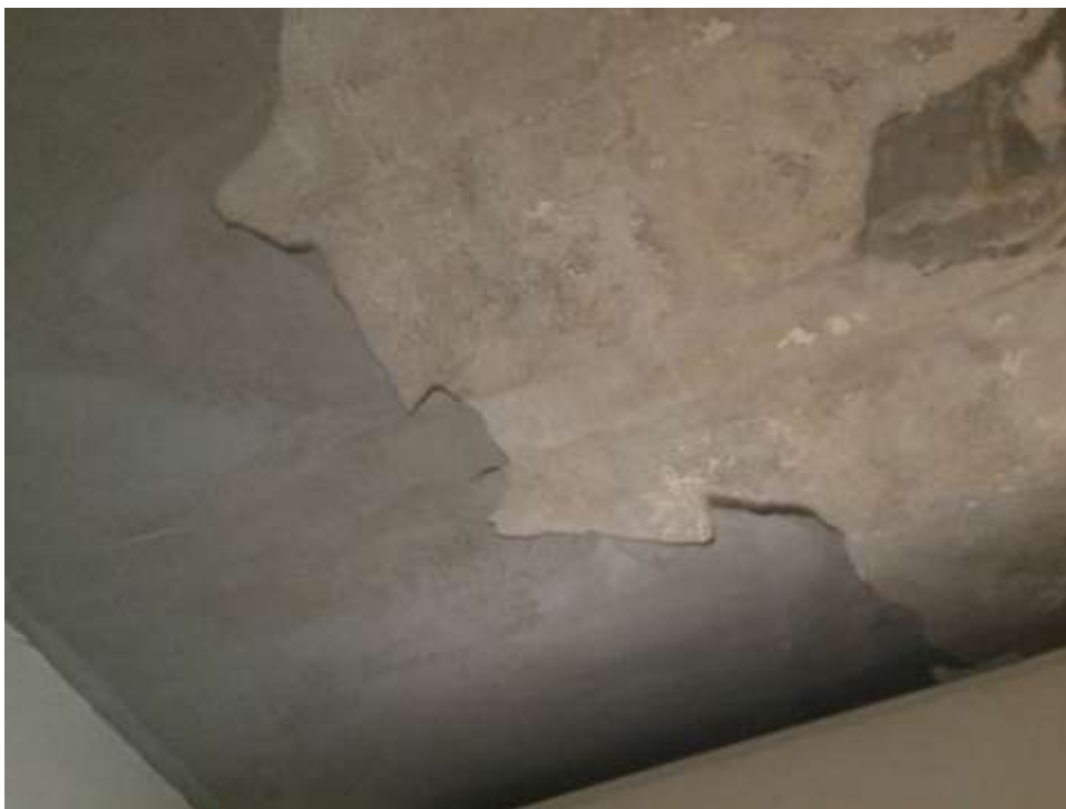
particolare dello stato di conservazione del soffitto nella lavanderia realizzata al piano terra (senza autorizzazione)
