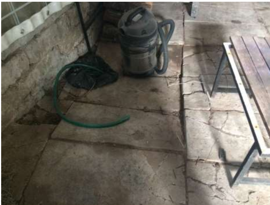
particolare del cedimento del pavimento del ripostiglio esterno
