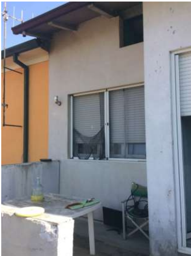
veduta del terrazzo posto sul retro del fabbricato e dell'apertura per l'accesso al sottotetto
