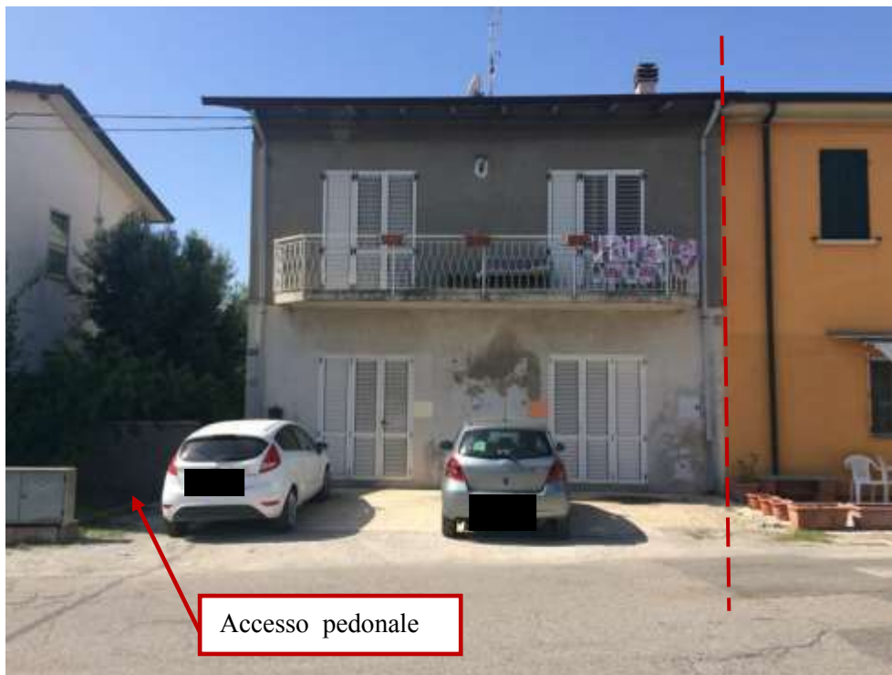
veduta del fabbricato da via Campone Sala
