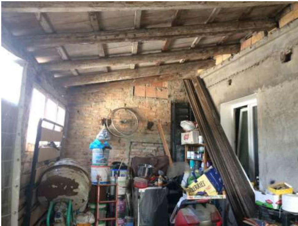
veduta del ripostiglio esterno
