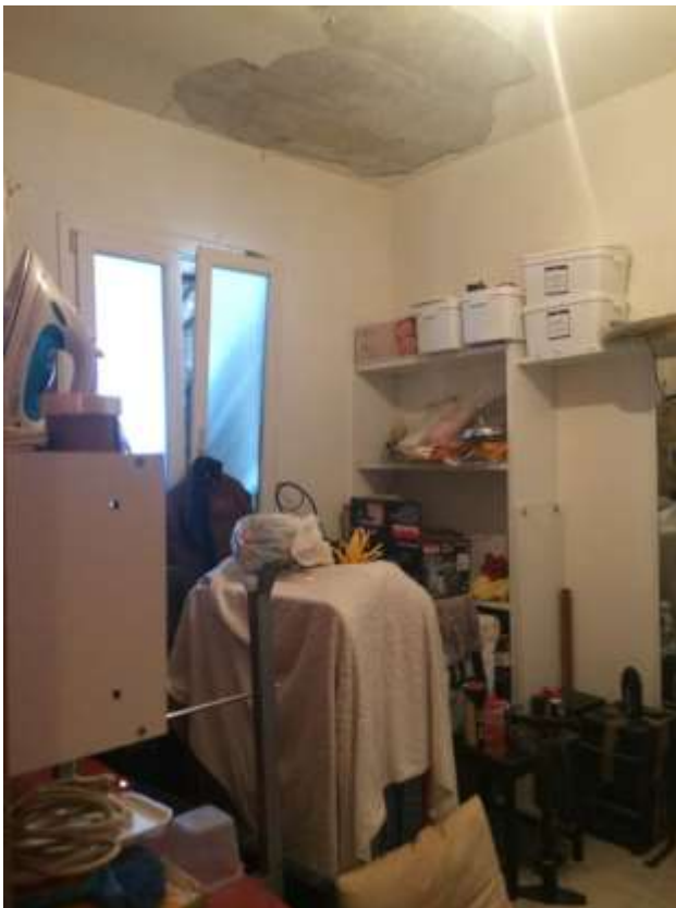
veduta del ripostiglio (ridimensionato) e particolare dello stato di conservazione del soffitto
