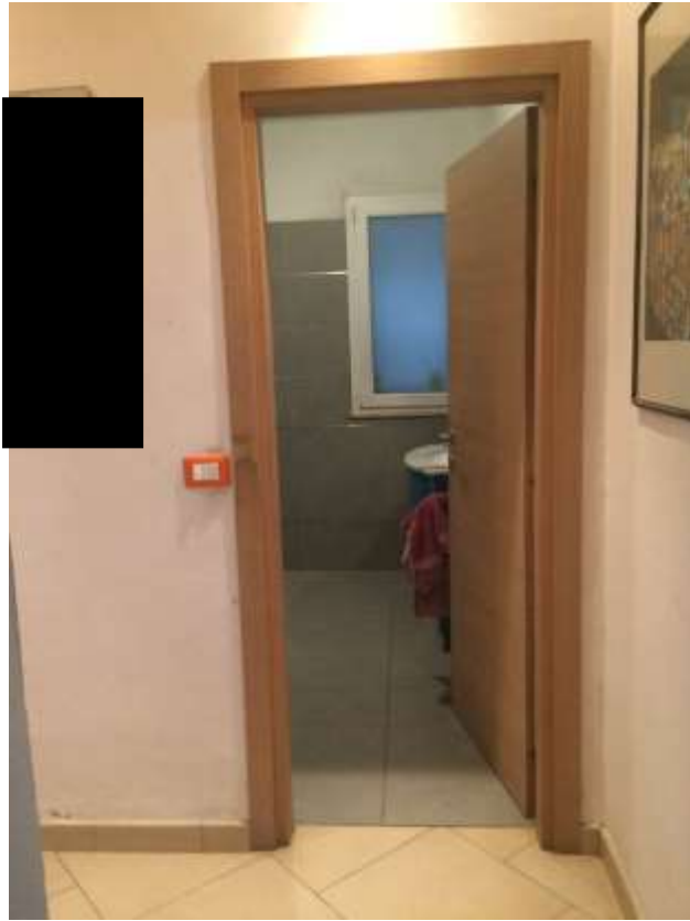
veduta, dal disimpegno, del w.c. al P.T. (realizzato senza autorizzazione)
