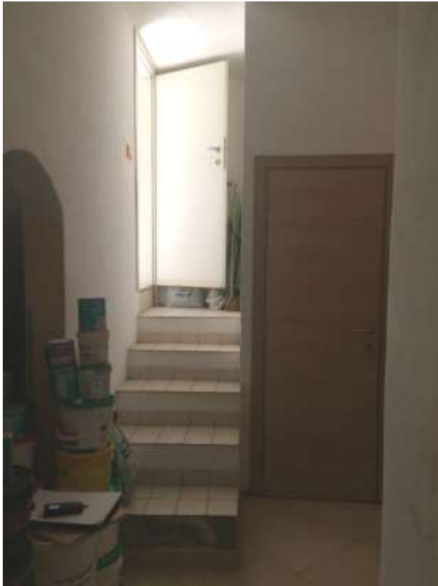
veduta della scala di accesso al piano terra
