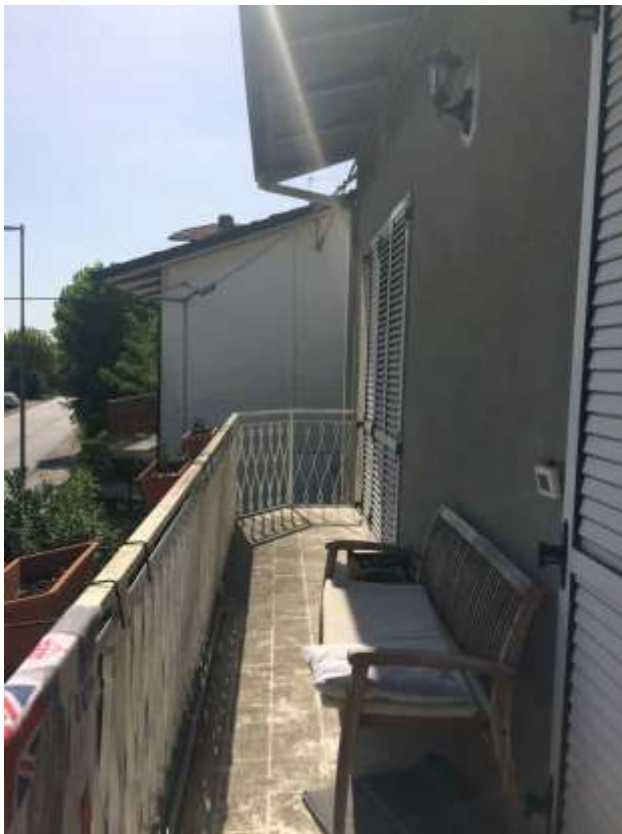
veduta del balcone, in affaccio alla via Campone Sala
