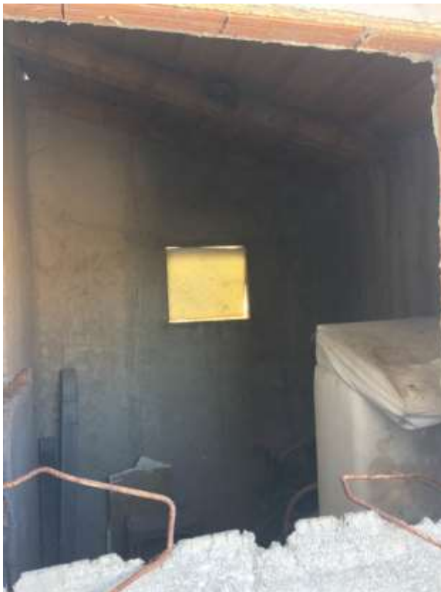
veduta del ripostiglio nel terrazzo, posto sul retro del fabbricato
