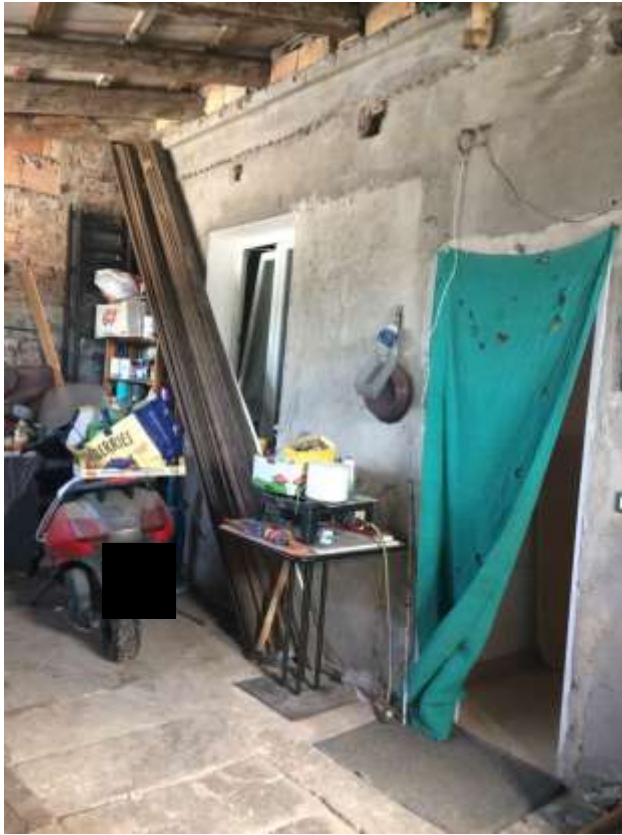
veduta del ripostiglio esterno, e della porta di accesso al disimpegno all'interno dell'abitazione
