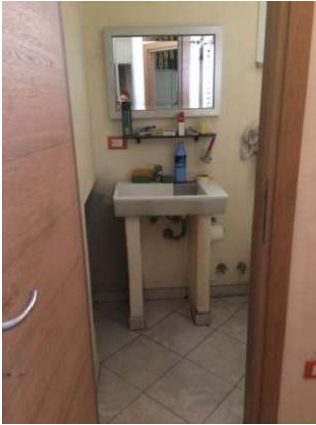
veduta del w.c. realizzato al piano terra (realizzato senza autorizzazione)
