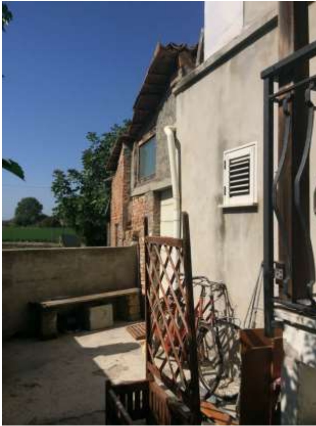
veduta del cortile di proprietà, ed accesso al ripostiglio esterno
