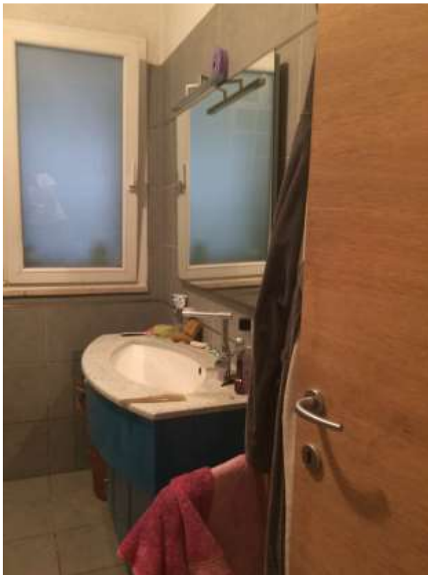
veduta del w.c. al P.T. (realizzato senza autorizzazione)
