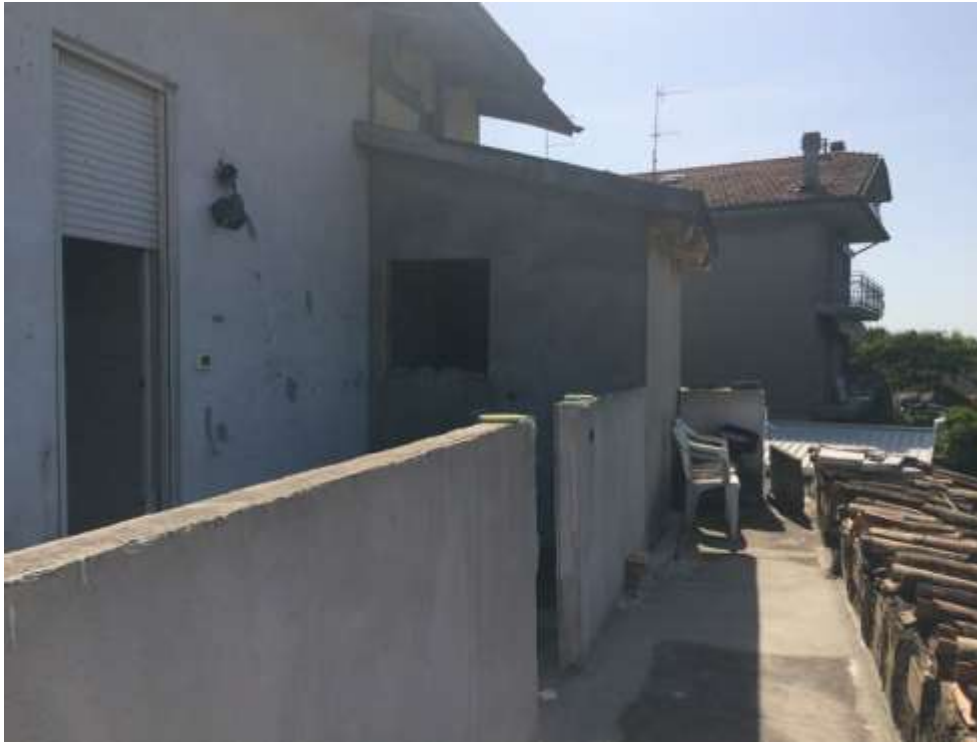
veduta del ripostiglio e del terrazzo, posto sul retro del fabbricato
