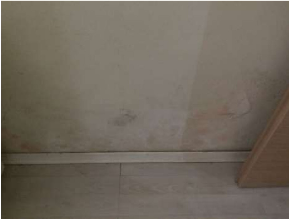
particolare della parete e dei segni dell'umidità nella camera da letto al P.T. (realizzata senza autorizzazione)
