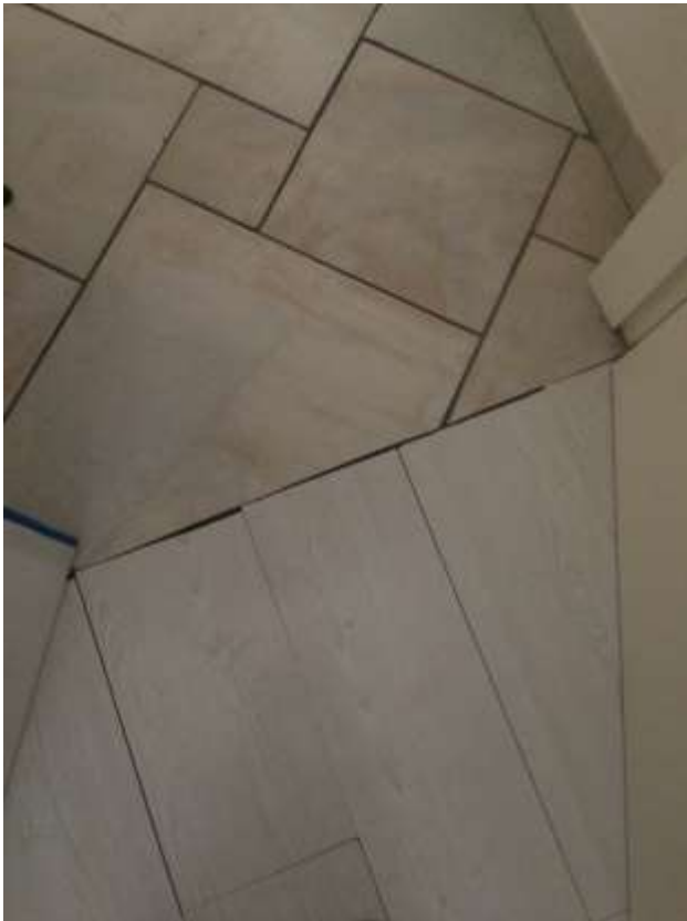
particolare pavimenti posati in opera al P.P.
