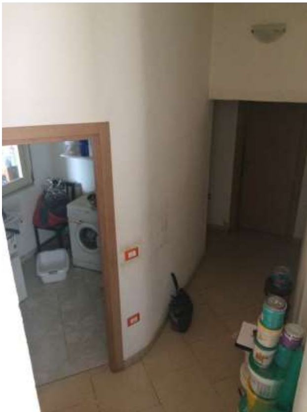
veduta della lavanderia e del corridoio (realizzati senza autorizzazione)
