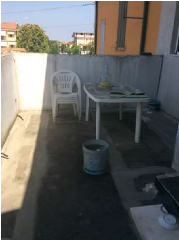
veduta del terrazzo posto sul retro del fabbricato
