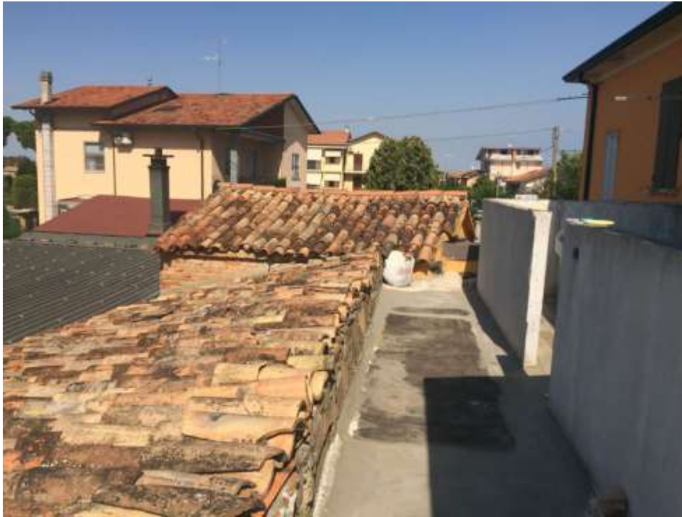
veduta del terrazzo posto sul retro del fabbricato
