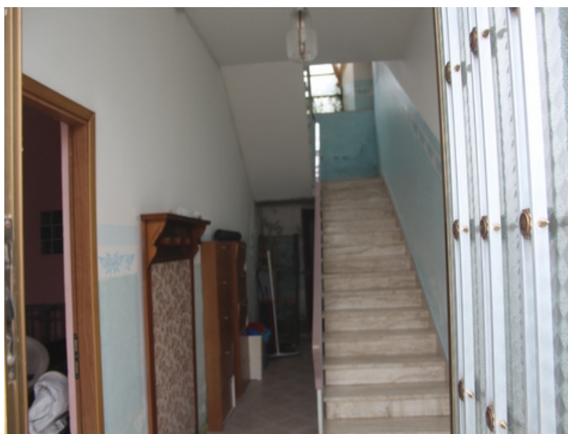
ingresso vano scala piano terra
