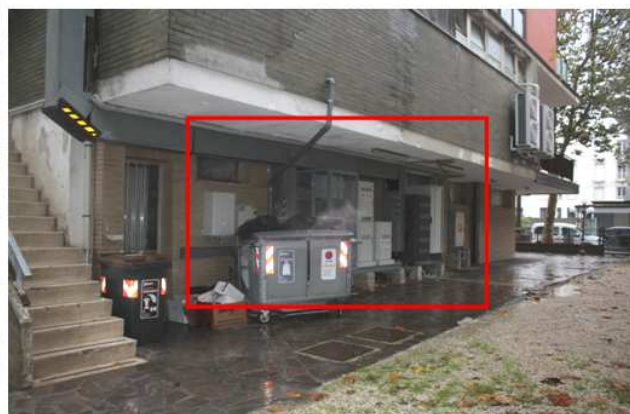
Foto 31: apprestamenti impiantistici a supporto dell'antenna
