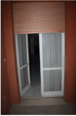
Foto 73: ingresso al terrazzo comune
