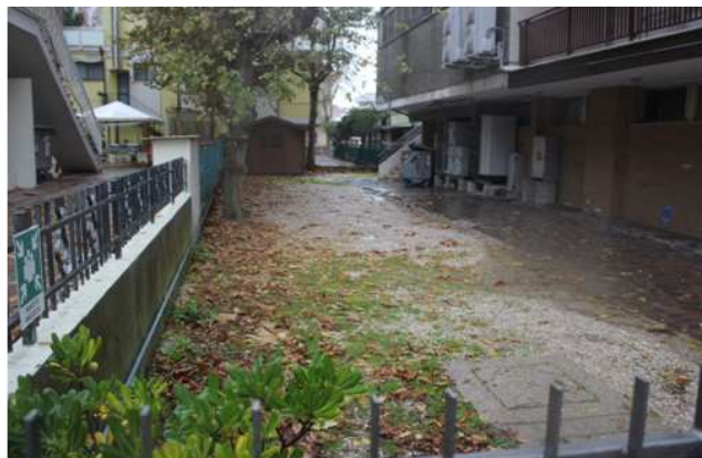
Foto 7: spazi esterni – lato sud sullo sfondo il manufatto in legno
