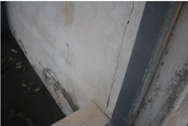
Foto 85: dettagli di componenti edilizi deteriorati
