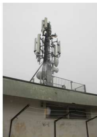
Foto 82: antenna per telefonia posta sul tetto del corpo servizi
