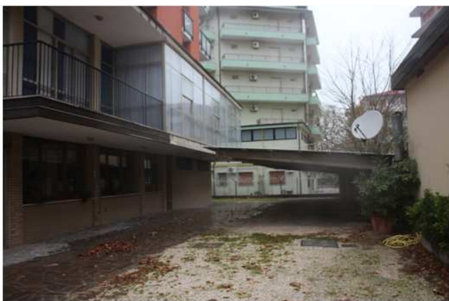
Foto 8: spazi esterni – lato nord e tettoia
