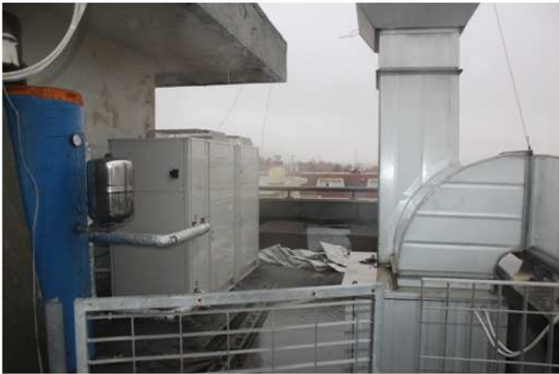
Foto 83: apprestamenti tecnici per antenna posti in copertura
