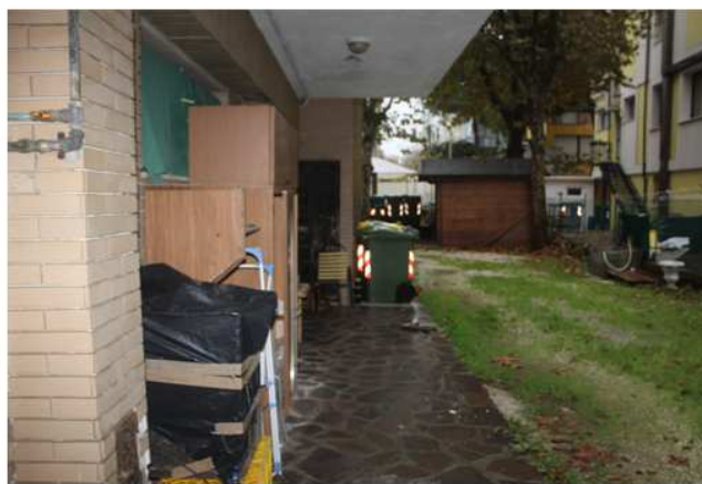
Foto 9: spazi esterni – lato ovest – retro dell'albergo
