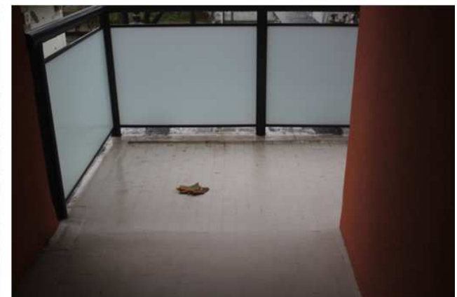
Foto 72: terrazzo comune lato sud – piano secondo
