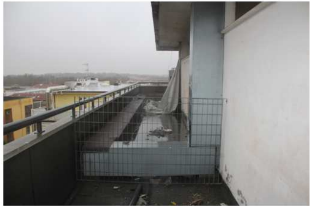
Foto 84: copertura - vista lato sud
