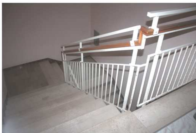
Foto 14-15: vano scale – prima ed ultima rampa
