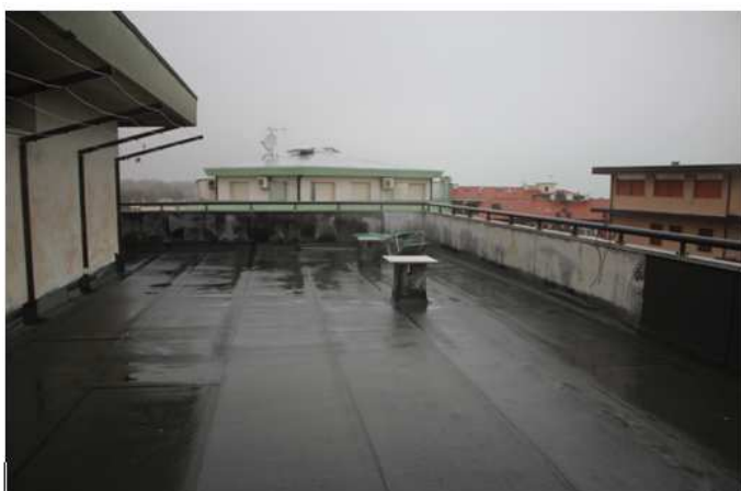
Foto 81: copertura - vista verso ovest
