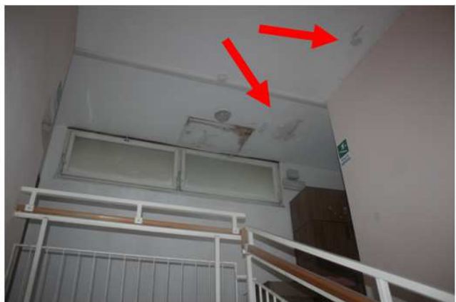
Foto 86: infiltrazioni dal tetto
