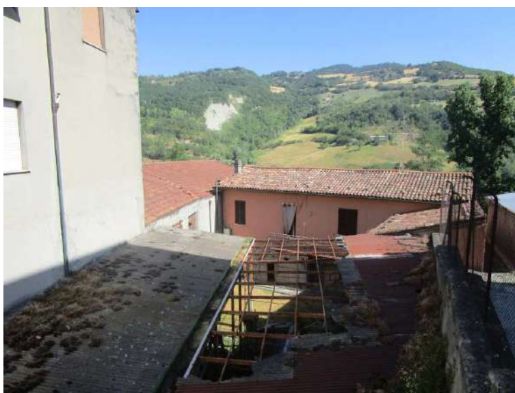
Vista da viale Roma Lotto 15 Sub 1
