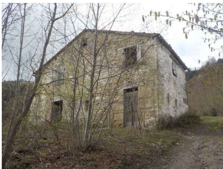
Vista fabbricato Particella n. 131 Sub 1
