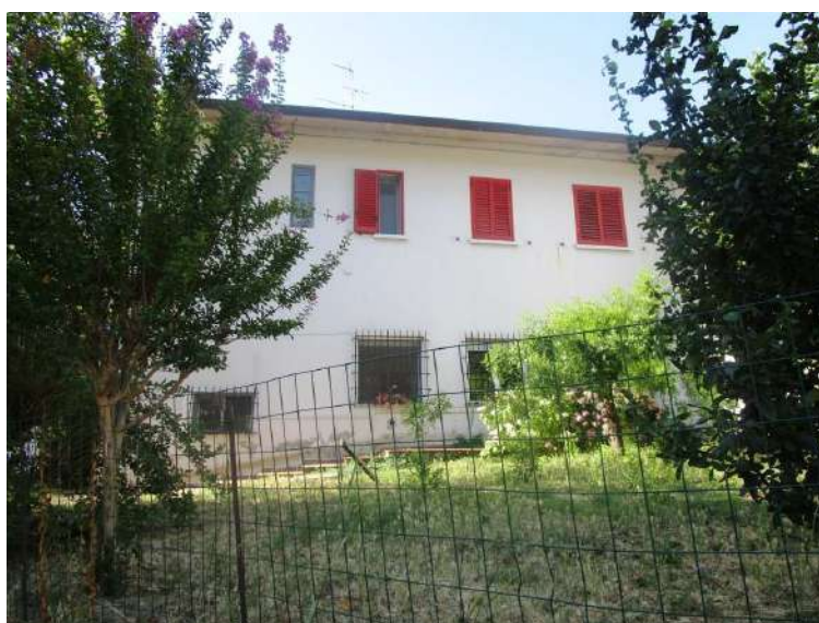
Vista da via P. Togliatti Lotto 13 Sub 1 e Lotto 14 Sub 2
