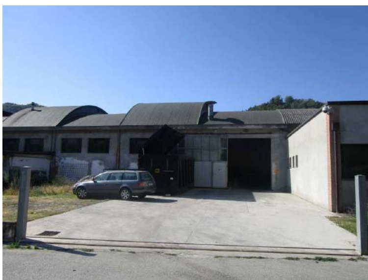
Vista esterna da via P. Togliatti Lotto 8 Sub 24
