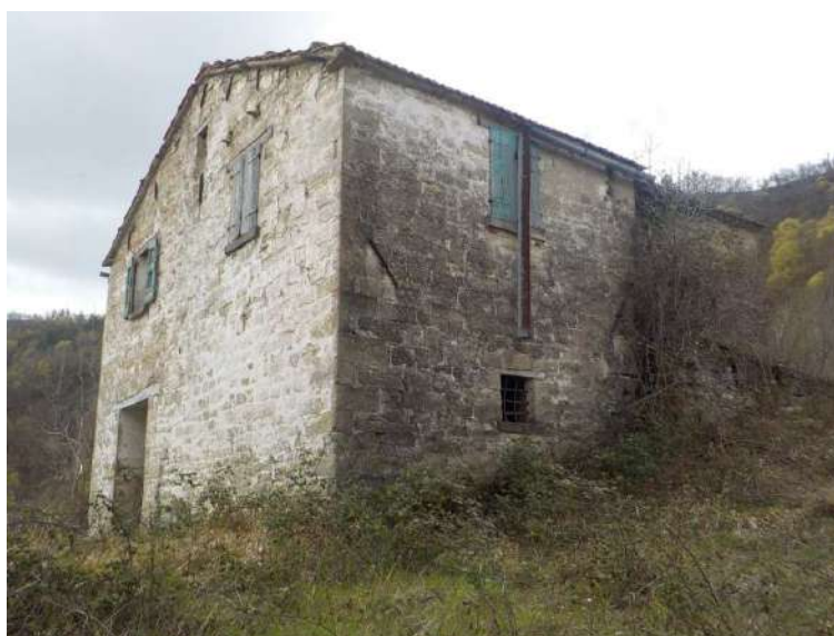
Vista fabbricato Particella n. 163 Sub 2
