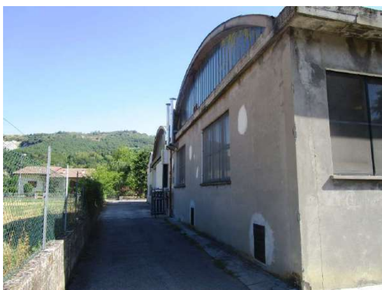
Vista esterna da via P. Togliatti Lotto 6 Sub 22
