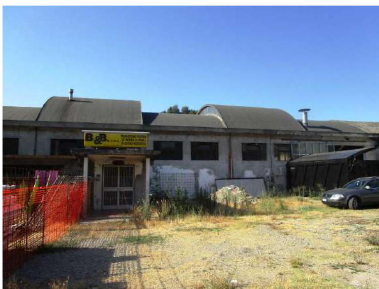
Vista esterna da via P. Togliatti Lotto 1 Sub 6
