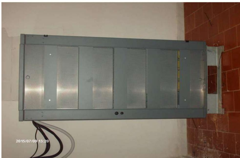
FOTO 7 - QUADRO DI CONTROLLO ANTENNE IN LOCALE ESISTENTE
