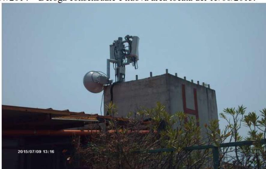
FOTO 5 - ANTENNE RADIO SUL TORRINO ASCENSORE
