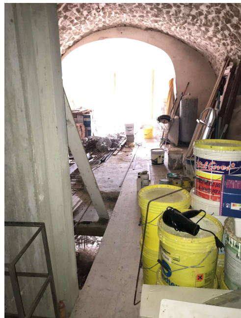
UNITA' IN CORSO DI COSTR. (P.T. E P. -1)
