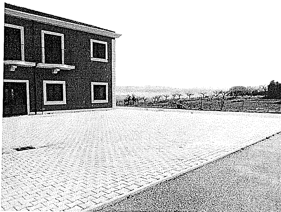
Foto 90 – Porzione della corte esterna pavimentata.
