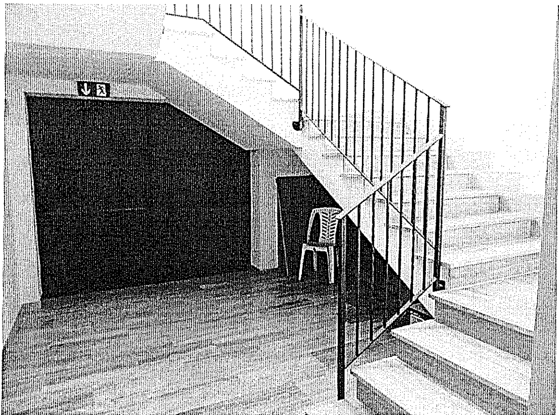
Foto 33 – Seconda scala di emergenza del primo corpo di fabbrica – piano terra.
