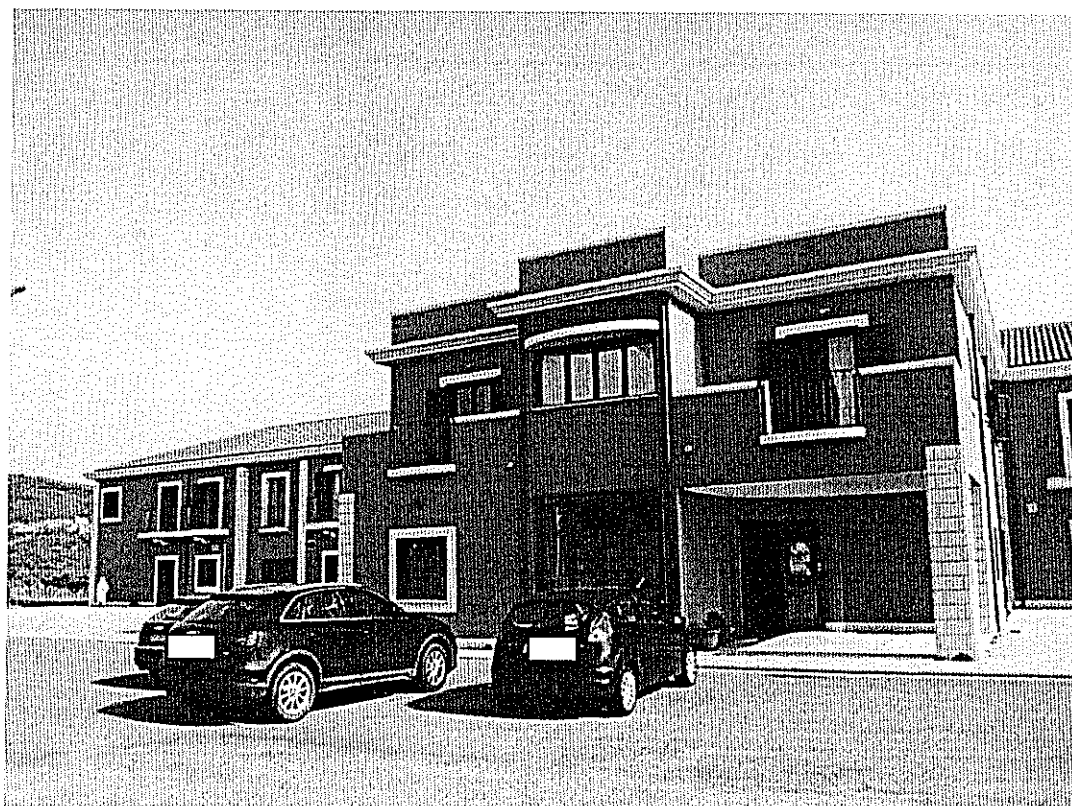
Foto 1 e 2 – Vista del primo corpo di fabbrica dalla corte esterna.
