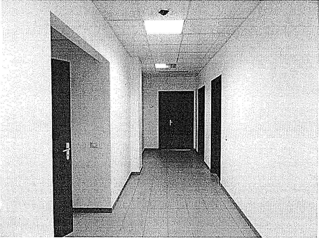
Foto 7 – Disimpegno del primo corpo di fabbrica – piano terra.
