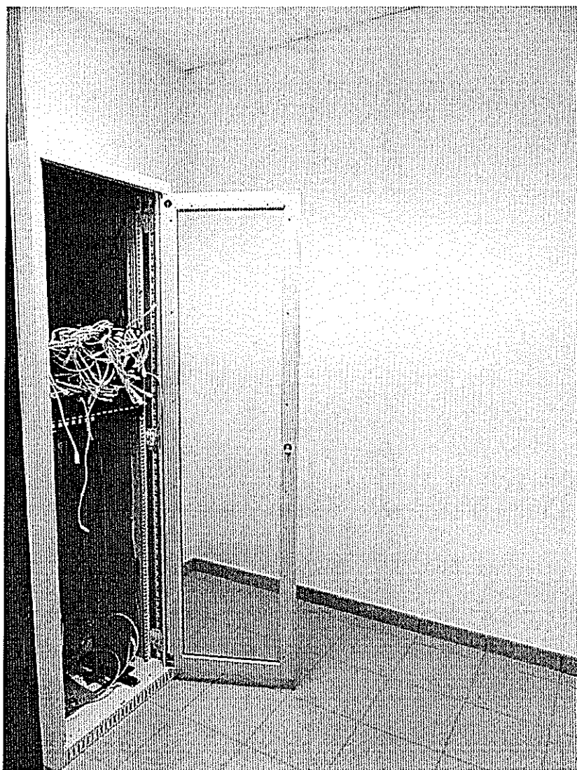
Foto 20 – Locale deposito del primo corpo di fabbrica – piano terra.
