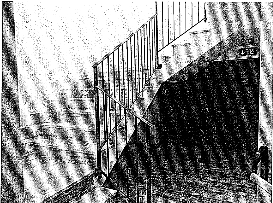
Foto 16 – Prima scala d'emergenza del primo corpo di fabbrica – piano terra.
