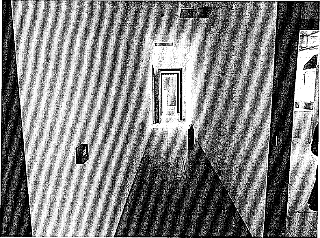
Foto 25 – Zona filtro dell'area cucine del primo corpo di fabbrica – piano terra.
