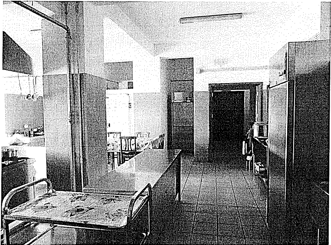
Foto 22 – Cucina del primo corpo di fabbrica – piano terra.
