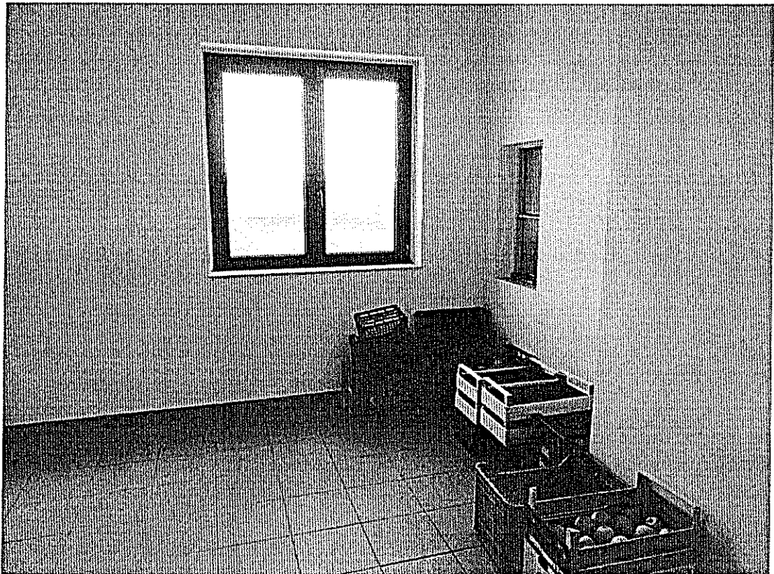
Foto 31 – Deposito sporco del primo corpo di fabbrica – piano terra.
