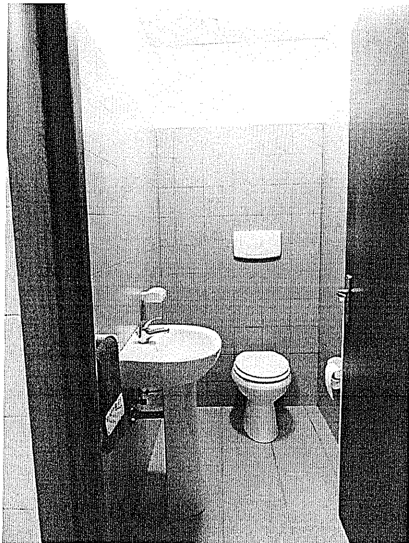
Foto 36 – Wc interno dell'area centrale del primo corpo di fabbrica – piano terra.
