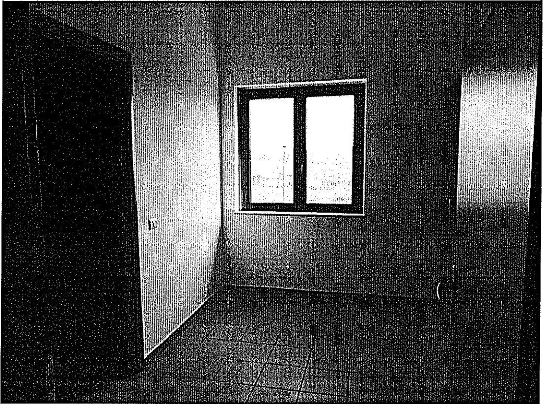
Foto 27 – Spogliatoio del primo corpo di fabbrica – piano terra.
