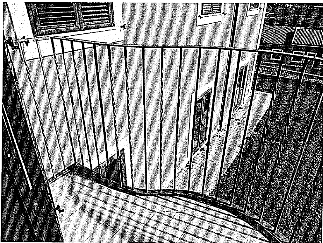
Foto 46 – Balcone tipo del primo corpo di fabbrica – piano primo.
