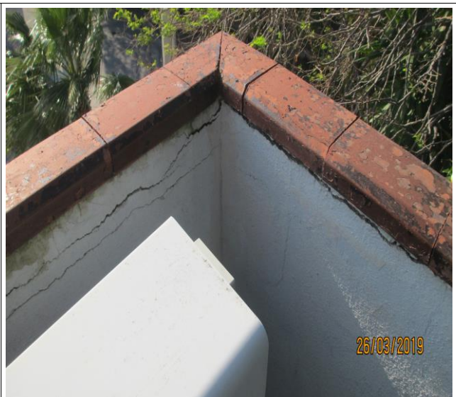
Foto 19. Particolare del balcone con parapetto in muratura a cui è stato frapposto coprimuro in cotto
