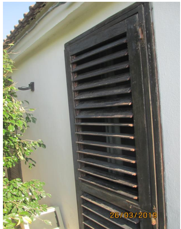
Foto 18. Particolare della tapparella in legno ad un battente
