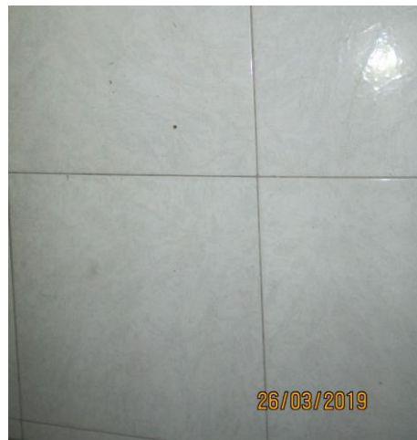
Foto 13. Particolare del pavimento al piano secondo nella zona notte in piastrelle di ceramica bianca
