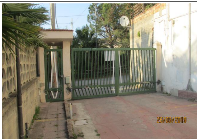
Foto 5. Particolare del cancello a due ante di accesso al complesso immobiliare “La Piramide”
