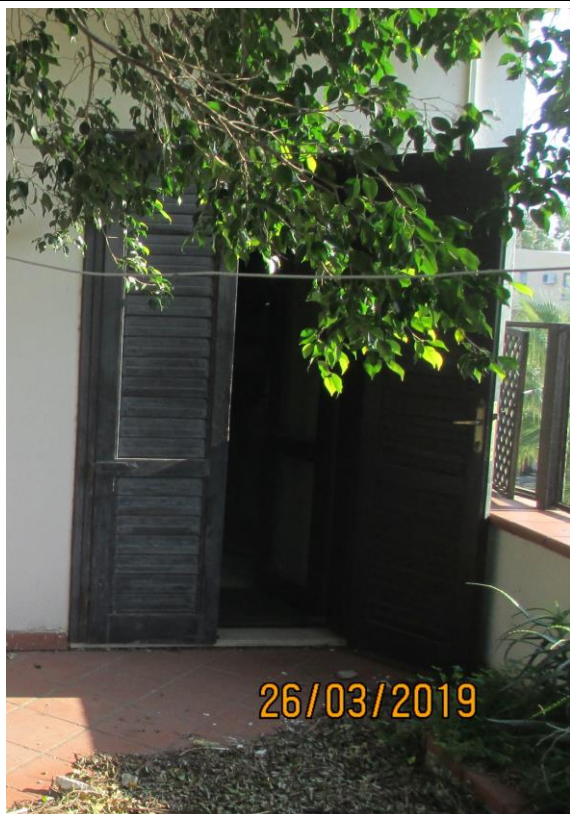
Foto 9. Particolare dell'infisso-ingresso, ove avviene l'accesso all'immobile, posto sul lato Nord
