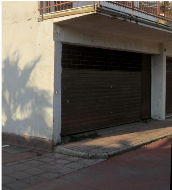
Foto 23. Serranda di accesso al garage posto al piano terra con a fianco la porta di accesso pedonale, presente all'interno del complesso "La Piramide"
