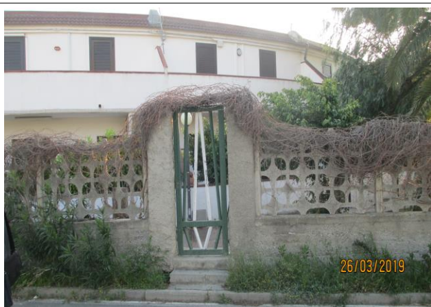
Foto 4. Accesso in fregio alla via Nazionale di accesso al complesso immobiliare “La Piramide”
