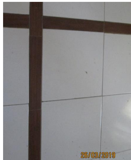
Foto 12. Particolare del pavimento al piano primo nella zona giorno in piastrelle di ceramica bianca con frappe bande di colore marrone
