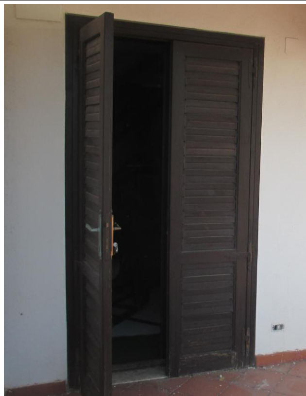
Foto 10. Particolare dell'infisso-ingresso, ove avviene l'accesso all'immobile, posto sul lato Sud
