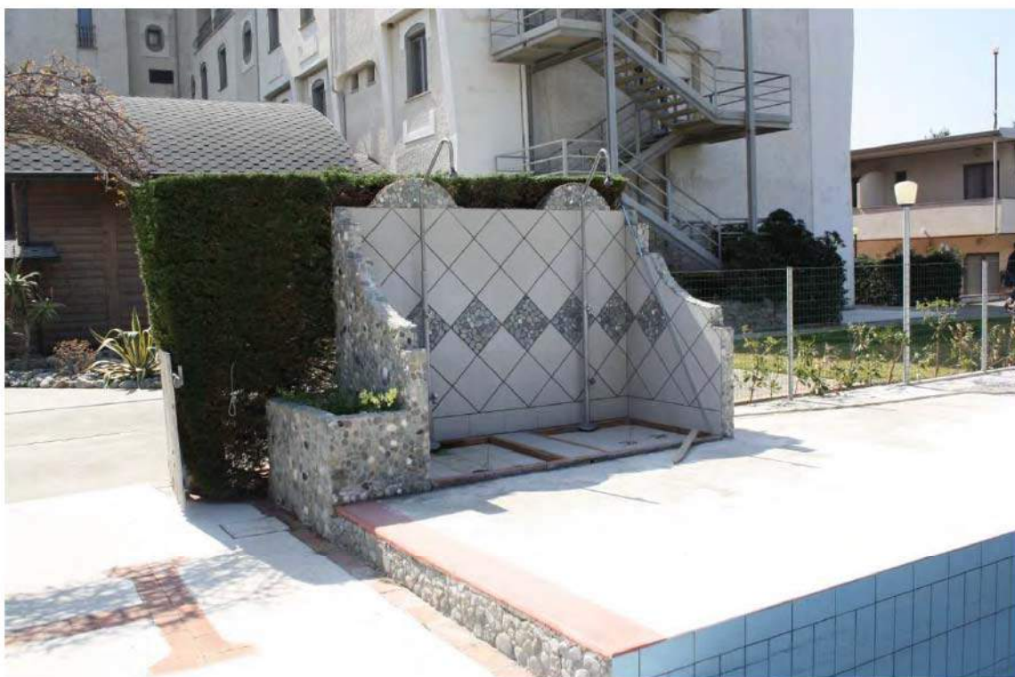
FOTO N° 28 – DOCCE ESTERNE A SERVIZIO DELLA ZONA PISCINA
