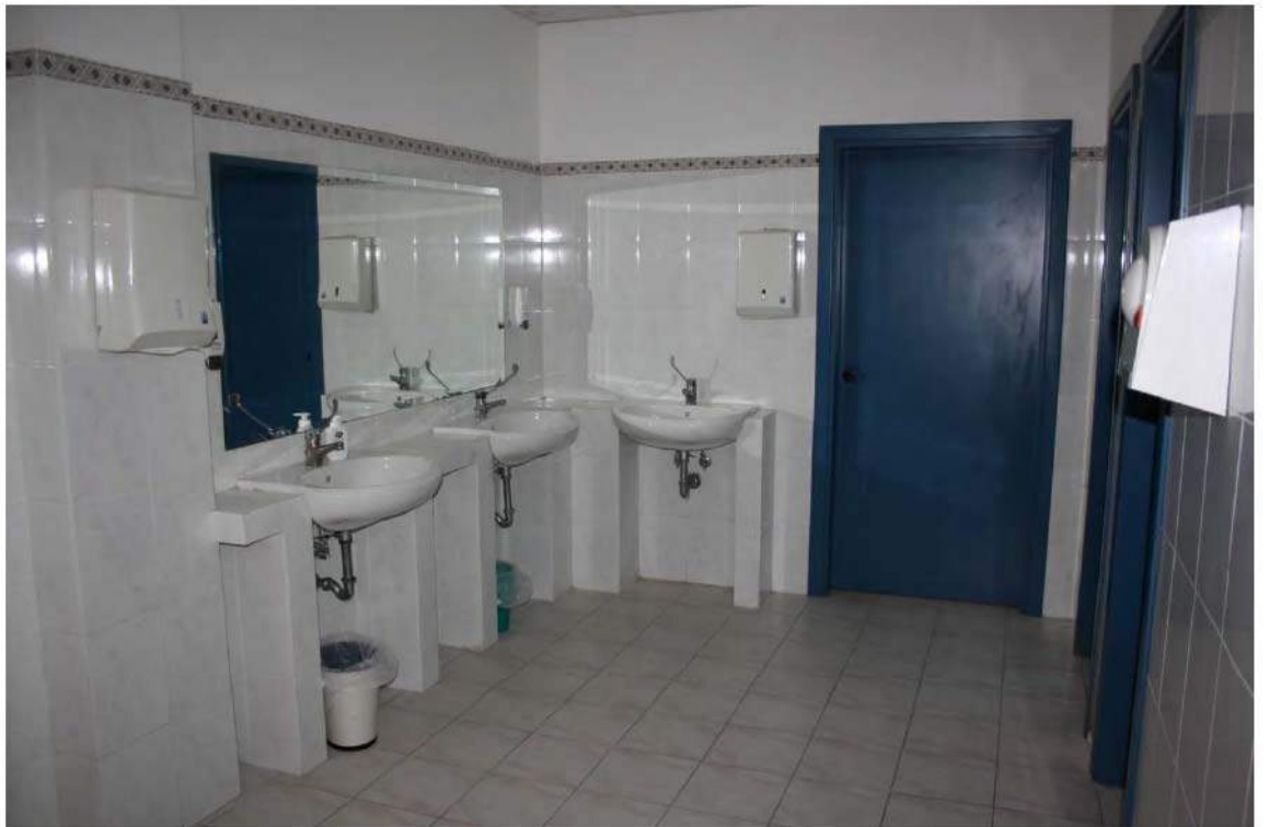
FOTO N° 84 – BAGNI PIANO SEMINTERRATO
