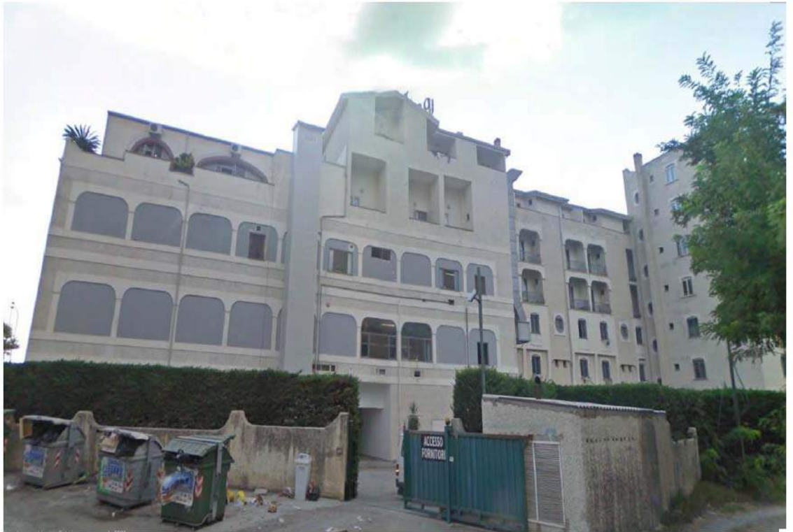
Foto N° 9 – VISTA LATO EST
