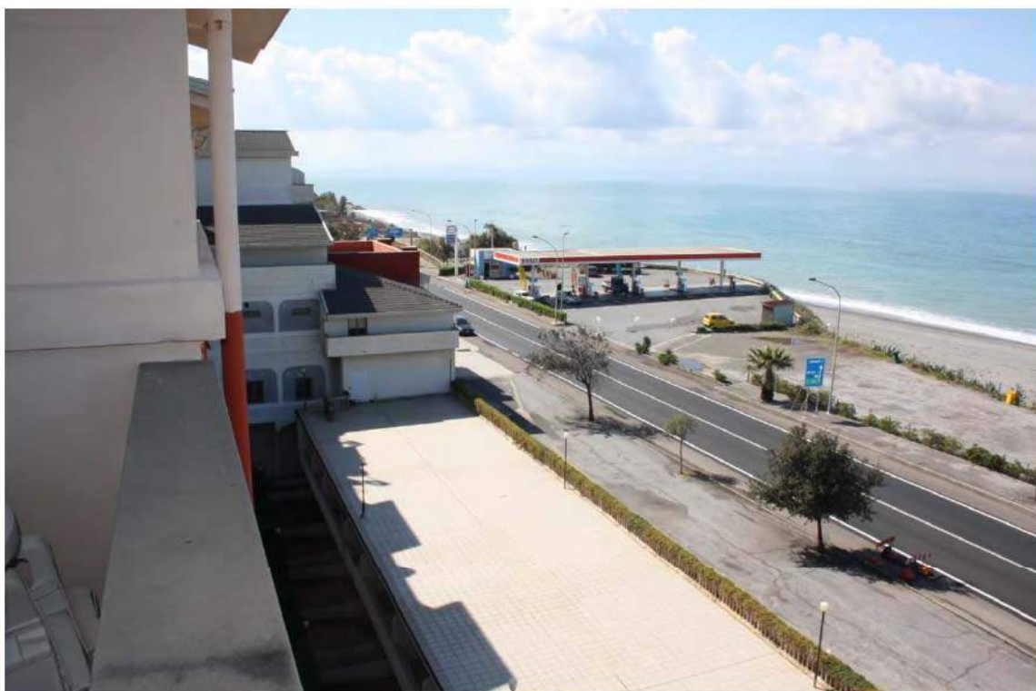
Foto N° 34 – VISTA LASTRICO SOLARE COSTITUENTE IL TETTO DELLA DEPANDANCE
