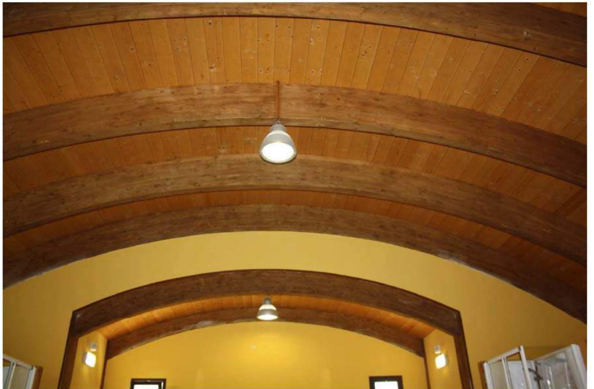
Foto N° 108 – COPERTURA CENTRO BENESSERE
