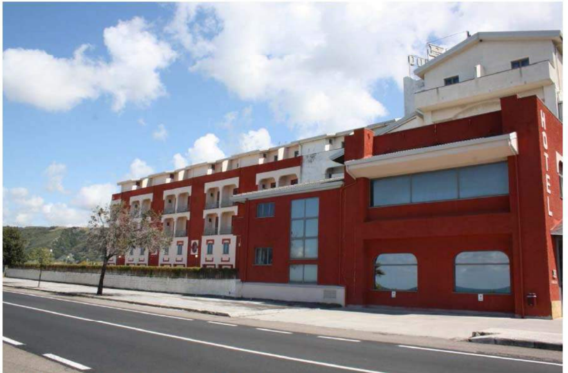
Foto n° 4 – ALTRA VISTA FACCIATA PROSPICIENTE LA STRADA STATALE SS 18
