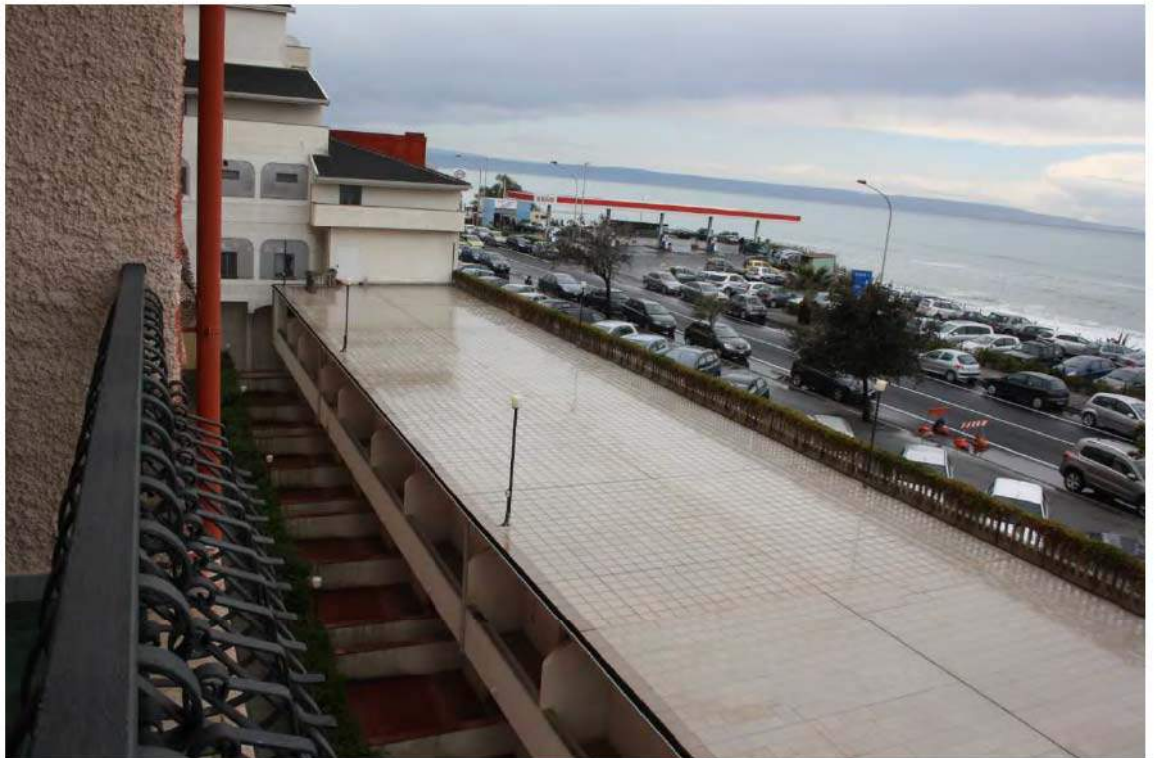
Foto N° 70 – VISTA DAI BALCONCNI DEL PIANO SECONDO
