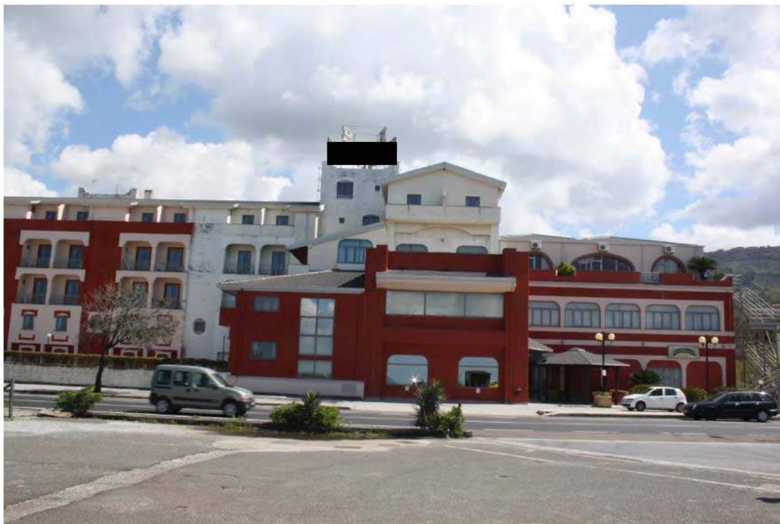
FOTO N° 5 – ALTRA VISTA FACCIATA PROSPICIENTE LA STRADA STATALE SS 18
