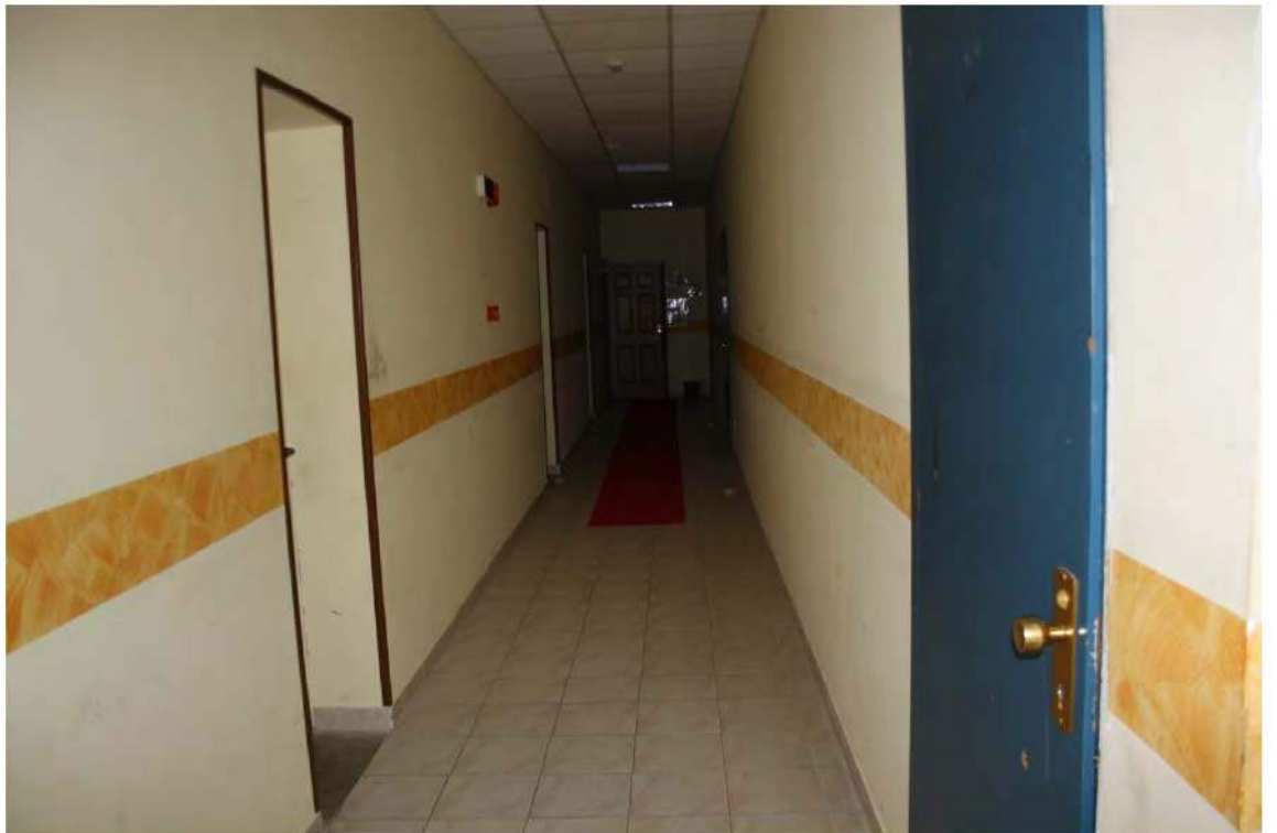
FOTO N° 98 – CORRIDOIO CENTRO BENESSERE
