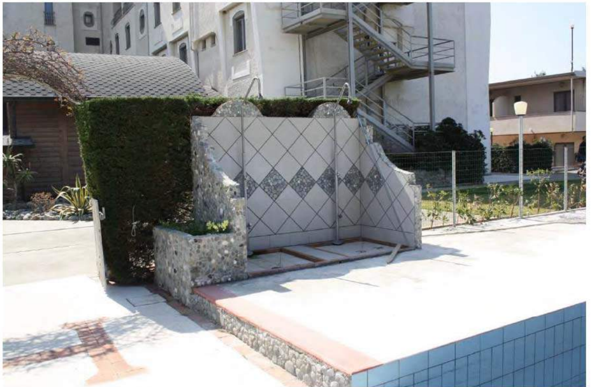
FOTO N° 28 – DOCCE ESTERNE A SERVIZIO DELLA ZONA PISCINA
