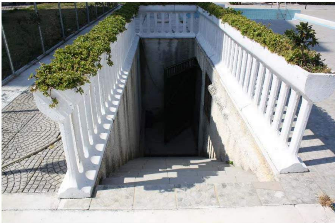
Foto N° 29 – INGRESSO LOCALI TECNICI PISCINA
