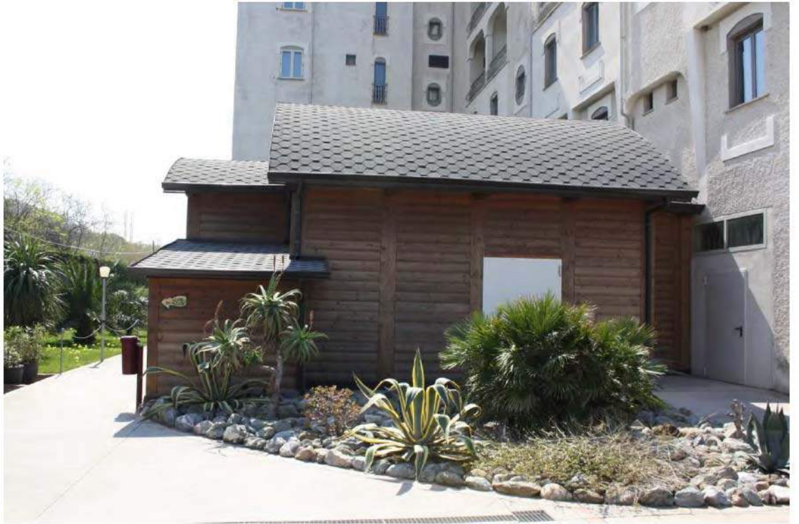
Foto N° 109 – ESTERNO CENTRO BENESSERE
