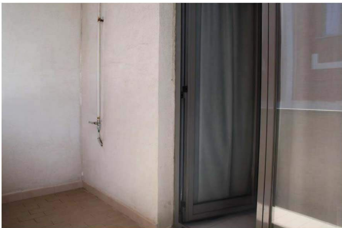
Foto N° 42 – BALCONCINO TIPO CAMERE PRIMO PIANO DEPANDANCE
