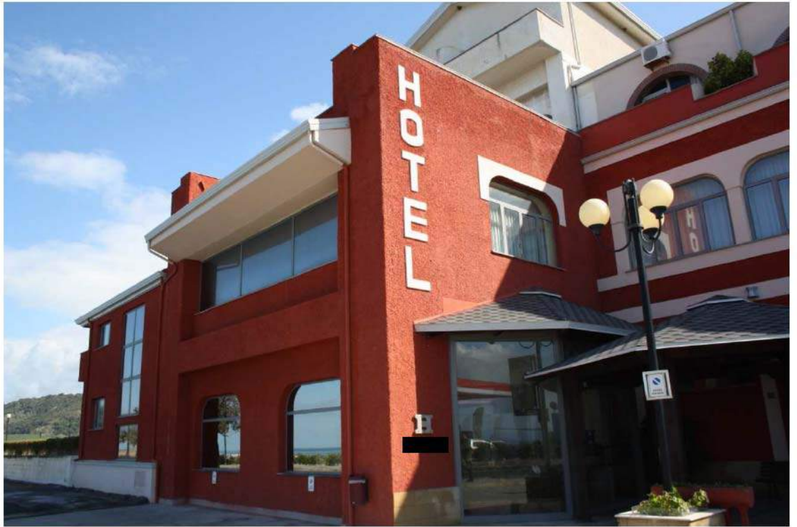
Foto n° 3 – VISTA FACCIATA PROSPICIENTE LA STRADA STATALE SS 18
