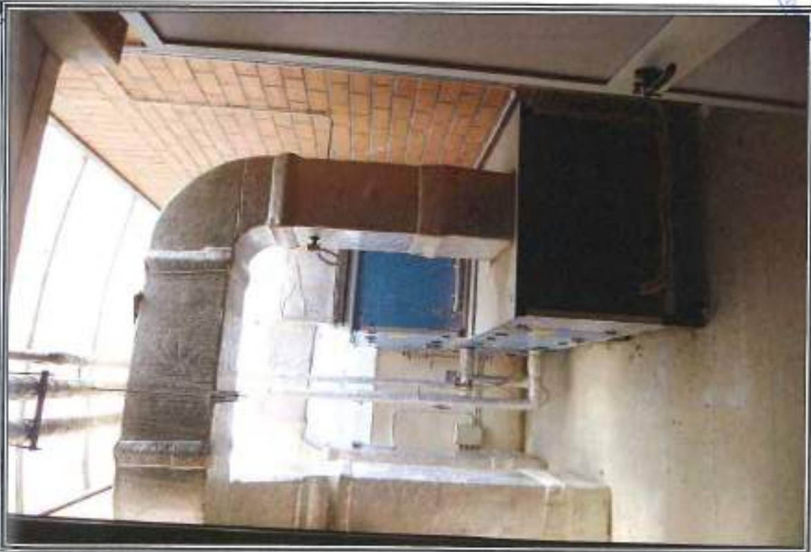
FOTOGRAFIA n. 22: Vista Interna Area Servizi Generali (SG)
