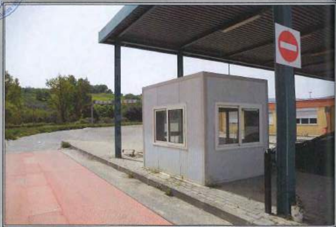
FOTOGRAFIA n. 12: Vista Esterna Centro Ingressi (CI)
