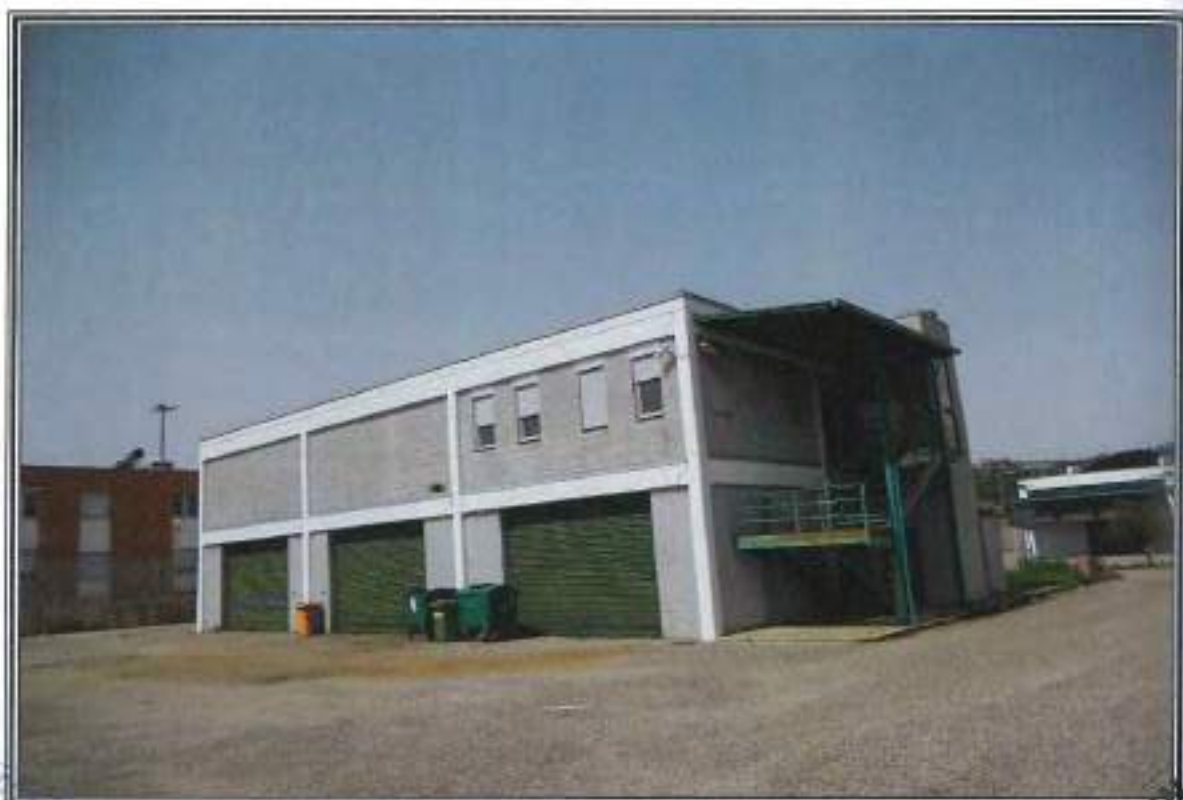
FOTOGRAFIA n. 3: Vista Esterna Area Manutenzione e Pulizie (MP)
