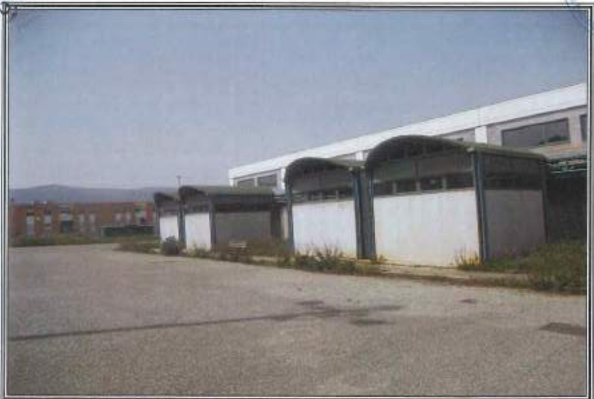
FOTOGRAFIA n. 6: Vista Esterna Area Mercato Altre Merceologie (AM)
