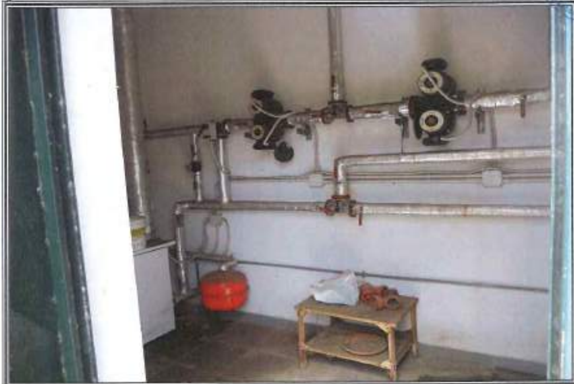
FOTOGRAFIA n. 10: Vista Interna Centro Ingressi (CI)
