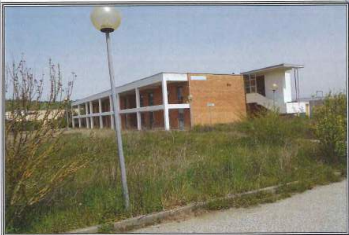
FOTOGRAFIA n. 2: Vista Esterna Area Servizi Generali (SG)
