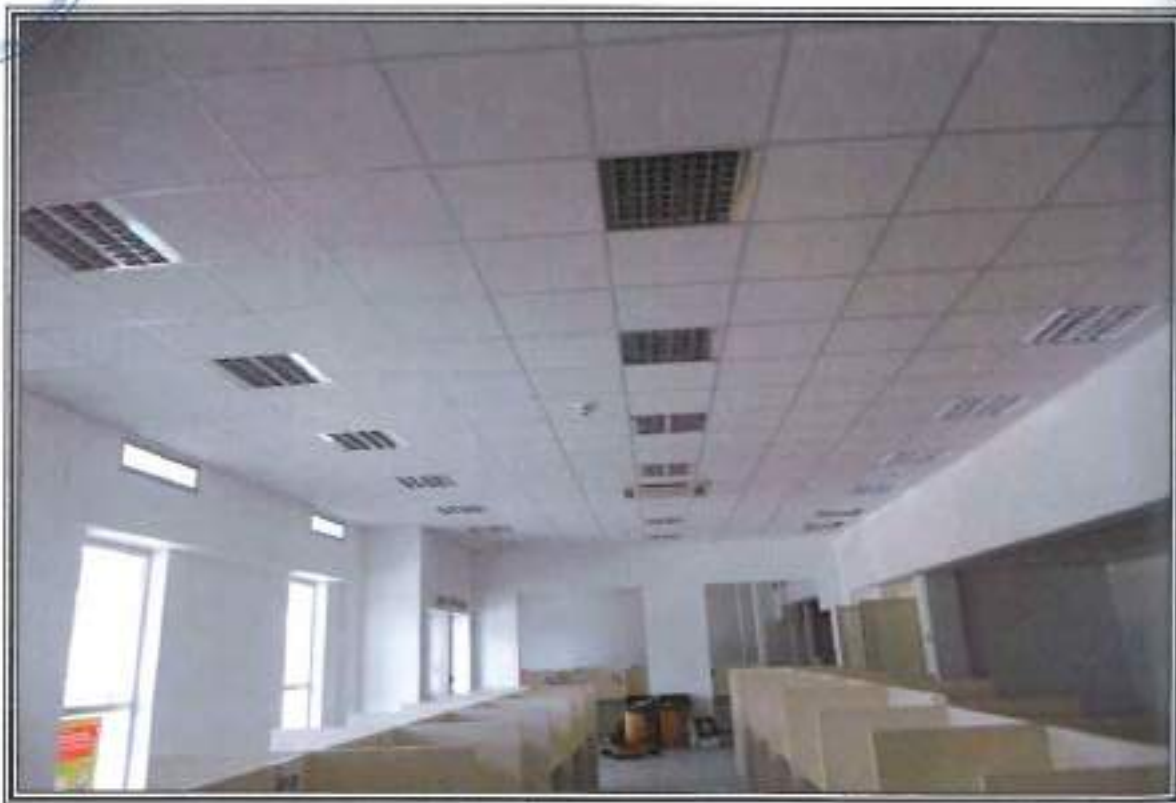
FOTOGRAFIA n. 20: Vista Interna Area Servizi Generali (SG)
