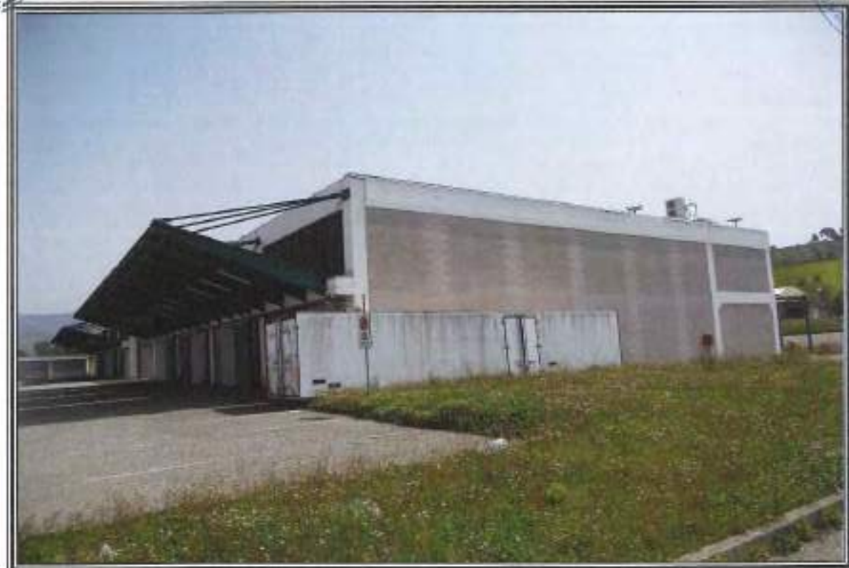
FOTOGRAFIA n. 2: Vista Esterna Area Mercato Altre Merceologie (AM)
