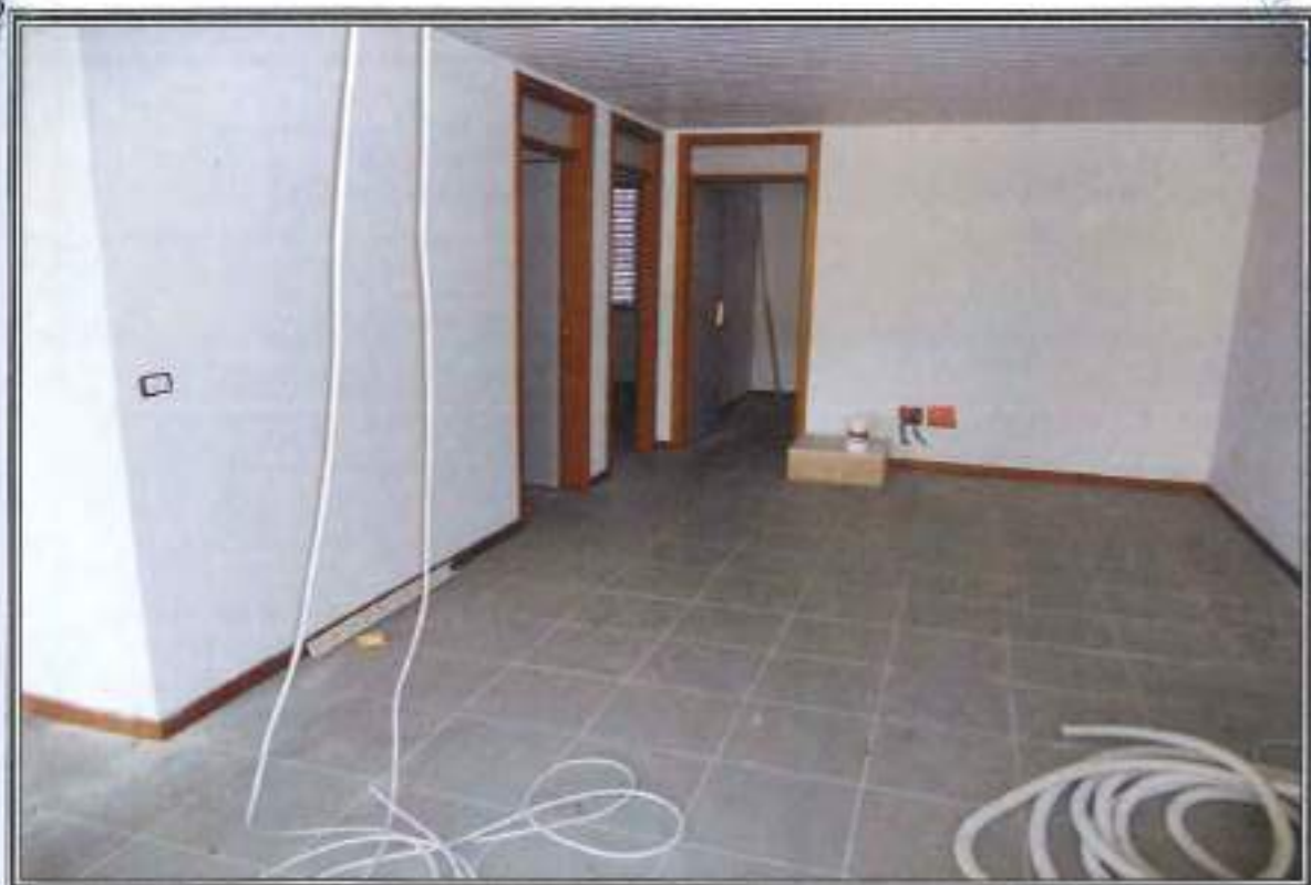
FOTOGRAFIA n. 10: Vista Interna Area Servizi Generali (SG)
