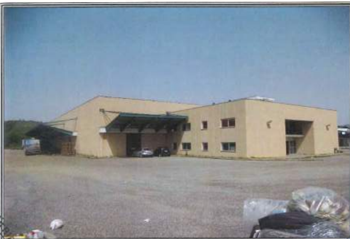
FOTOGRAFIA n. 1: Vista Esterna Magazzini Frigoriferi (MF)
