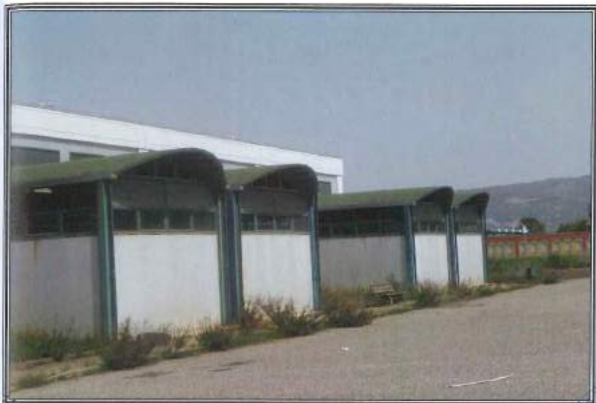
FOTOGRAFIA n. 5: Vista Esterna Area Mercato Altre Merceologie (AM)
