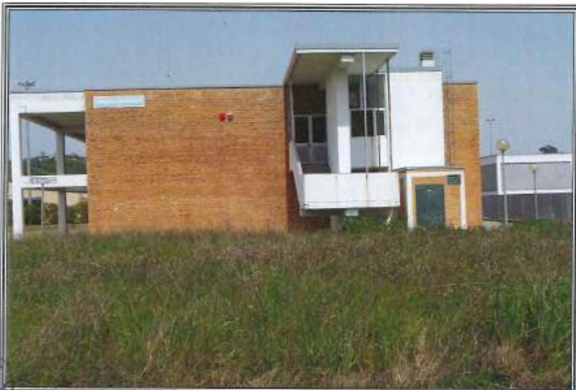
FOTOGRAFIA n. 5: Vista Esterna Area Servizi Generali (SG)
