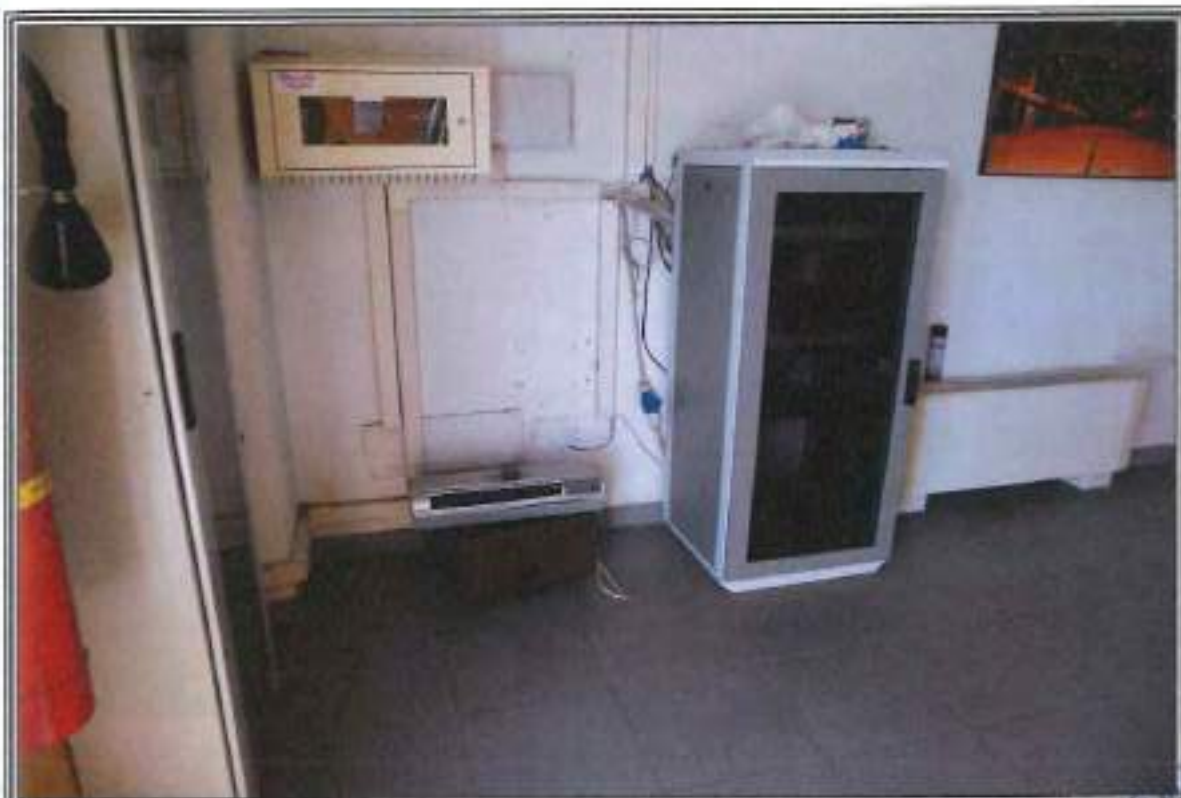
FOTOGRAFIA n. 9: Vista Interna Centro Ingressi (CI)
