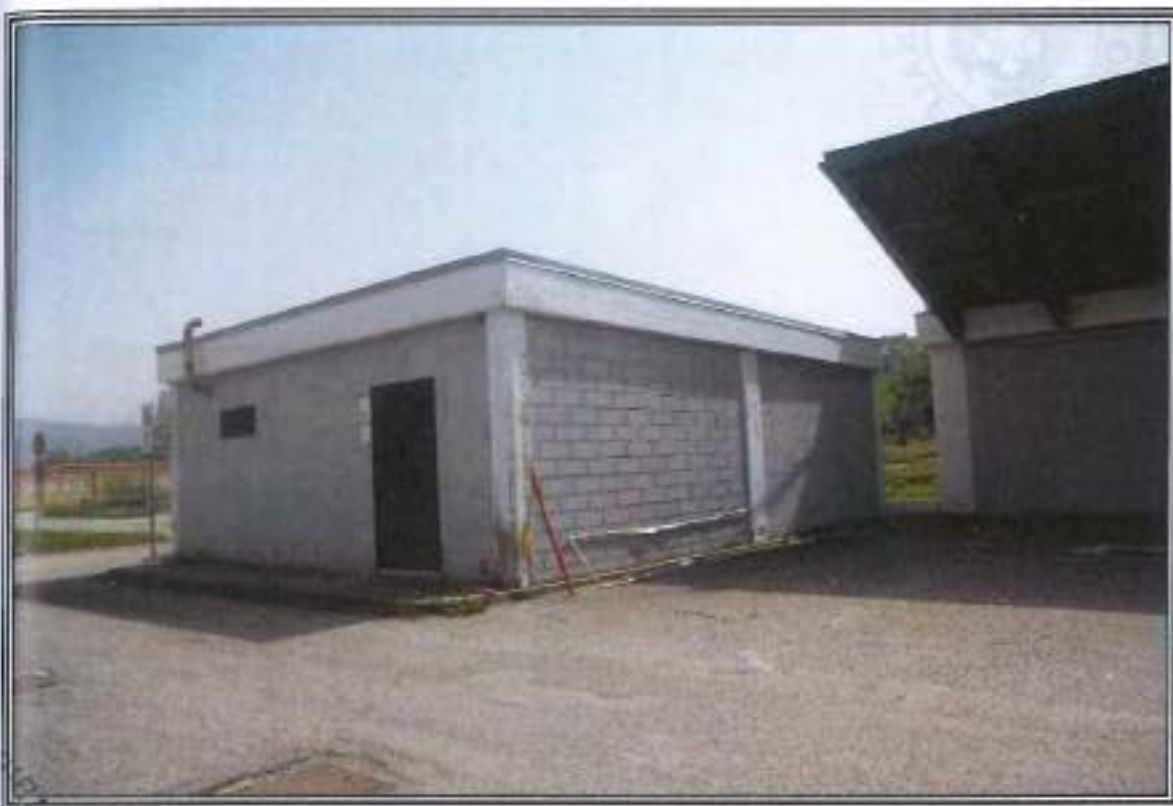
FOTOGRAFIA n. 17: Vista Esterna Area Mercato Altre Merceologie (AM)
