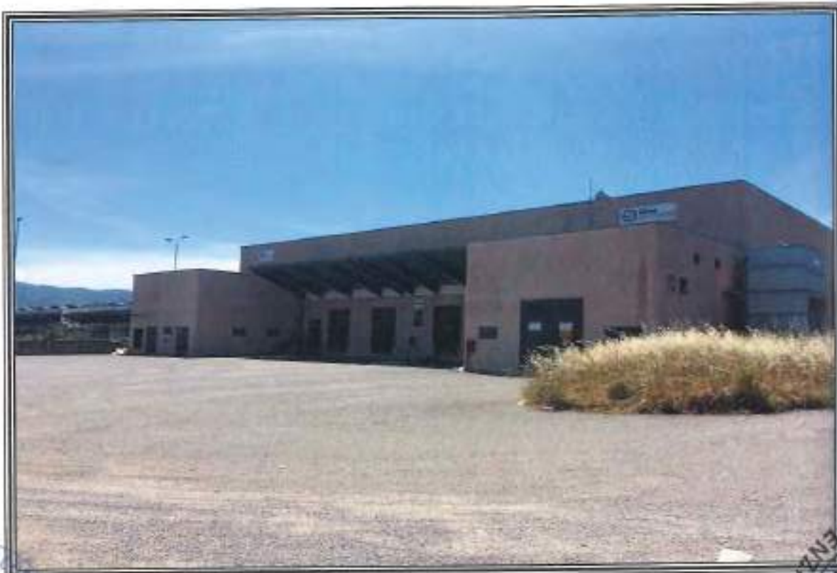
FOTOGRAFIA n. 3: Vista Esterna Magazzini Frigoriferi (MF)
