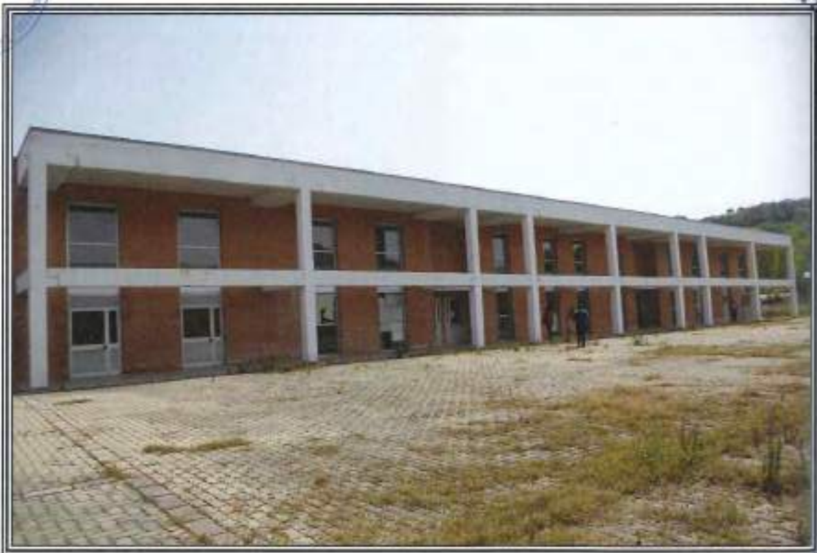
FOTOGRAFIA n. 12: Vista Esterna Area Servizi Generali (SG)
