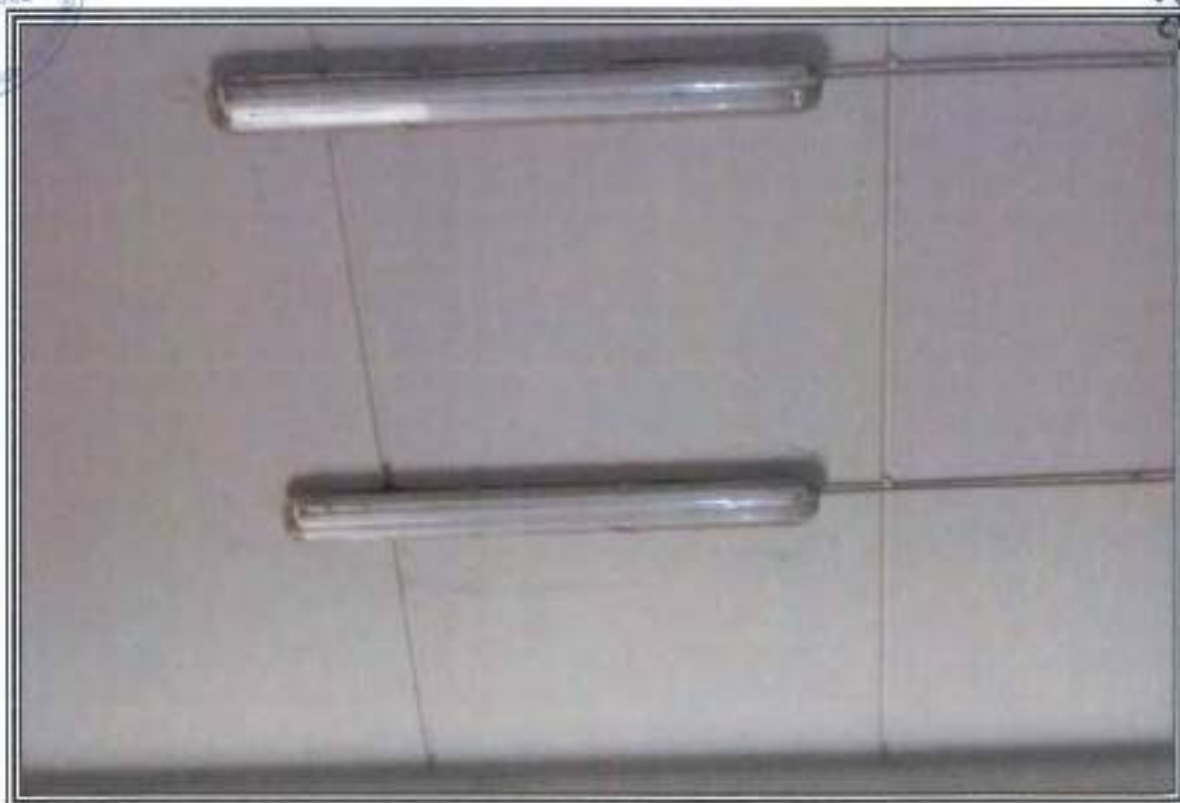
FOTOGRAFIA n. 12: Vista Interna Area Manutenzione e Pulizie (MP)
