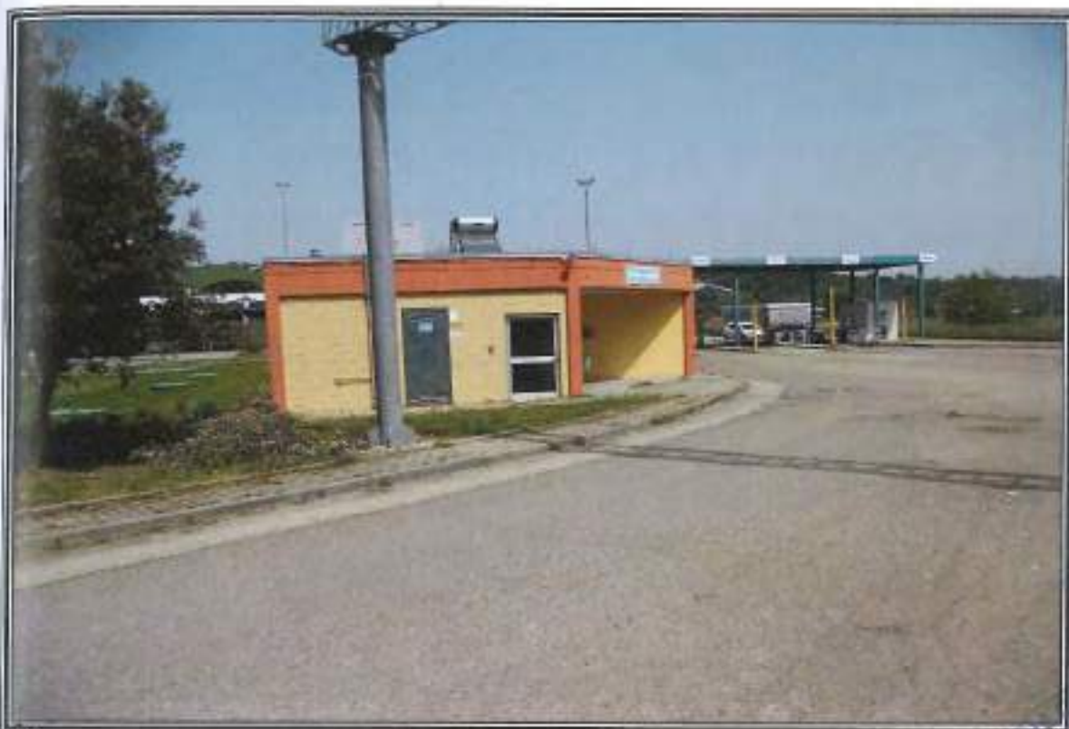
FOTOGRAFIA n. 1: Vista Esterna Centro Ingressi (CI)
