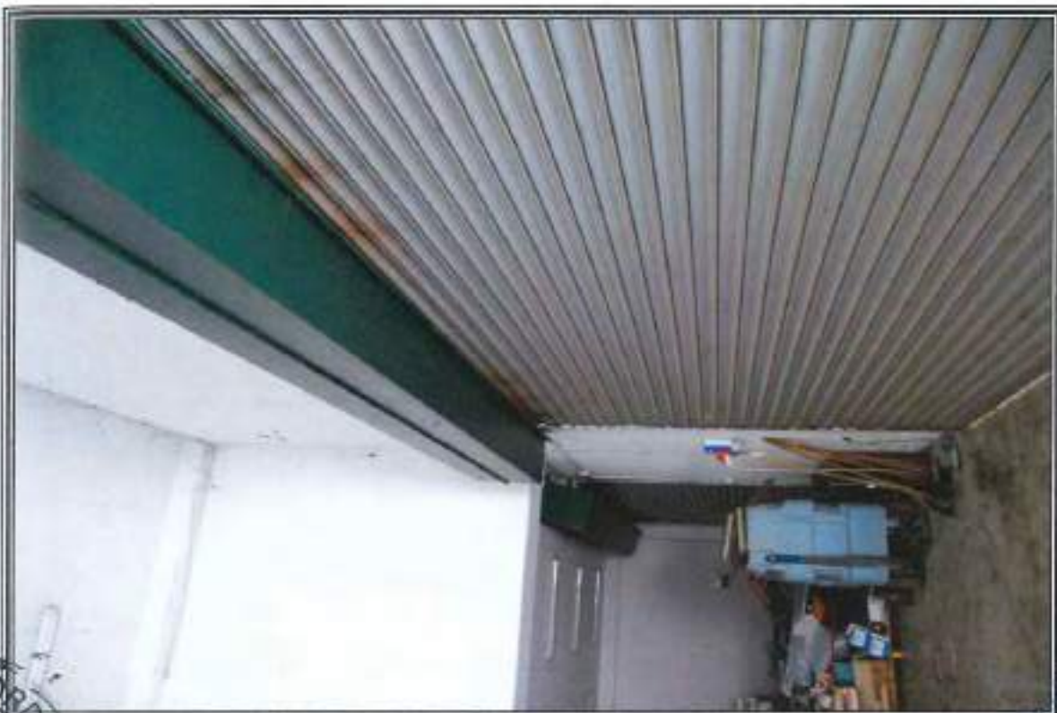
FOTOGRAFIA n. 5: Vista Interna Area Manutenzione e Pulizie (MP)
