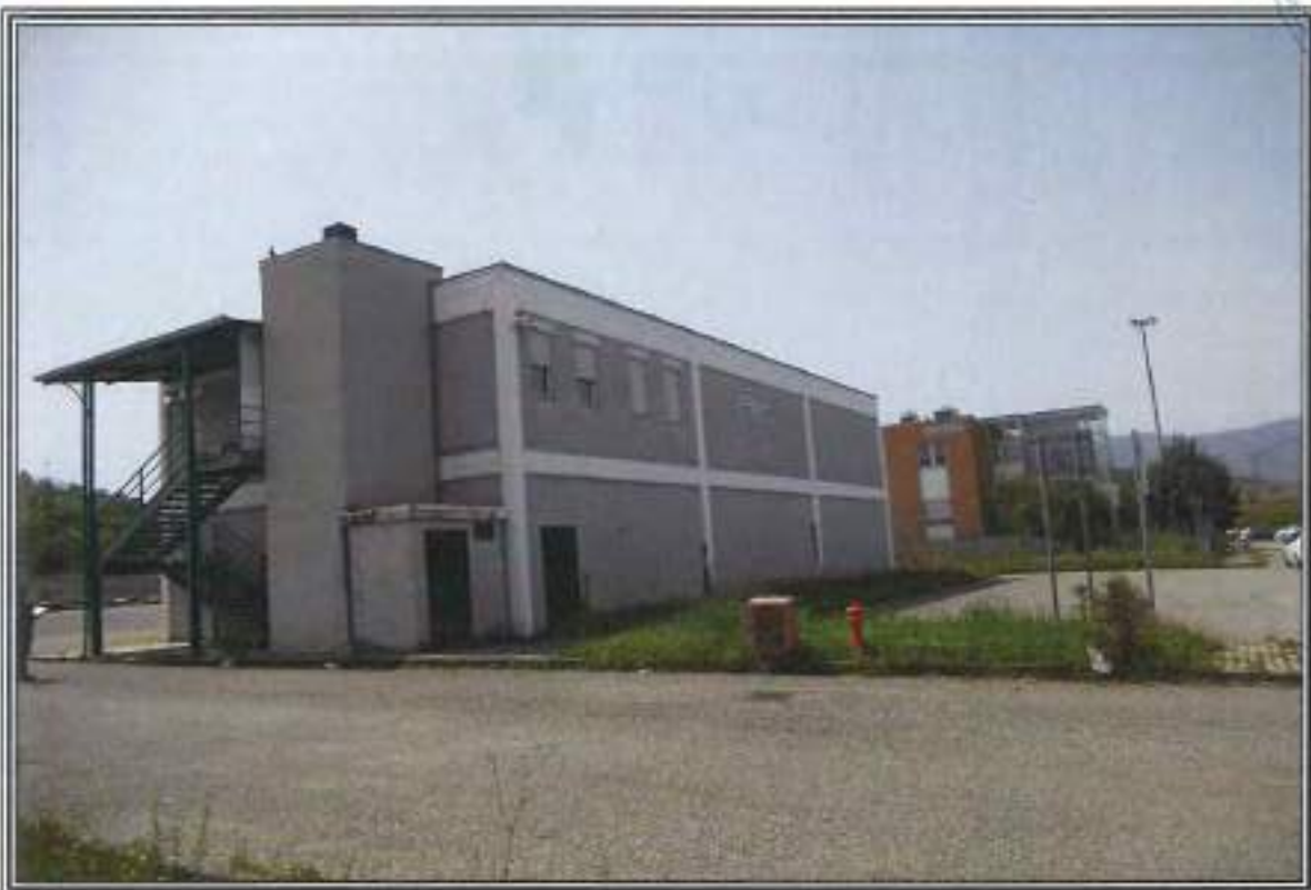
FOTOGRAFIA n. 2: Vista Esterna Area Manutenzione e Pulizie (MP)
