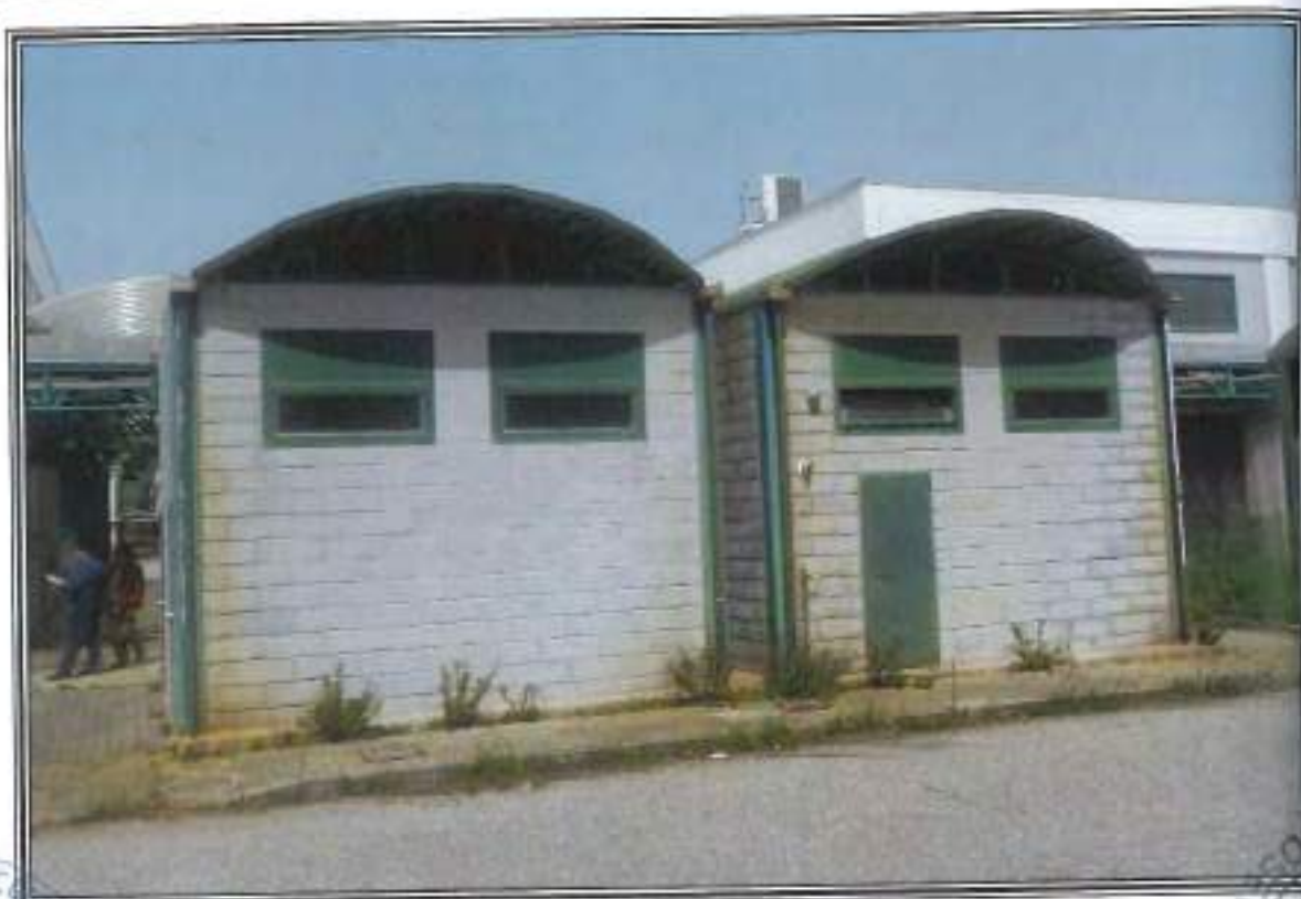
FOTOGRAFIA n. 3: Vista Esterna Area Mercato Altre Merceologie (AM)
