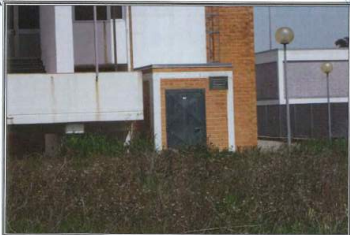
FOTOGRAFIA n. 6: Vista Esterna Area Servizi Generali (SG)
