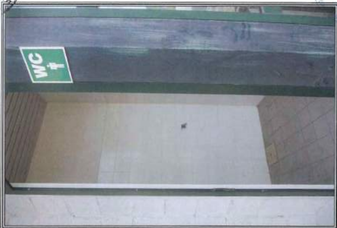
FOTOGRAFIA n. 18: Vista Interna Area Mercato Ortofrutticolo (MO)
