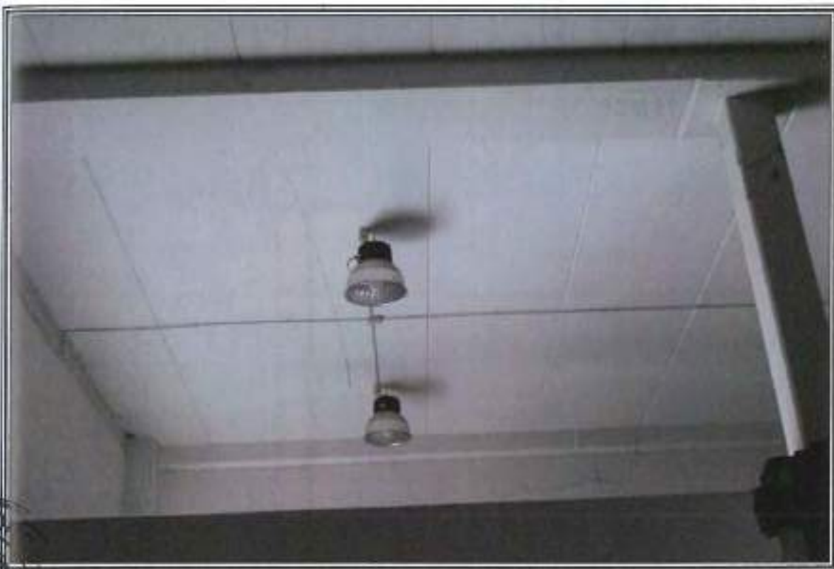
FOTOGRAFIA n. 13: Vista Interna Area Manutenzione e Pulizie (MP)
