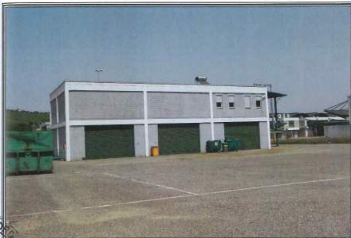
FOTOGRAFIA n. 9: Vista Esterna Area Manutenzione e Pulizie (MP)
