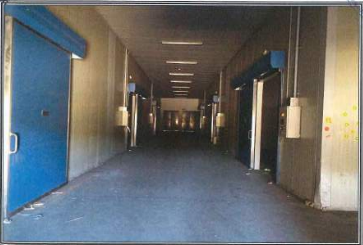
FOTOGRAFIA n. 6: Vista Interna Magazzini Frigoriferi (MF)
