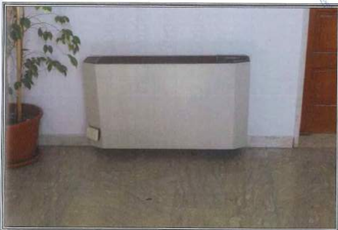
FOTOGRAFIA n. 18: Vista Interna Sede Sociale (AS)
