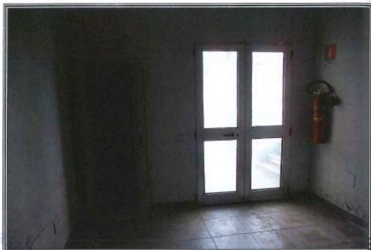
FOTOGRAFIA n. 7: Vista Interna Area Manutenzione e Pulizie (MP)
