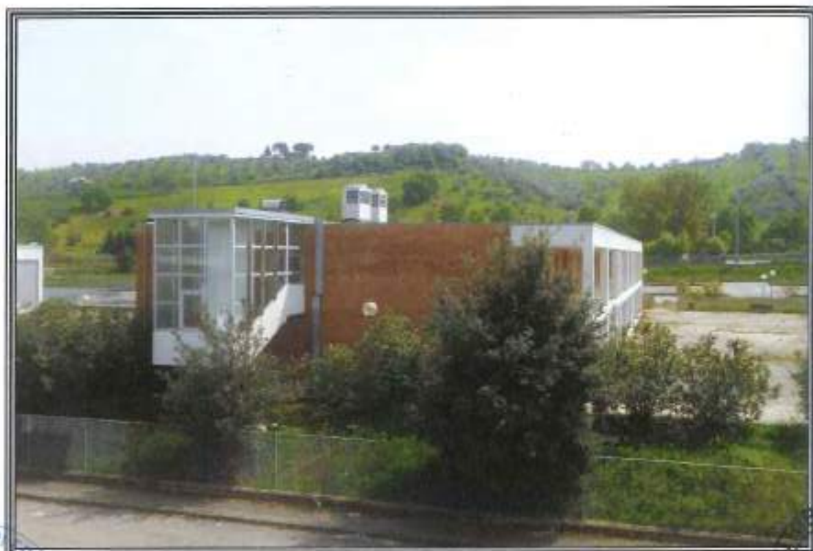
FOTOGRAFIA n. 3: Vista Esterna Area Servizi Generali (SG)
