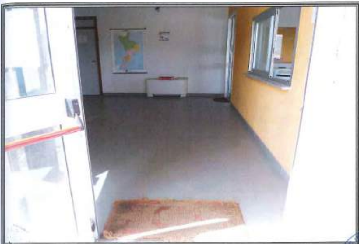
FOTOGRAFIA n. 5: Vista Interna Centro Ingressi (CI)
