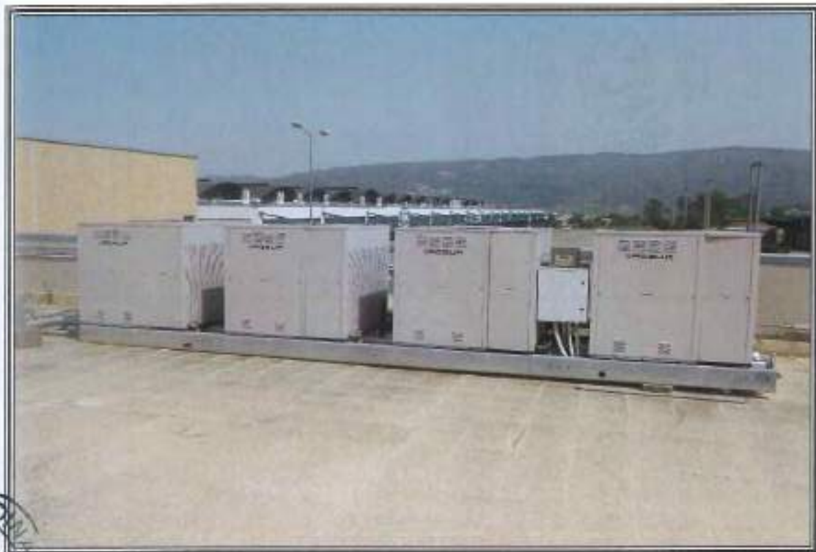
FOTOGRAFIA n. 17: Vista Esterna Magazzini Frigoriferi (MF)
