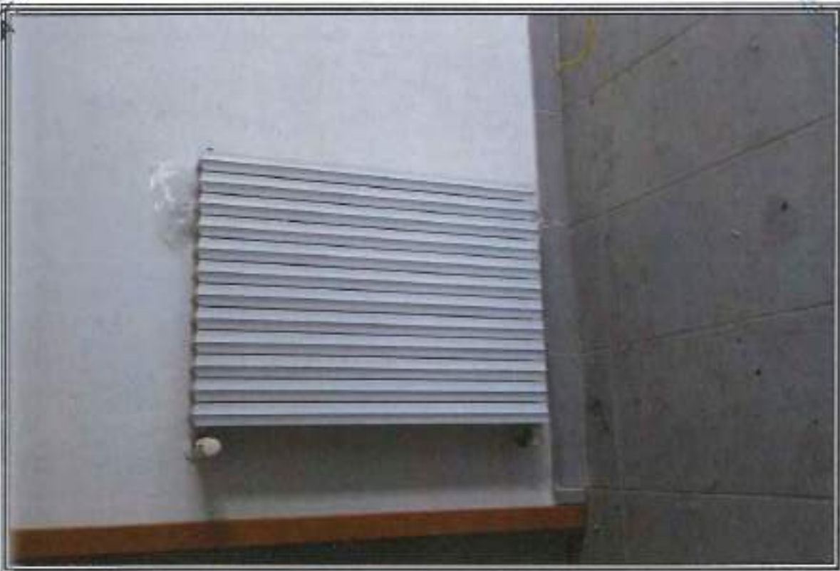
FOTOGRAFIA n. 6: Vista Interna Area Manutenzione e Pulizie (MP)
