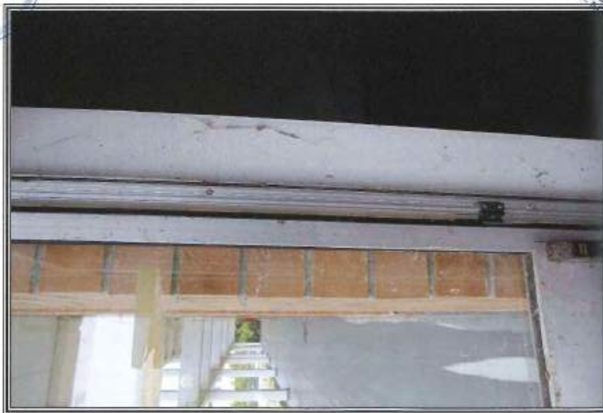
FOTOGRAFIA n. 8: Vista Esterna Area Servizi Generali (SG)
