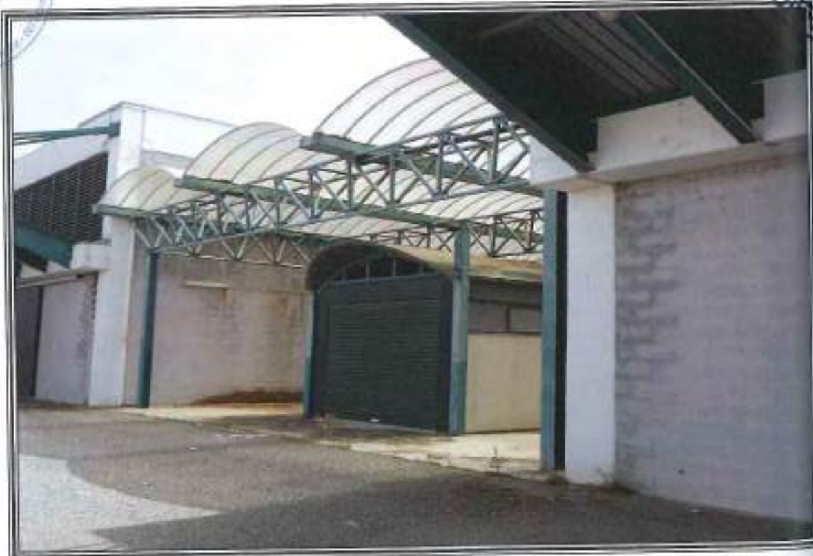
FOTOGRAFIA n. 4: Vista Esterna Area Mercato Altre Merceologie (AM)
