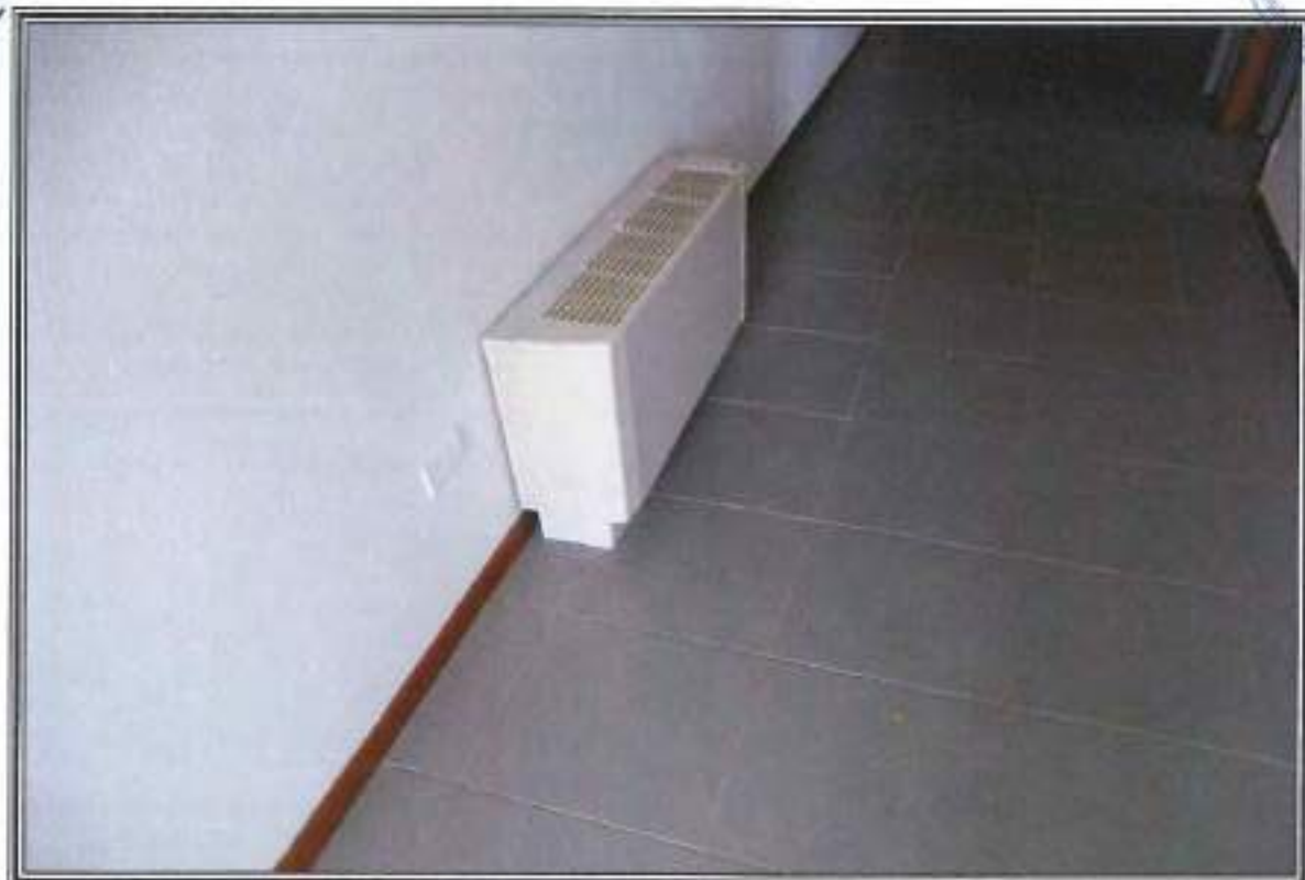
FOTOGRAFIA n. 18: Vista Interna Area Servizi Generali (SG)
