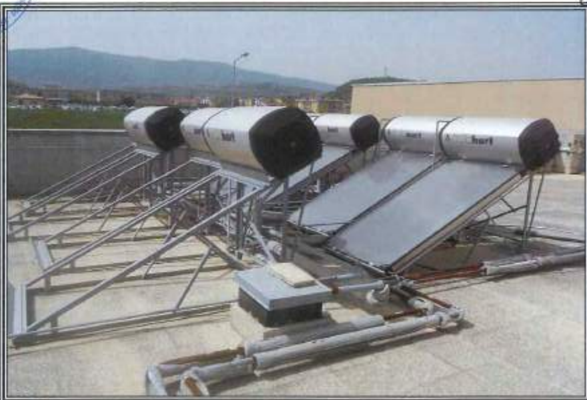
FOTOGRAFIA n. 16: Vista Esterna Magazzini Frigoriferi (MF)
