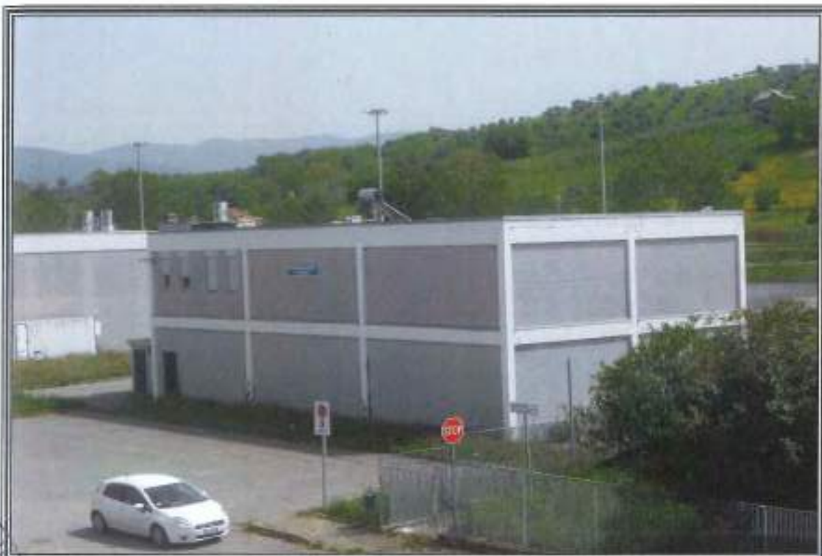
FOTOGRAFIA n. 1: Vista Esterna Area Manutenzione e Pulizie (MP)
