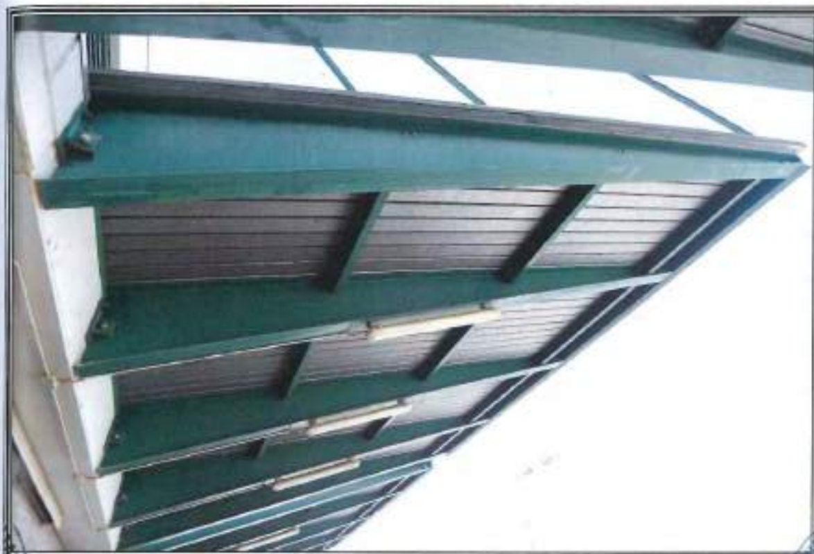
FOTOGRAFIA n. 9: Vista Esterna Area Mercato Altre Merceologie (AM)
