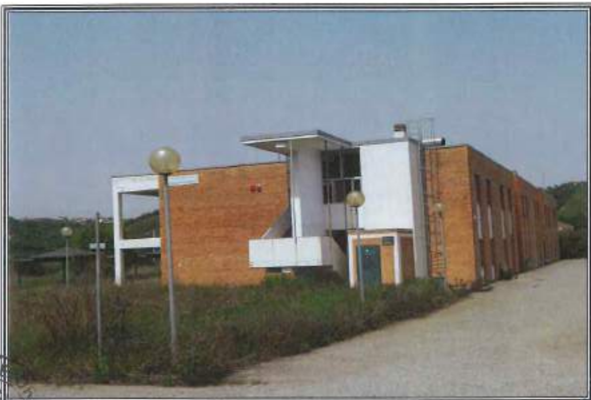
FOTOGRAFIA n. 1: Vista Esterna Area Servizi Generali (SG)
