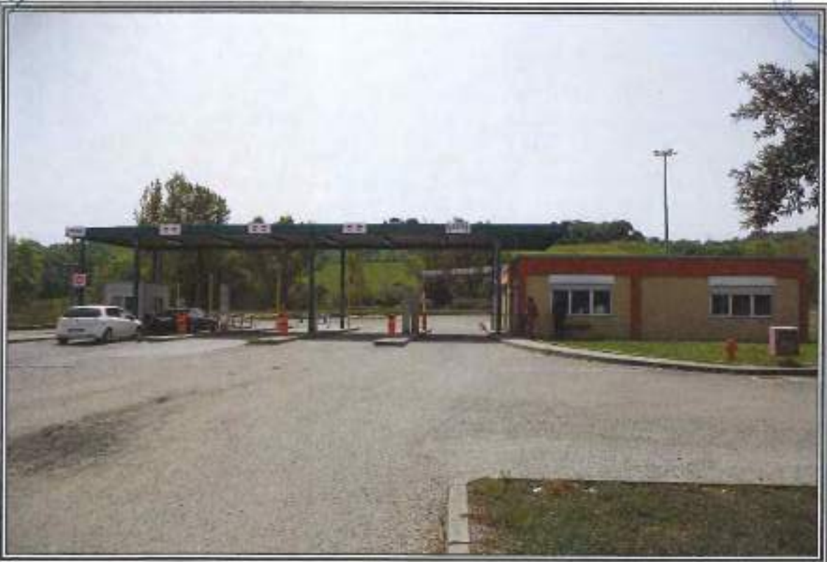
FOTOGRAFIA n. 2: Vista Esterna Centro Ingressi (CI)
