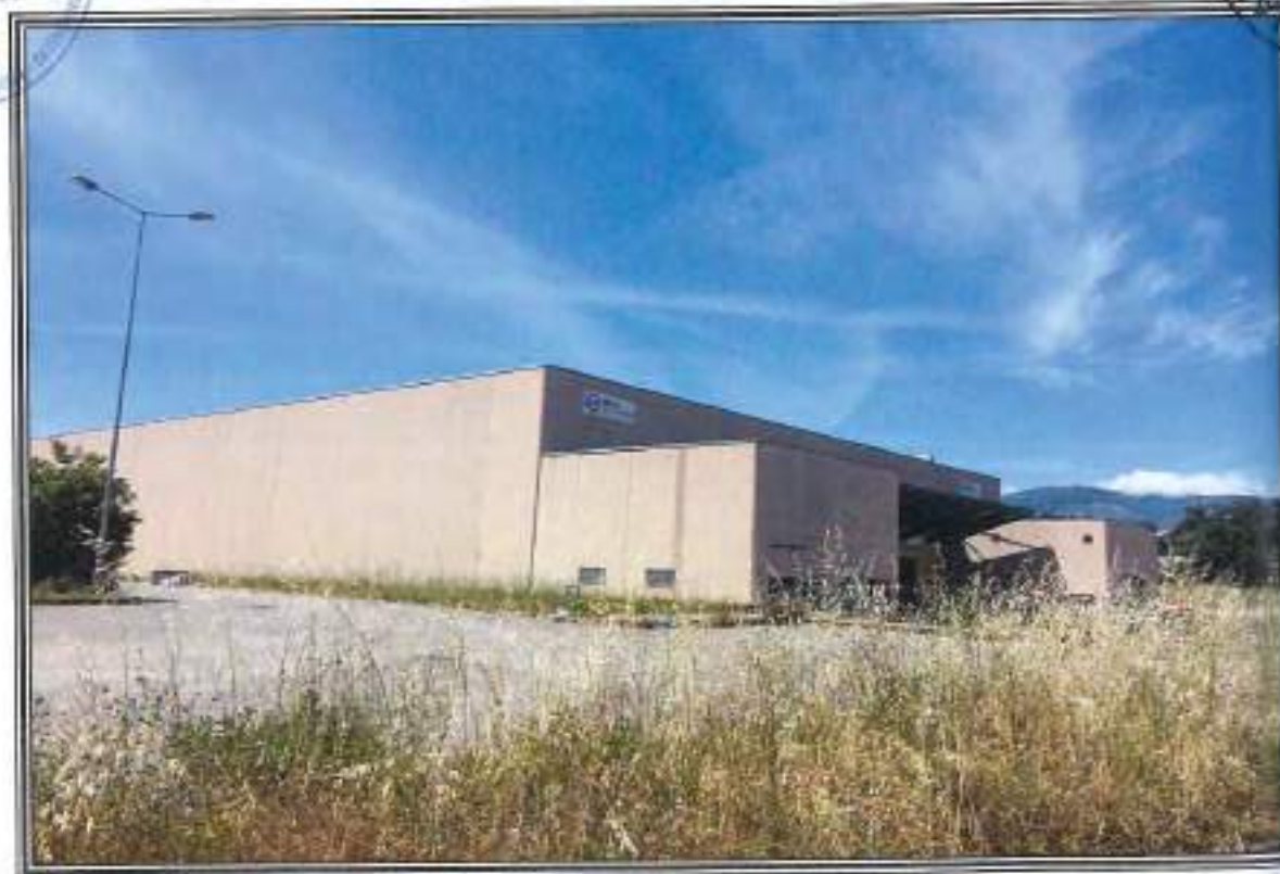
FOTOGRAFIA n. 4: Vista Esterna Magazzini Frigoriferi (MF)
