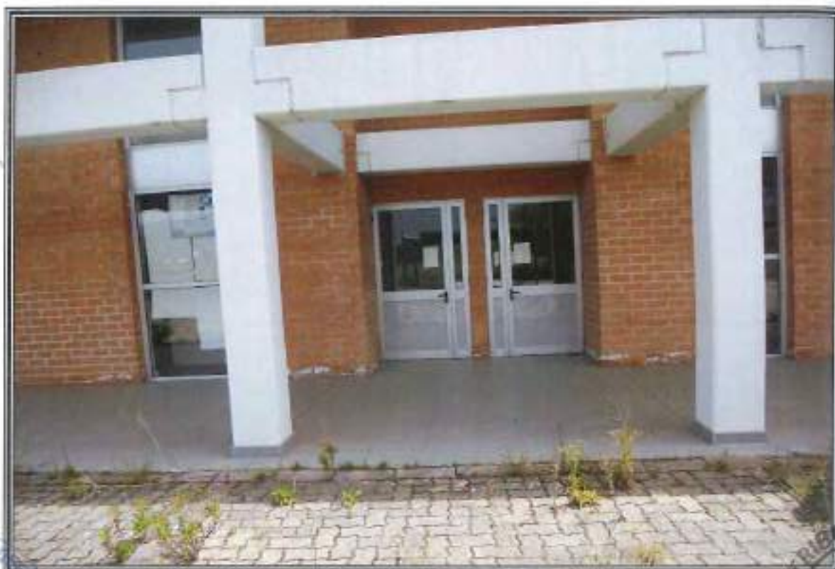
FOTOGRAFIA n. 7: Vista Esterna Area Servizi Generali (SG)
