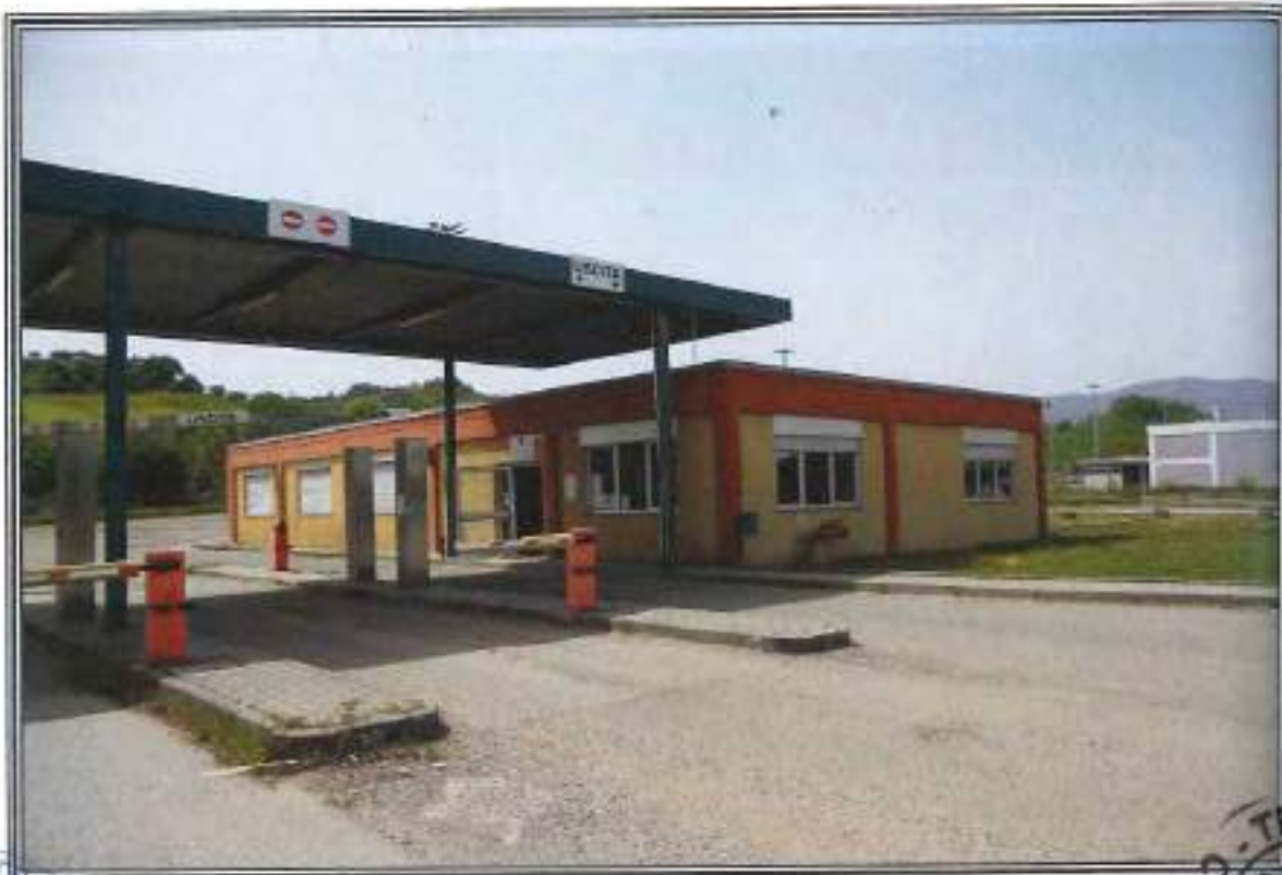
FOTOGRAFIA n. 3: Vista Esterna Centro Ingressi (CI)
