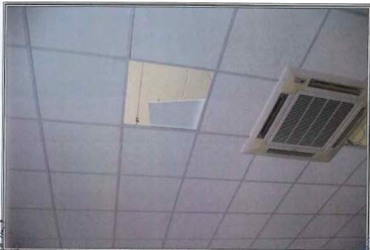
FOTOGRAFIA n. 21: Vista Interna Area Servizi Generali (SG)
