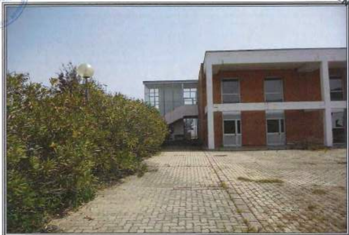
FOTOGRAFIA n. 4: Vista Esterna Area Servizi Generali (SG)
