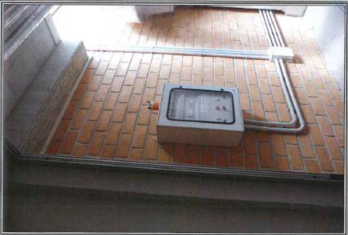
FOTOGRAFIA n. 16: Vista Interna Area Servizi Generali (SG)
