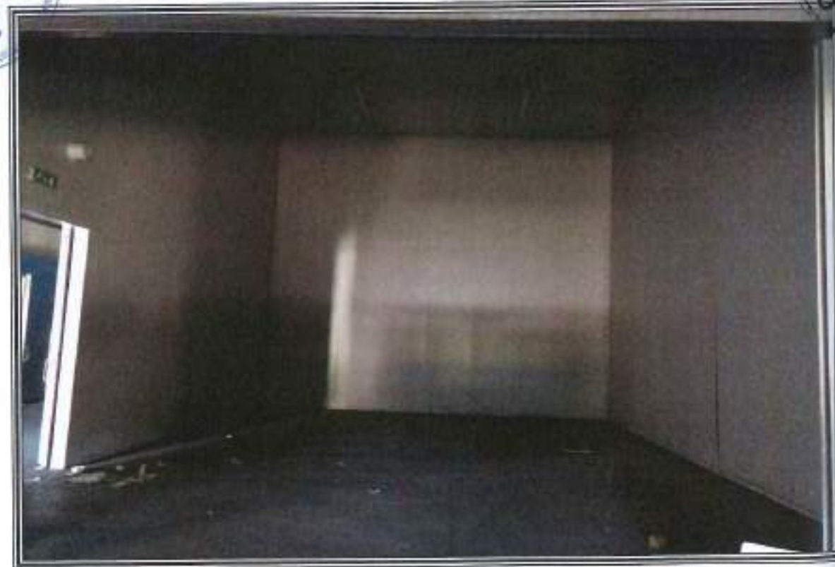
FOTOGRAFIA n. 8: Vista Interna Magazzini Frigoriferi (MF)
