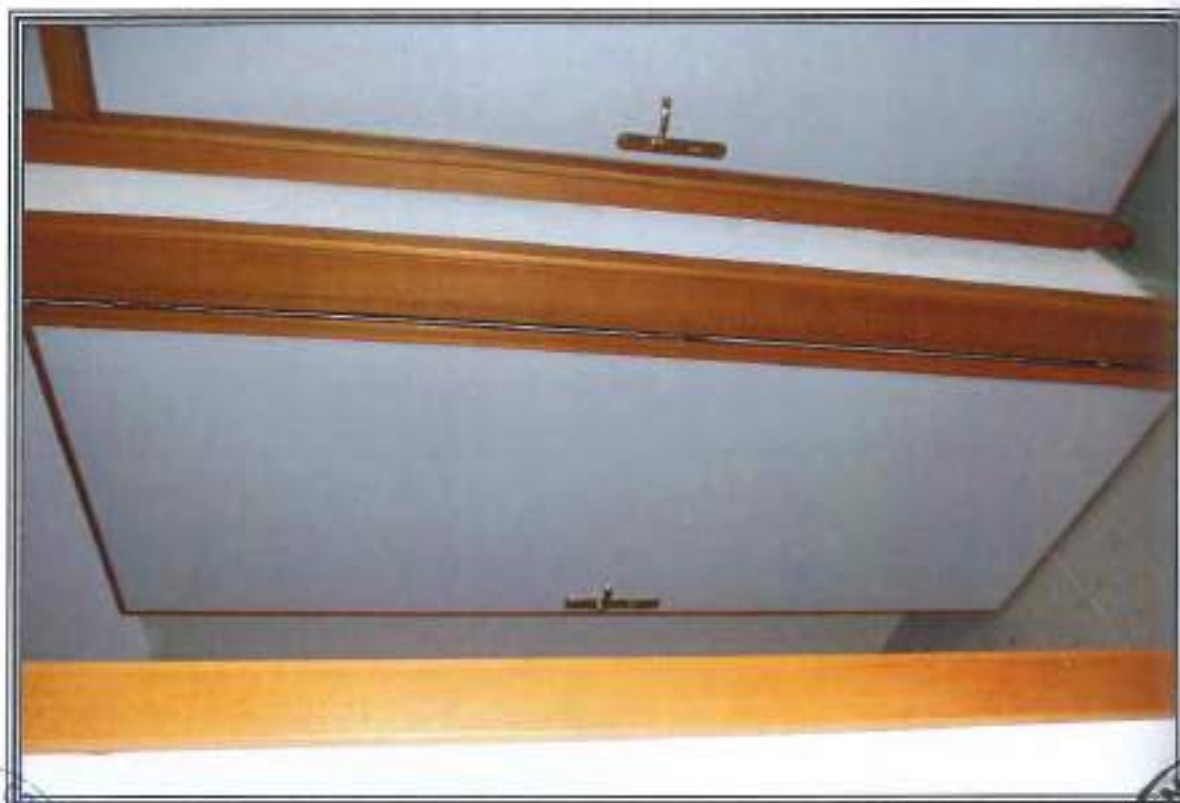
FOTOGRAFIA n. 11: Vista Interna Area Manutenzione e Pulizie (MP)
