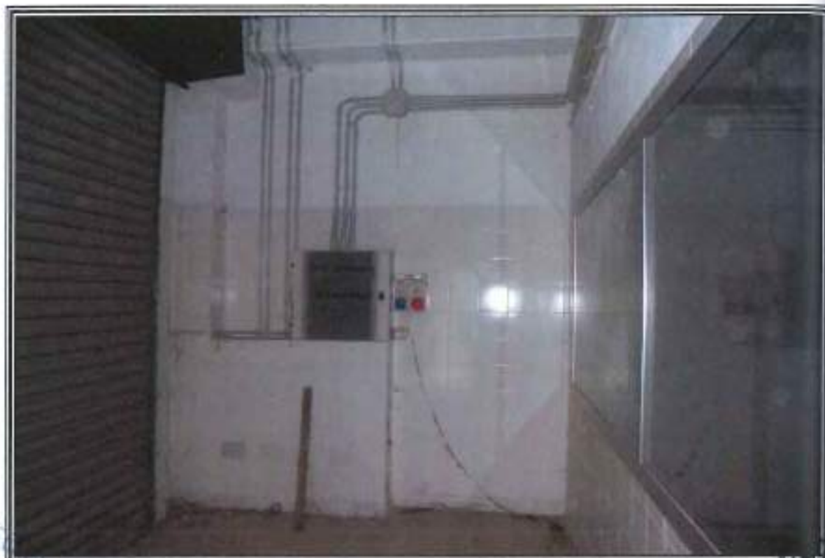
FOTOGRAFIA n. 15: Vista Interna Area Mercato Altre Merceologie (AM)
