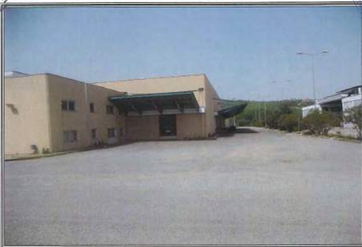
FOTOGRAFIA n. 2: Vista Esterna Magazzini Frigoriferi (MF)
