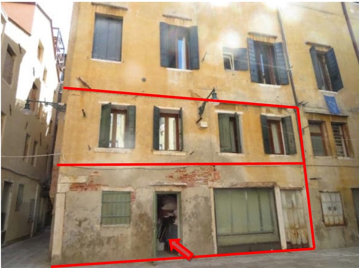
Esterno del fabbricato ed accesso al magazzino
