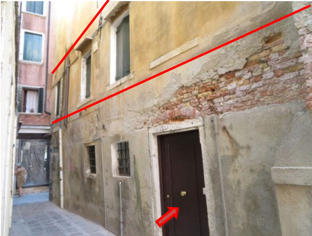
Esterno del fabbricato ed accesso all'abitazione
