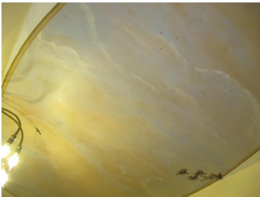
Particolare del soffitto del bagno
