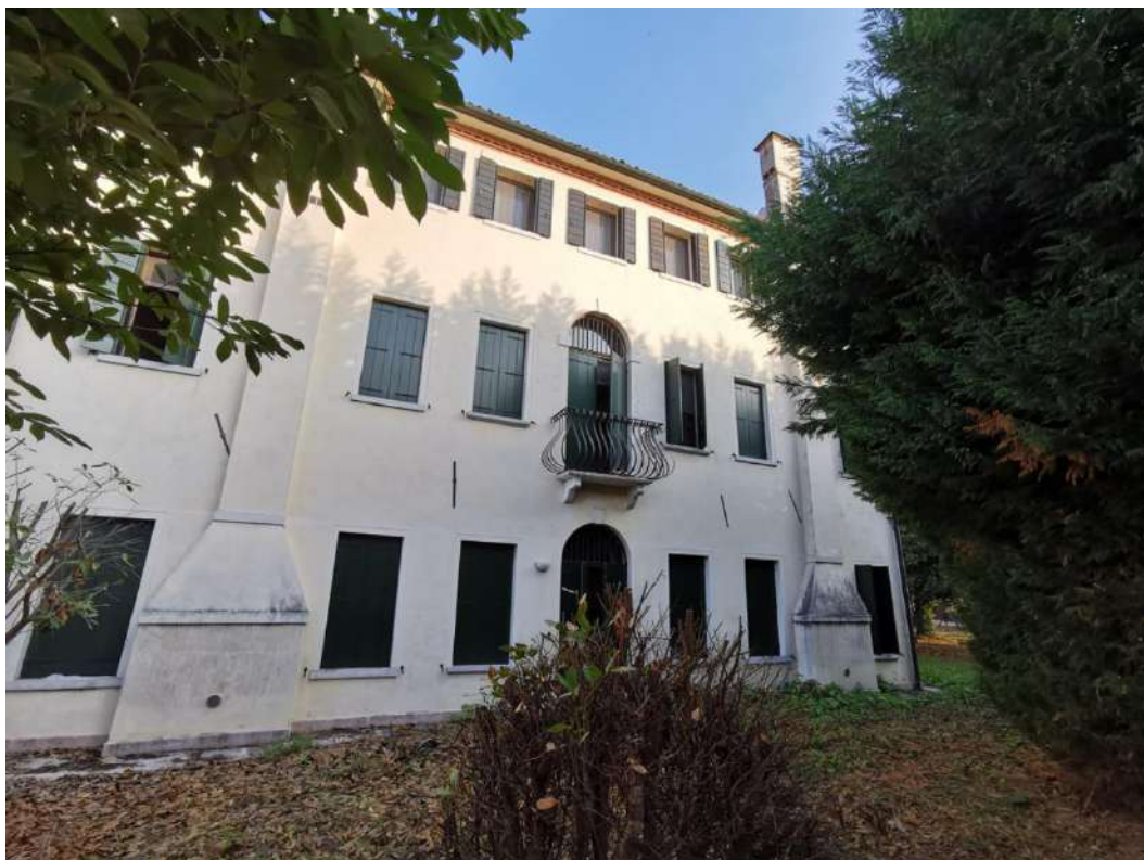
Foto n. 3: Panoramiche esterne fabbricato - fronte ovest
