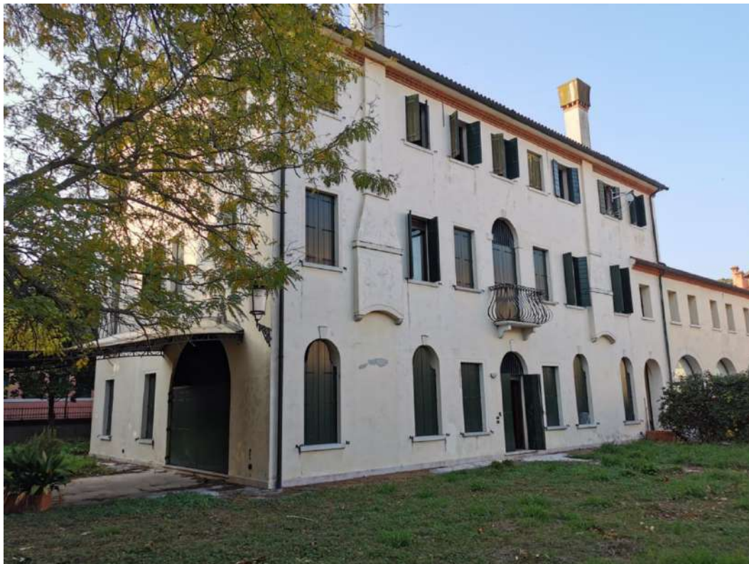
Foto n. 2: Panoramiche esterne fabbricato – fronte est
