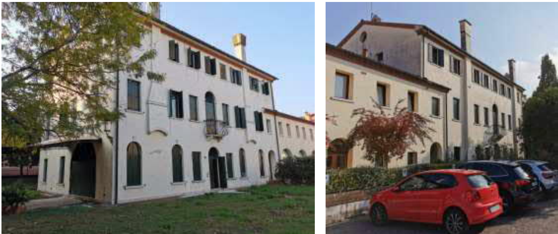
Foto n. 9_ Panoramica fabbricato oggetto di disamina
