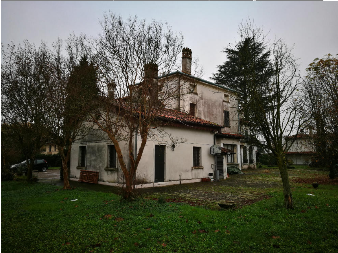
Casa unifamiliare ex casa del custode sopraelevata nel 1932 vista nord-ovest
