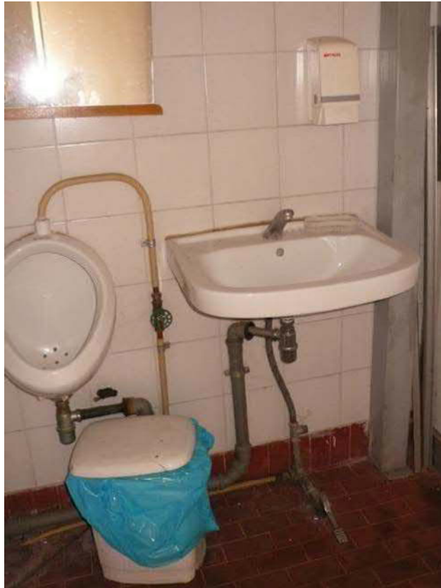
Foto n. 14 – capannone A (corpo imballaggio)
