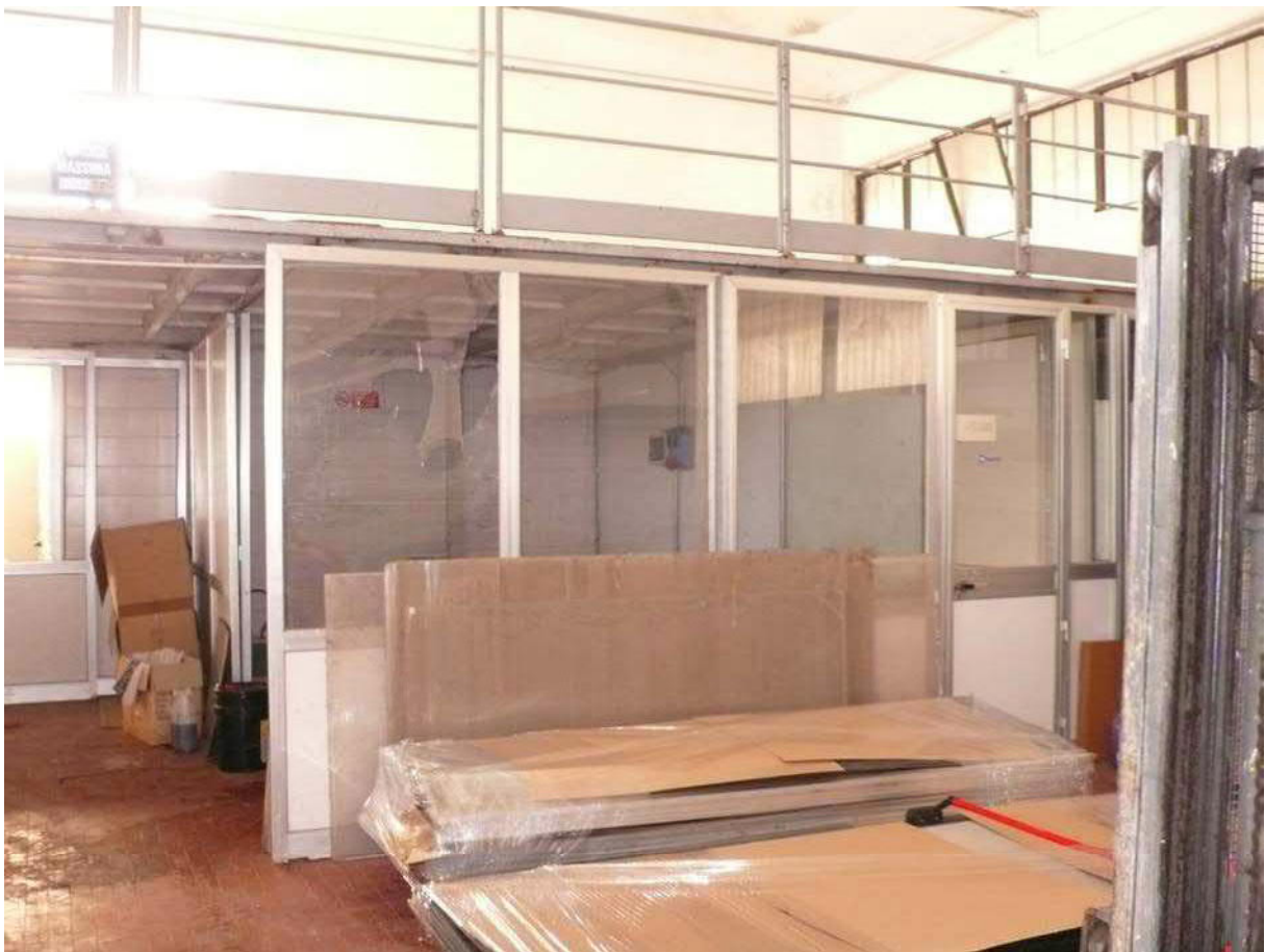
Foto n. 12 – capannone A (corpo imballaggio)
