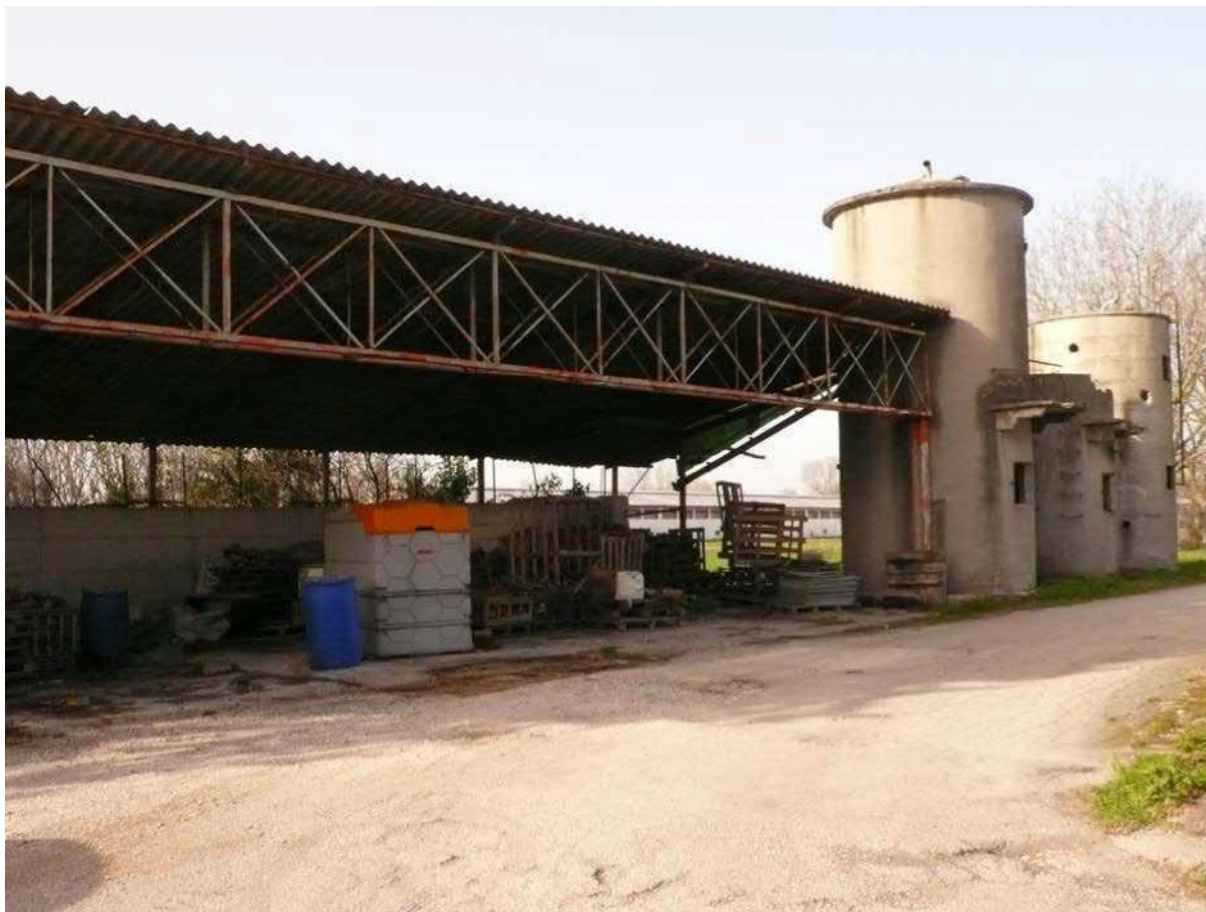
Foto n. 35 – tettoia/magazzino deposito mais e silos (mapp. 368/sub. 1)
