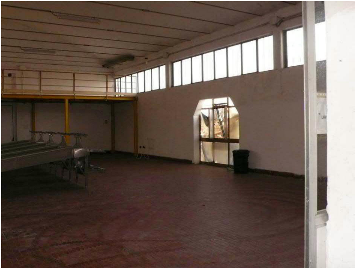
Foto n. 8 – capannone A (corpo imballaggio)
