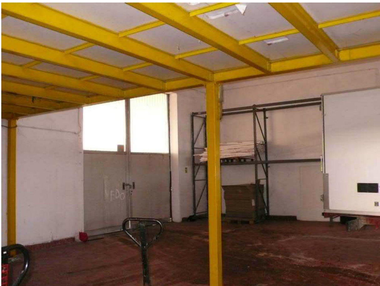
Foto n. 5 – capannone A (corpo imballaggio)
