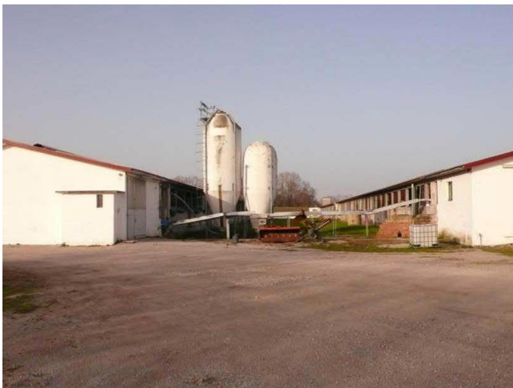
Foto n. 17 – a dx capannone A – a sx capannone B
