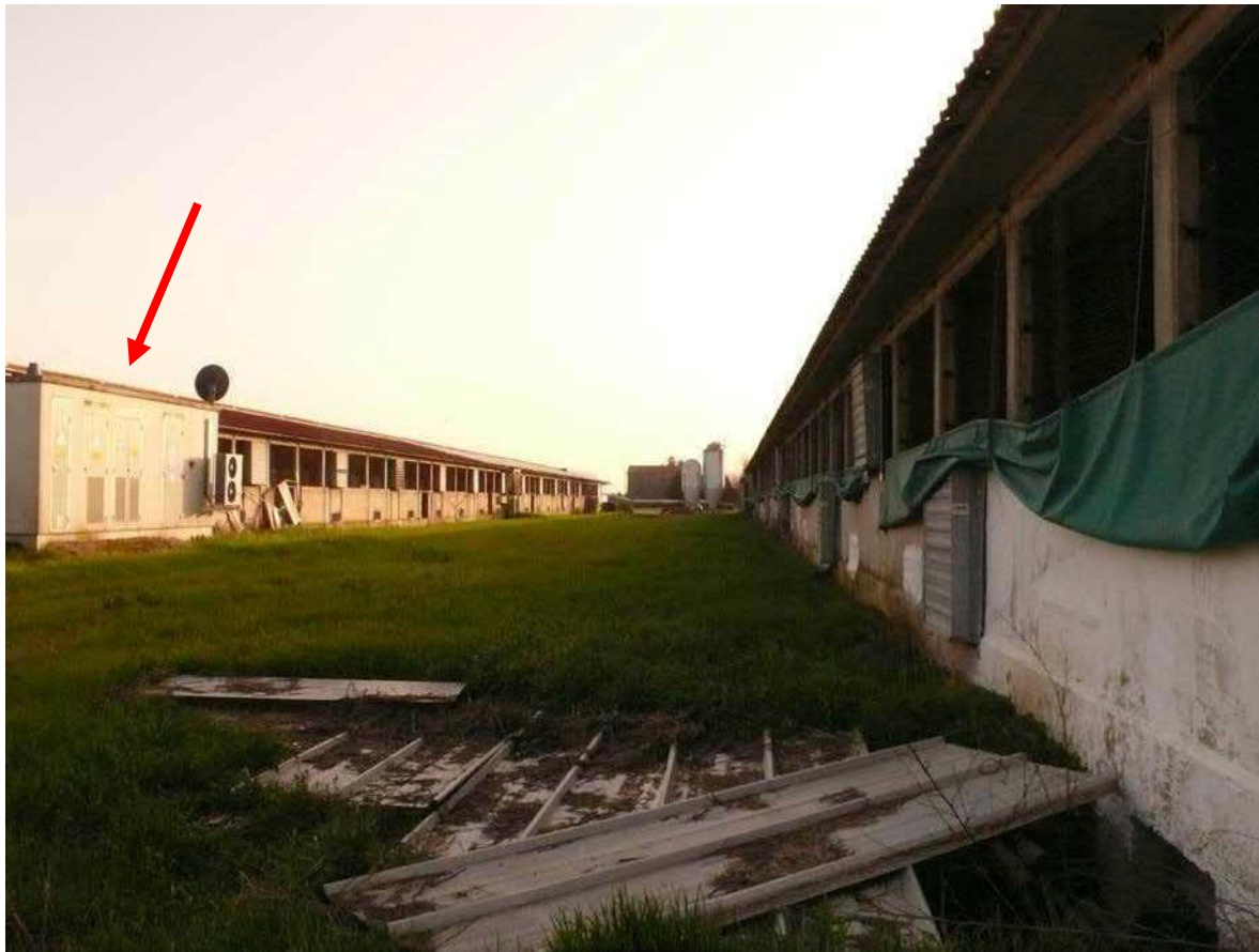
Foto n. 40 – cabina elettrica (mapp. 368/sub.2)
