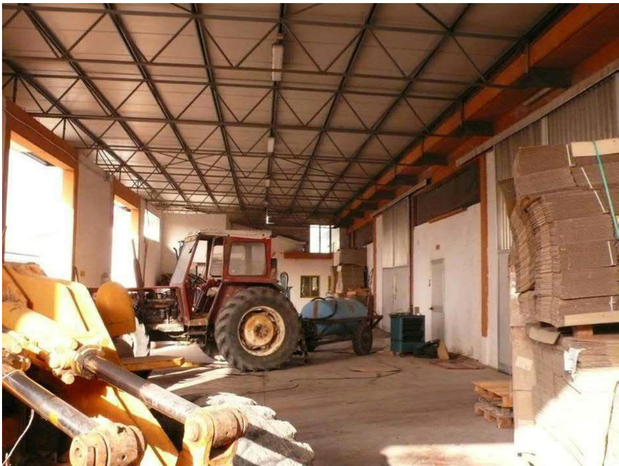
Foto n. 4 – capannone A (tettoia carico e scarico automezzi)
