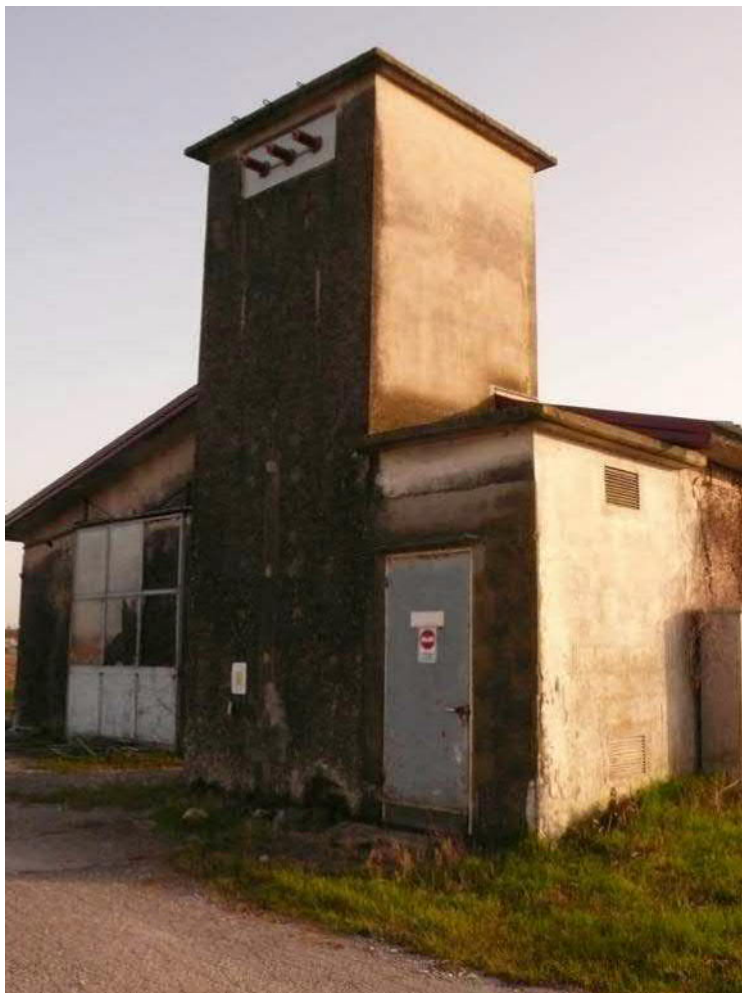
Foto n. 16 – capannone A (cabina elettrica a nord)
