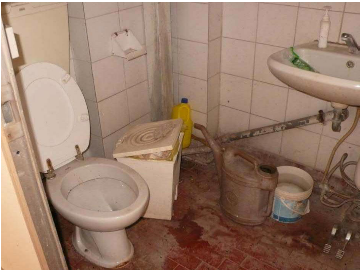
Foto n. 13 – capannone A (corpo imballaggio)
