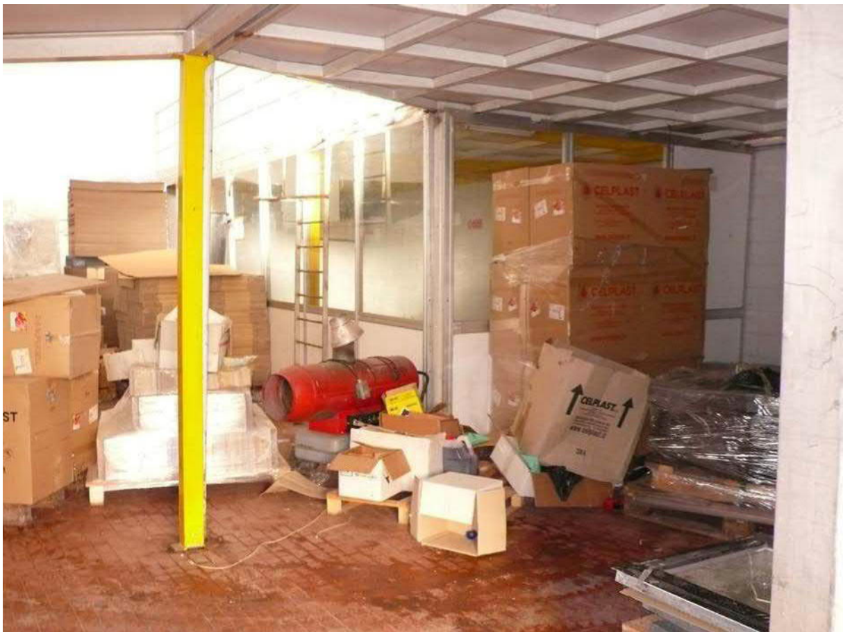
Foto n. 9 – capannone A (corpo imballaggio)
