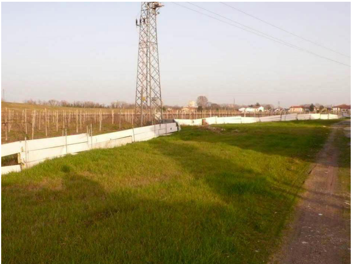
Foto n. 34 – recinzione lato nord
