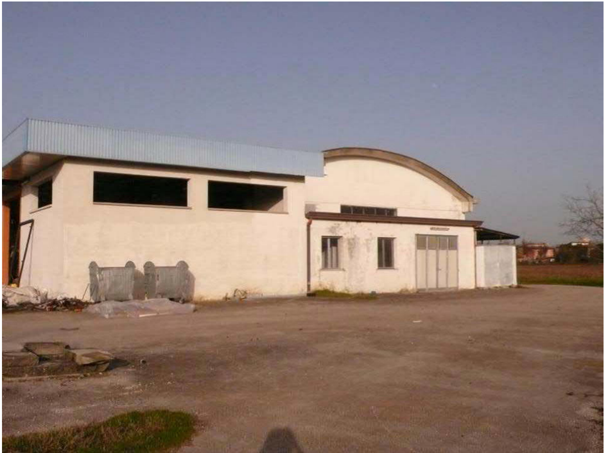
Foto n. 2 – capannone A (zona imballaggio)
