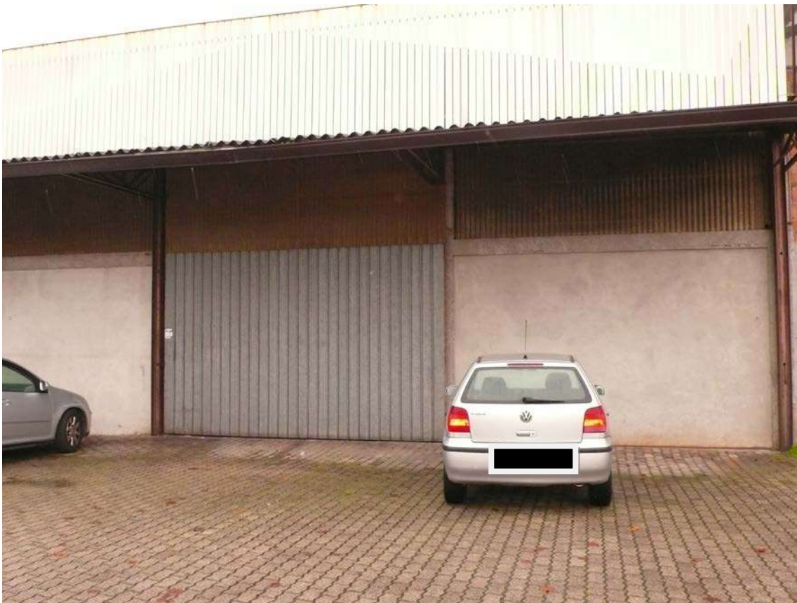
Foto n. 3 – MAGAZZINO (sub. 16) bene denominato 'G'
