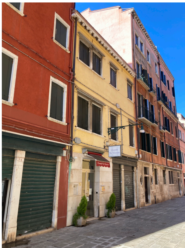
Foto esterna – Vista da Calle Priuli
