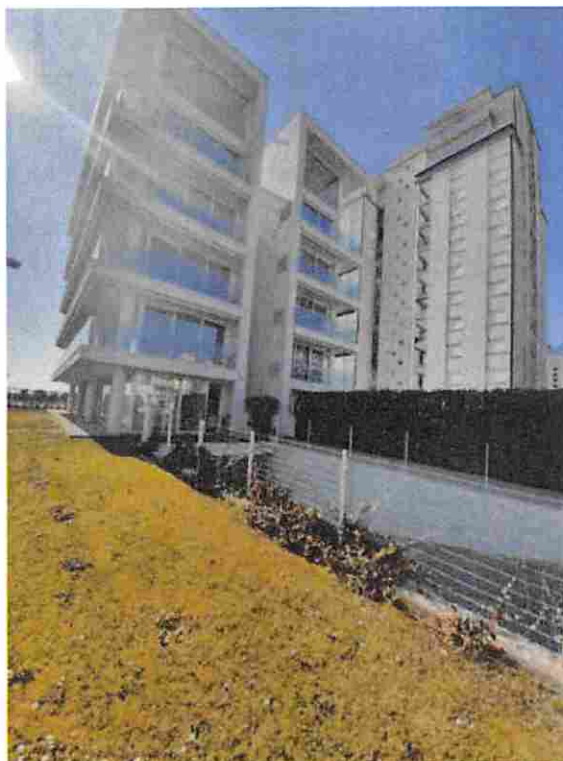
foto n. 1 - vista rampa esterna da via Treviso
