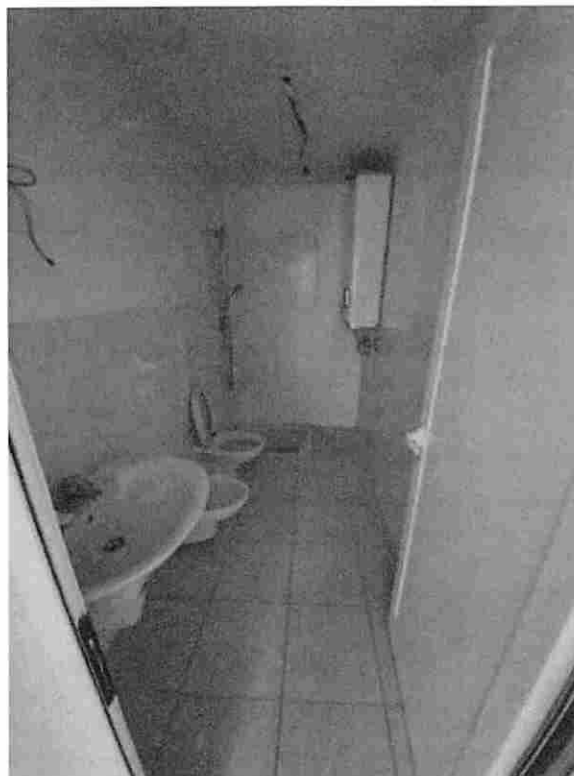
foto n. 6 – vista bagno magazzino
