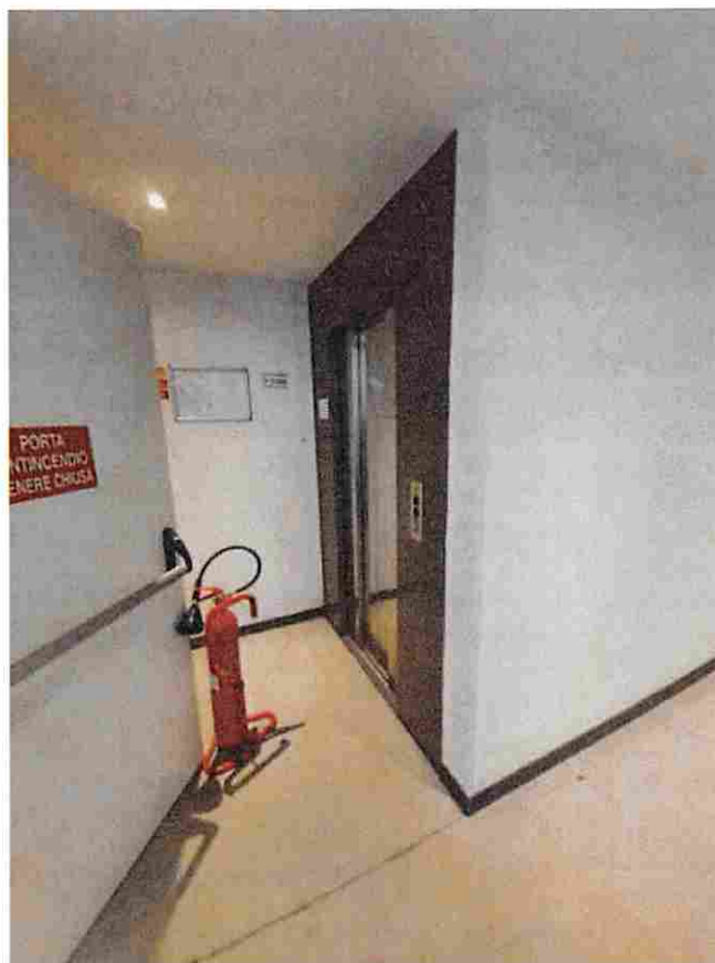
foto n. 4 - vista ascensore piano interrato
