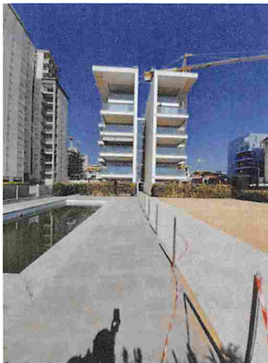
foto n. 1 - vista esterna da sud
