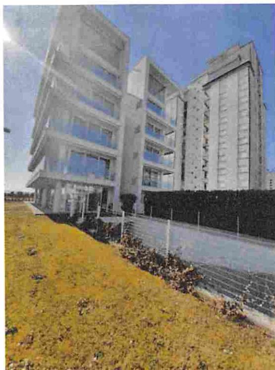
foto n. 2 - vista esterna fabbricato da sud
