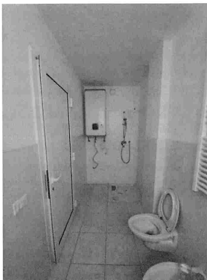
foto n. 7 - vista bagno magazzino
