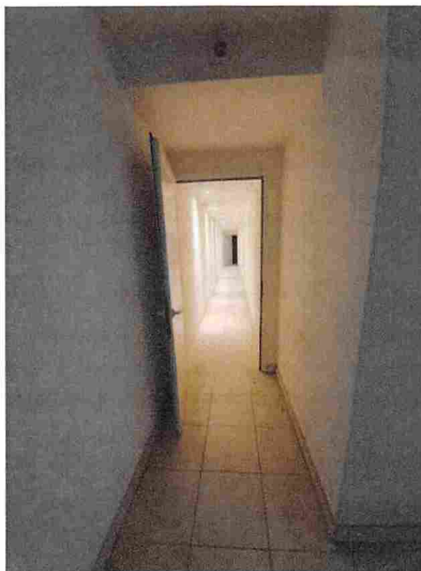
foto n. 8 – vista magazzino su corridoio
