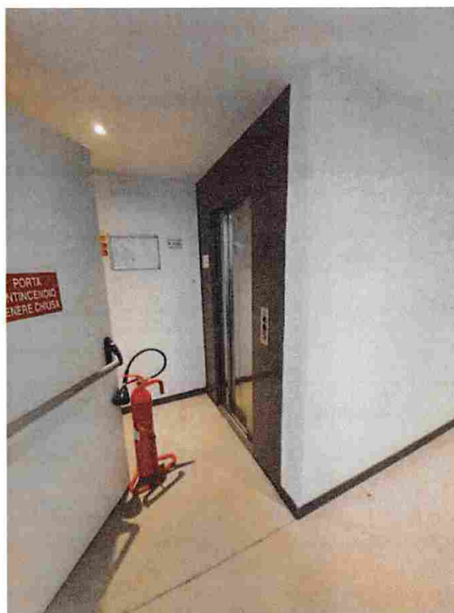
foto n. 4 - vista ascensore piano interrato
