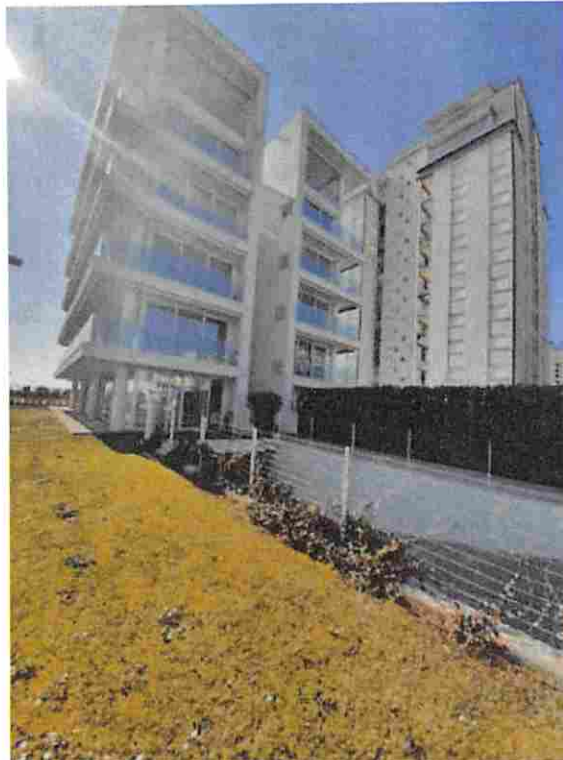
foto n. 1 - vista rampa esterna da via Treviso
