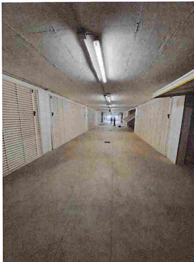
foto n. 3 - vista su corsia piano interrato
